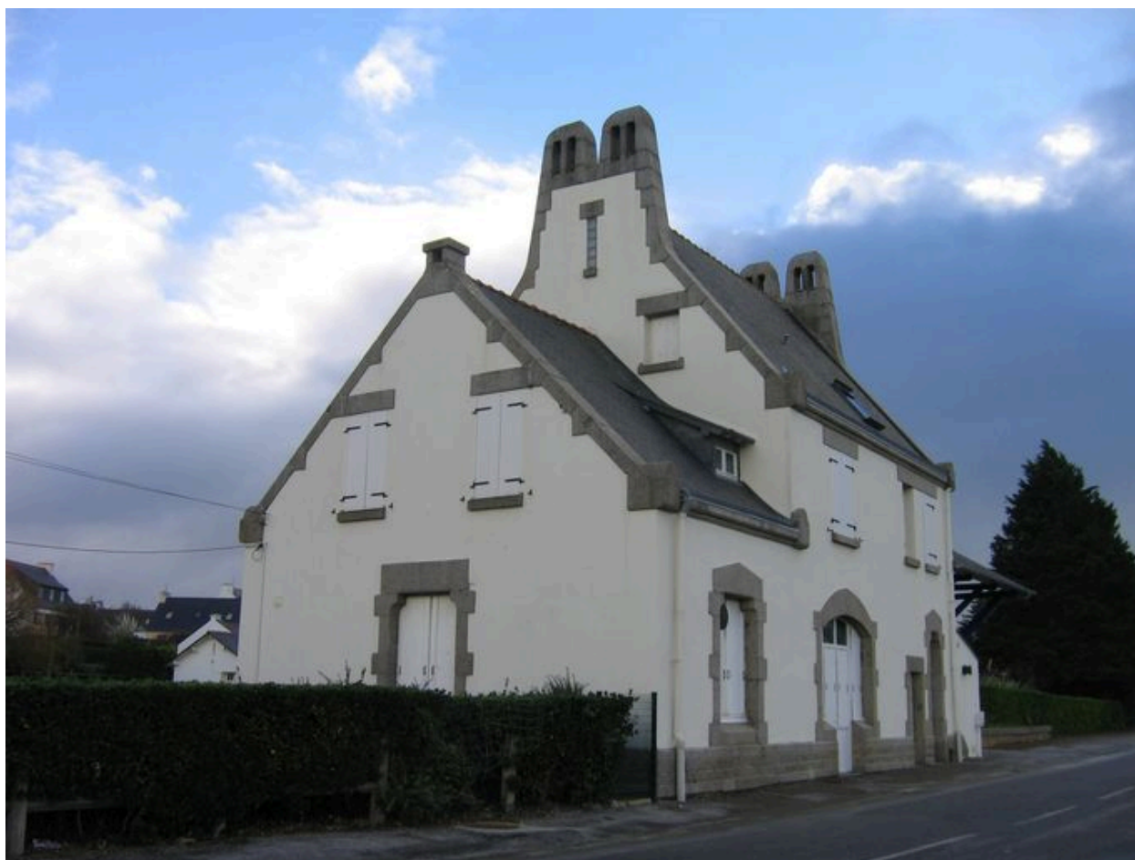
Vue générale de l'ancienne gare de Camaret prise depuis le nord
