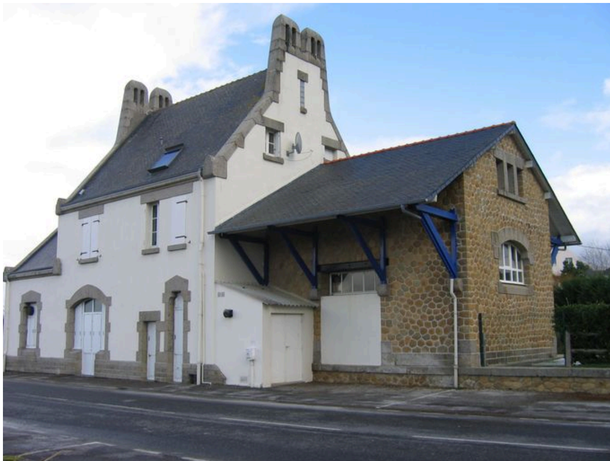
Vue générale de l'ancienne gare de Camaret prise depuis le sud
