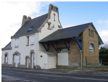
Vue générale de l'ancienne gare de Camaret prise depuis le sud Phot. Françoise Péron IVR53_20062908460NUCA
