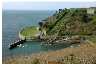
Plouzané : vue générale du fort du Mengant (4e quart 17e siècle) depuis Kerdalaëz Phot. Guillaume Lécueillier IVR53_20062907353NUCA
