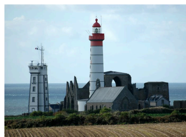
Plougonvelin : vue de l'abbaye et du sémaphore de la pointe Saint-Mathieu Phot. Guillaume Lécueillier IVR53_20042903862NUCA
