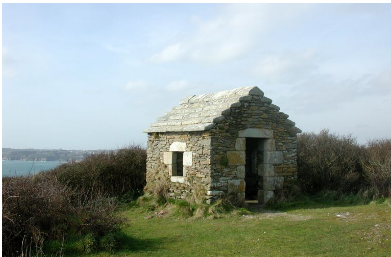
Locmaria-Plouzané : vue générale du corps de garde de Neiz Vran, le Moulin de Ru Vras
