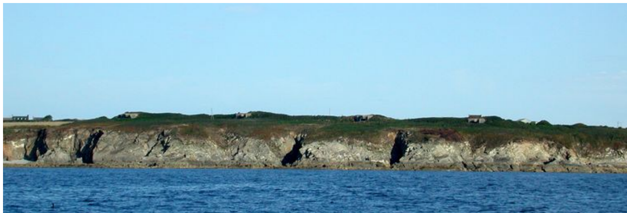
Plougonvelin : vue générale de la batterie lourde des Rospects depuis la mer
