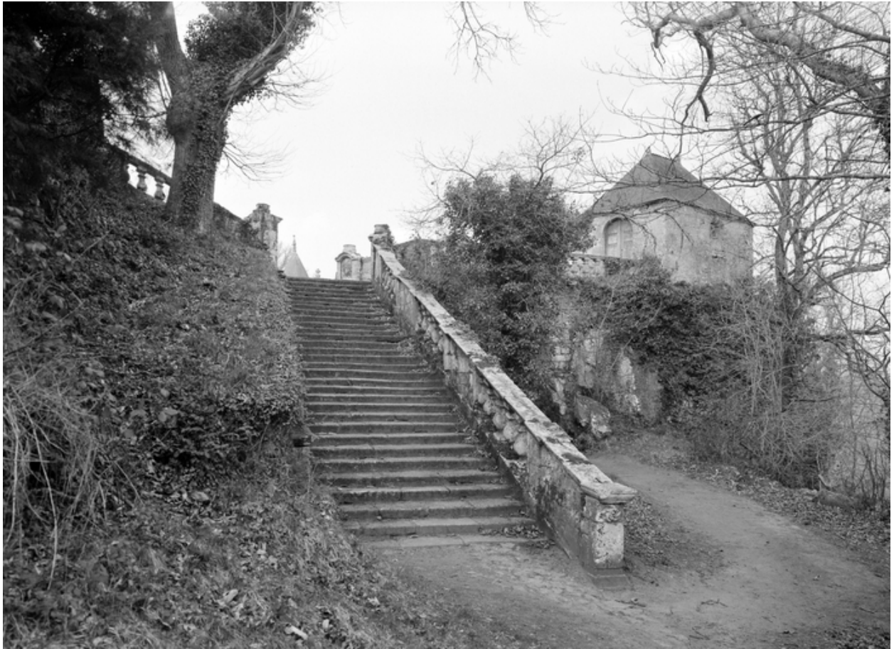
Volée nord des escaliers.
