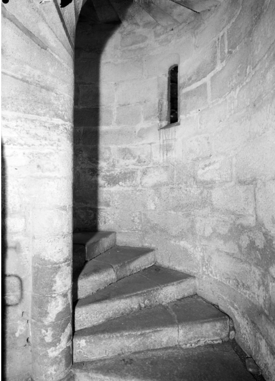
Intérieur de la tourelle d'escalier.
