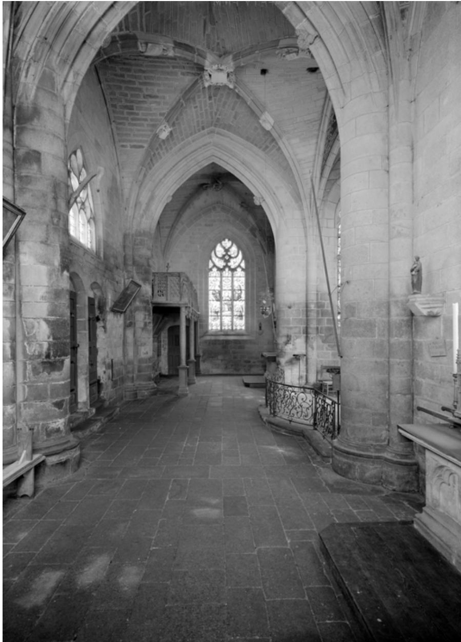
Vue générale du vaisseau transversal du sud vers le nord.
