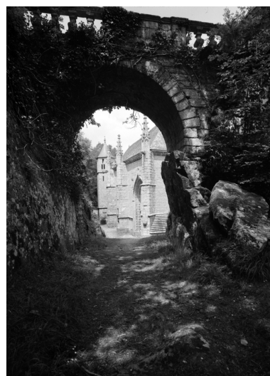
Vue générale du pont et de la chapelle. Phot. François Dagorn IVR53_19665600109V
