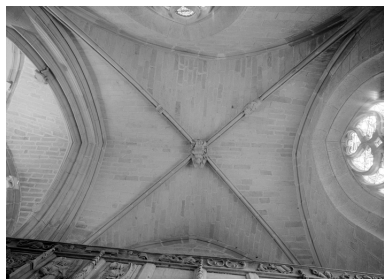
Croisillon nord, vue axiale de la voûte. Phot. François Dagorn IVR53_19665600121V
