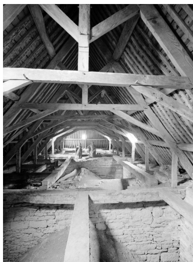
Vue générale de la charpente. Phot. François Dagorn
