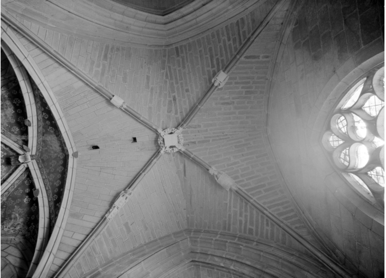
Croisée du transept, vue axiale de la voûte.
