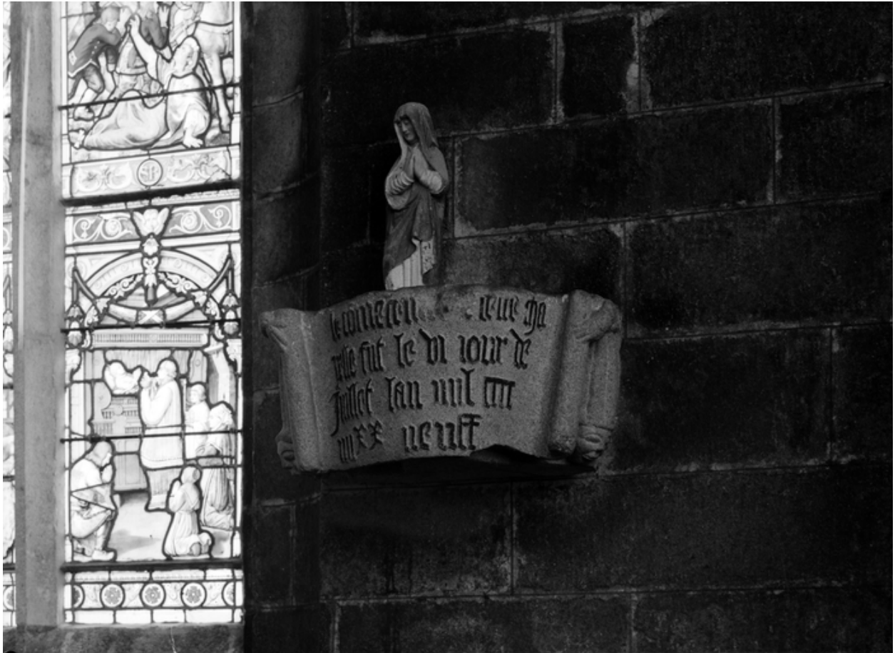
Croisillon sud, mur est, console.
