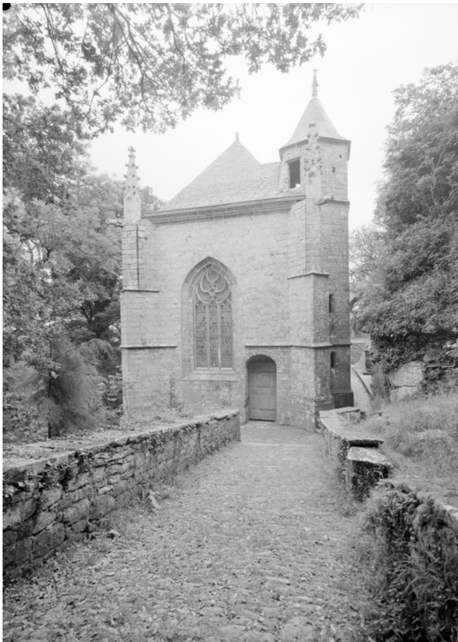
Façade nord, vue générale.
