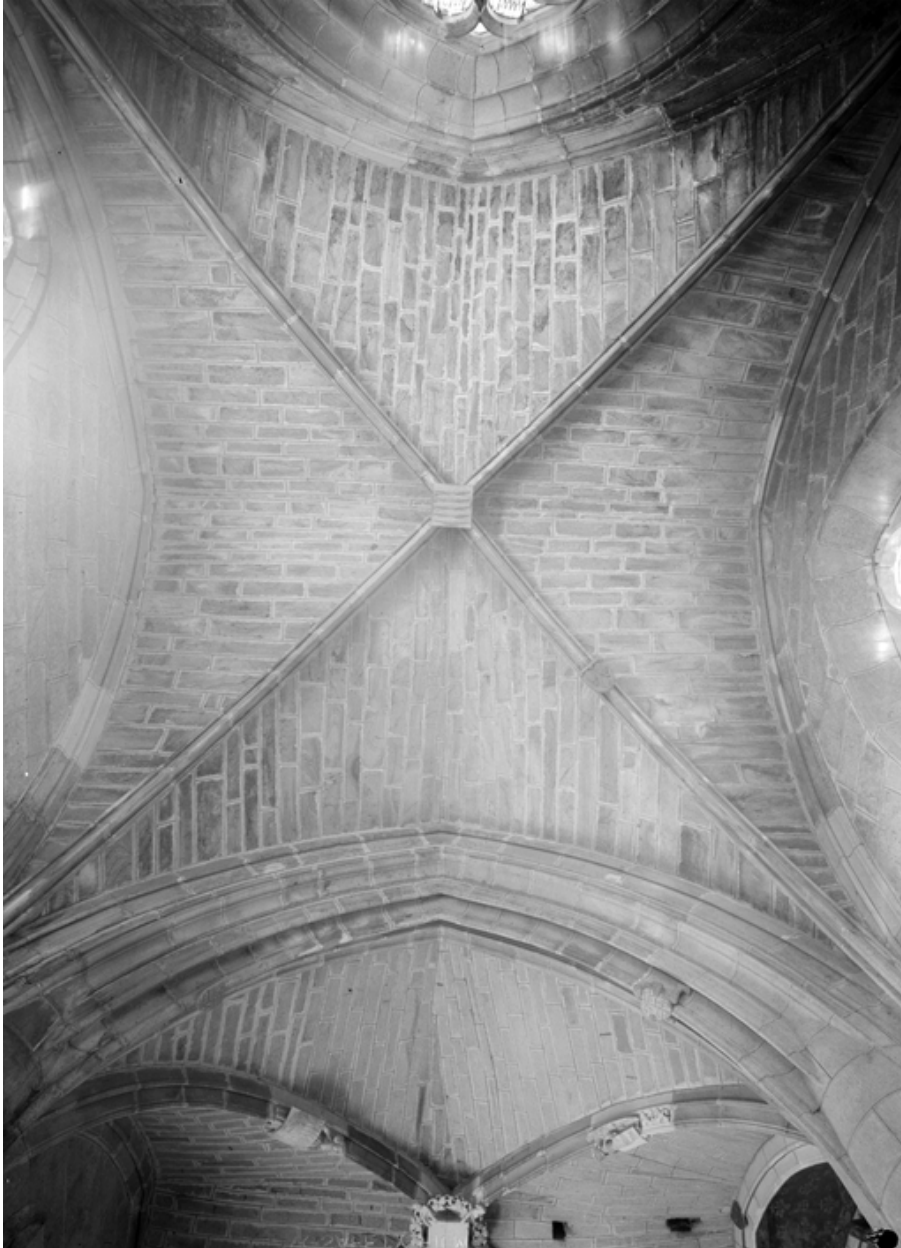
Croisillon sud, vue axiale de la voûte.
