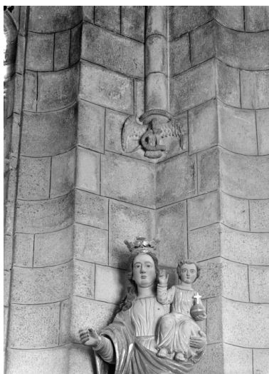
Choeur, cul-de-lampe à la retombée de la nervure sud-est. Phot. François Dagorn IVR53_19665600114V
