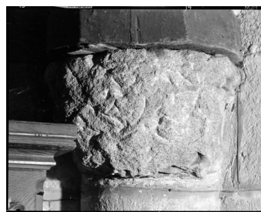
Console à l'angle sud-est du chœur. Phot. François Dagorn IVR53_19705600105X
