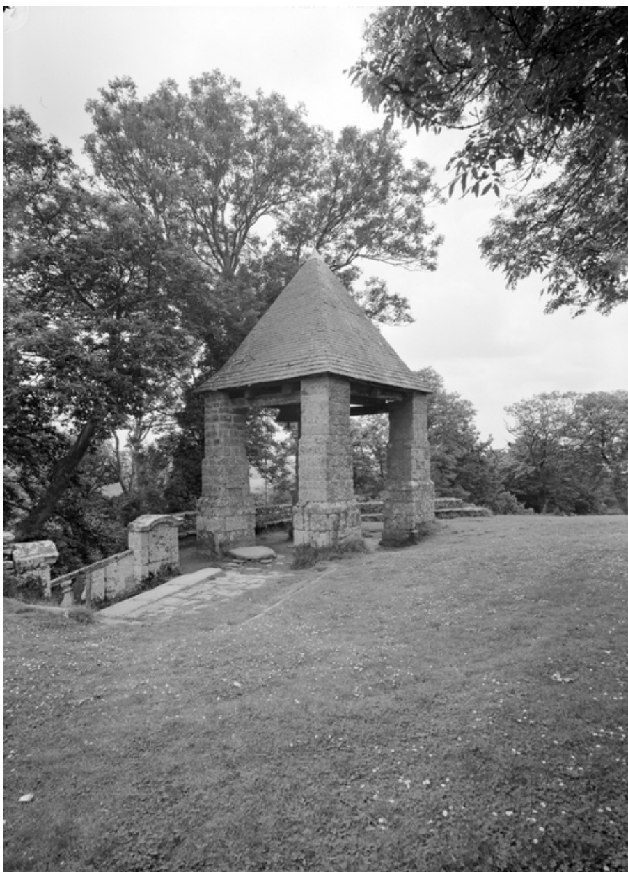
Clocher au haut du degré sud.
