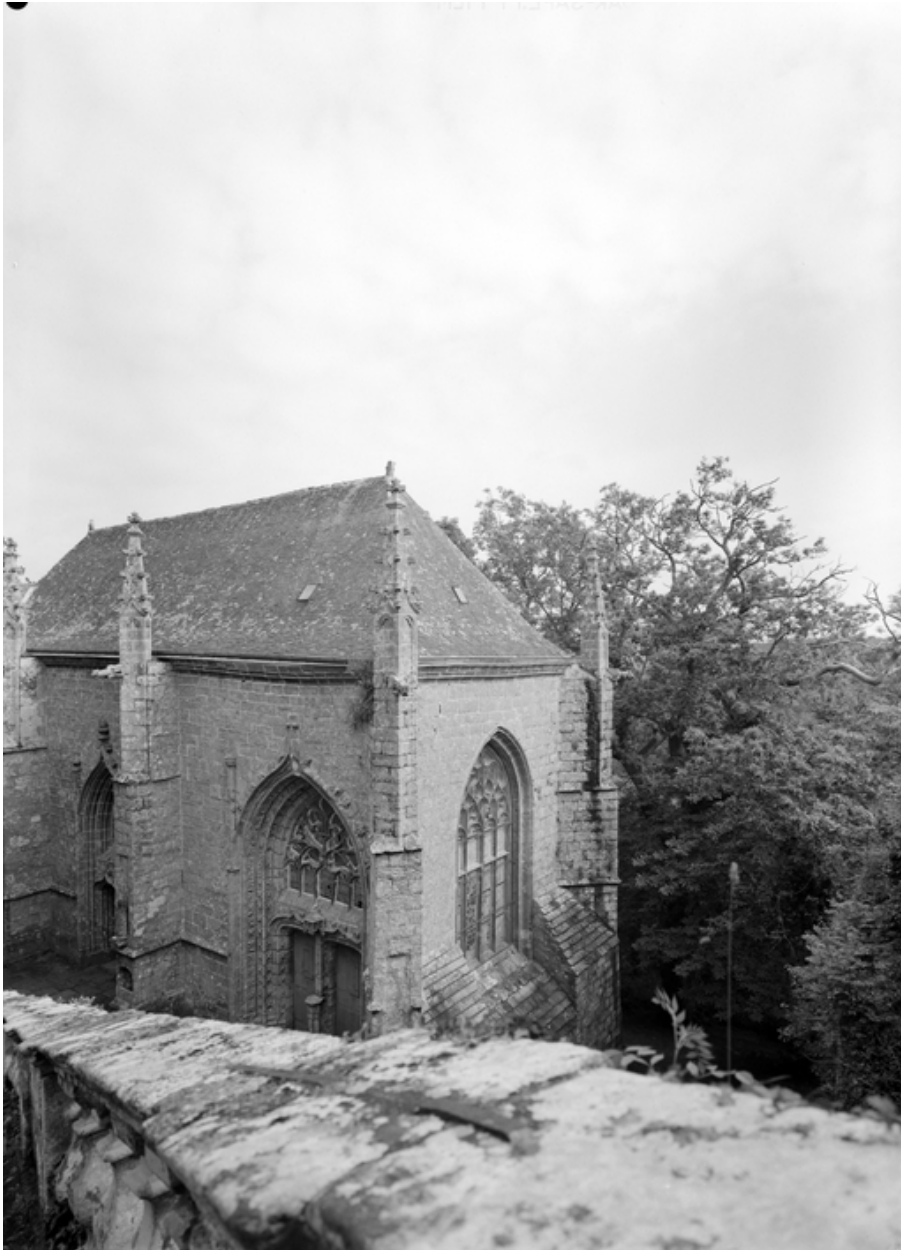
Partie sud prise du sud-ouest.
