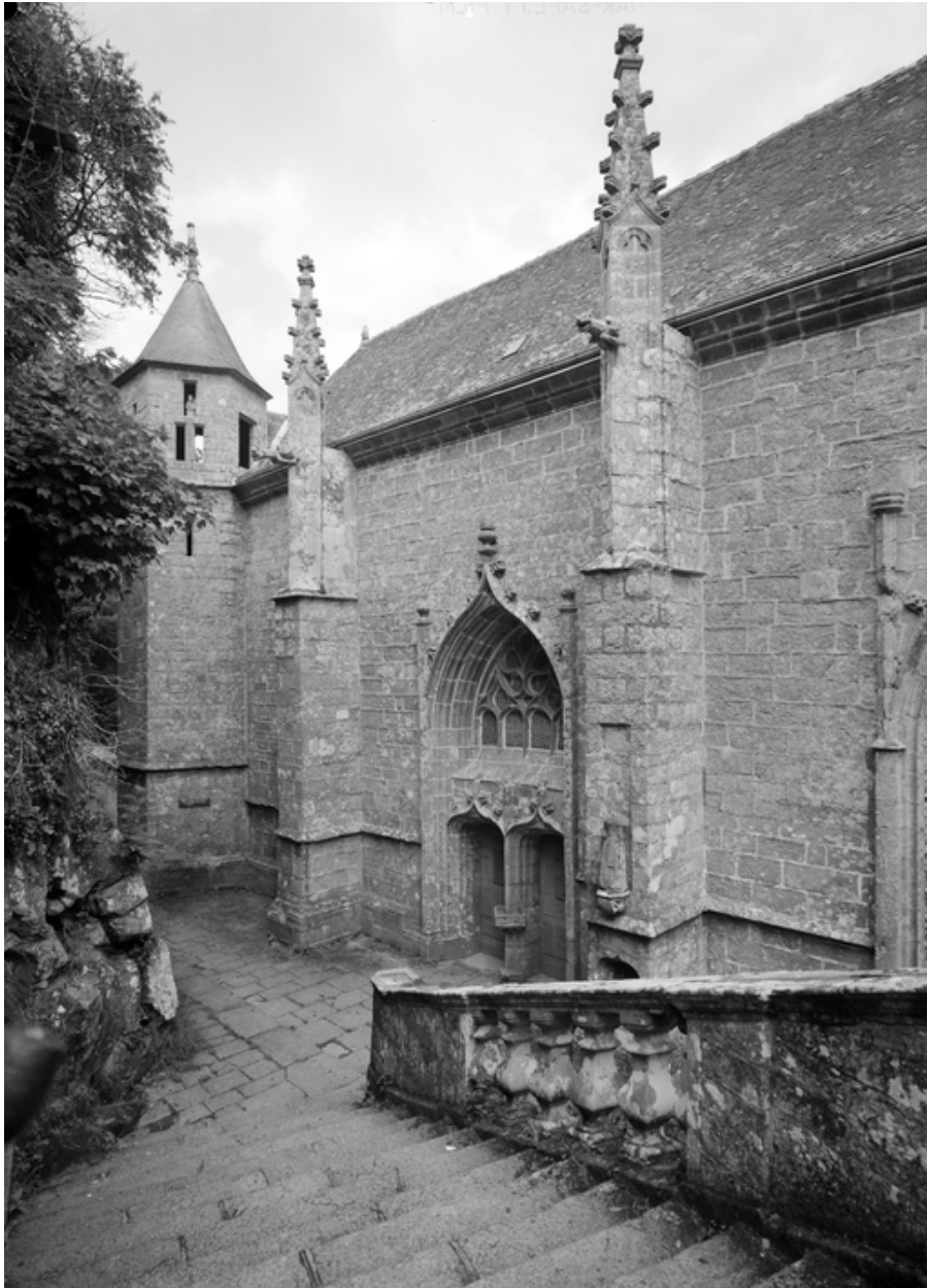
Façade ouest, vue générale.
