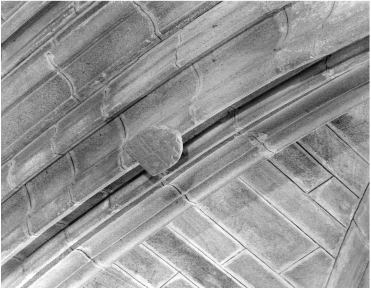
Ecu sur l'arcade sud de la croisée (côté ouest).
