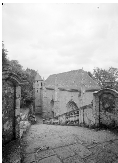
Vue générale prise du grand degré sud. Phot. François Dagorn IVR53_19665600107V
