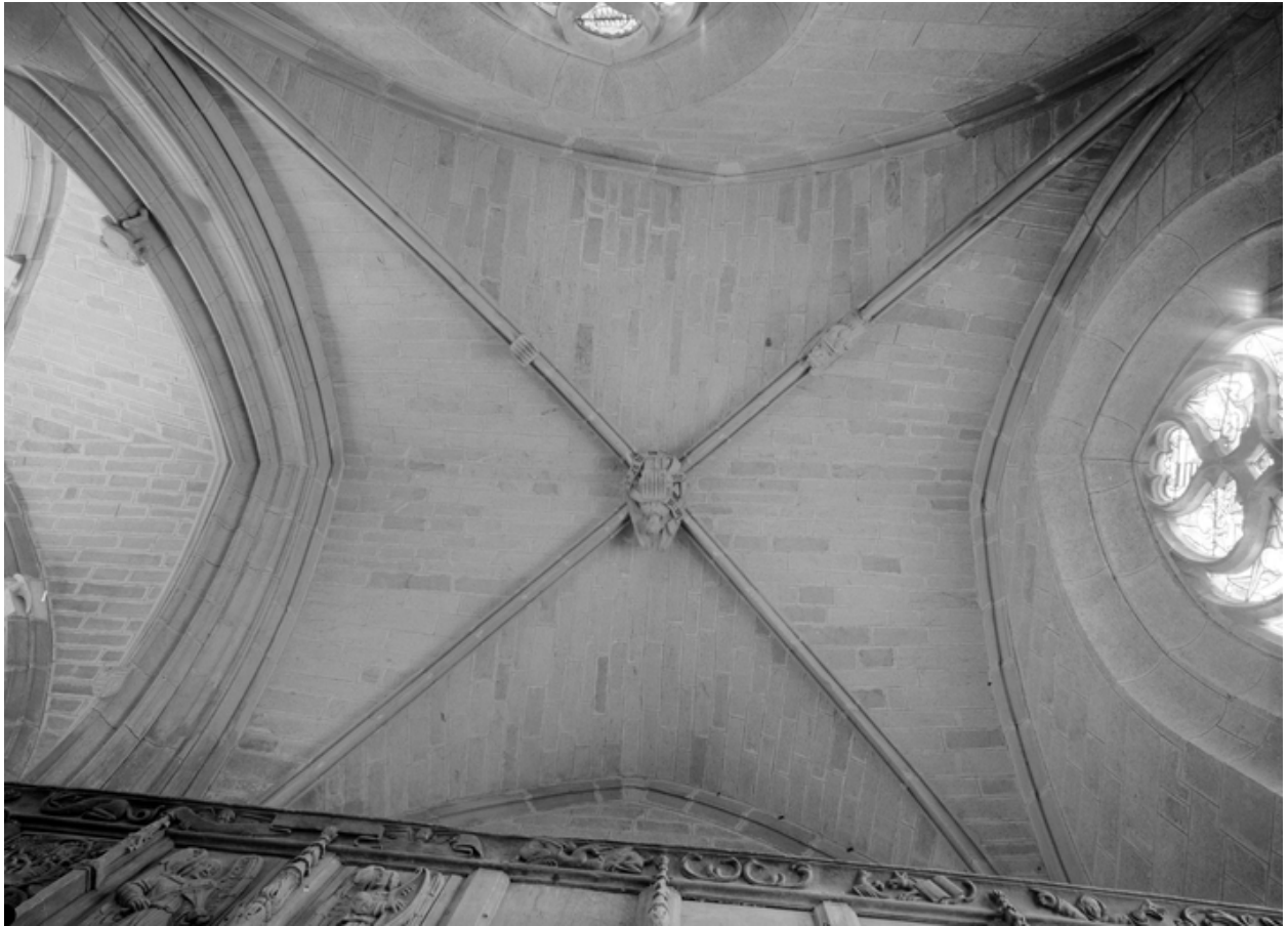
Croisillon nord, vue axiale de la voûte.
