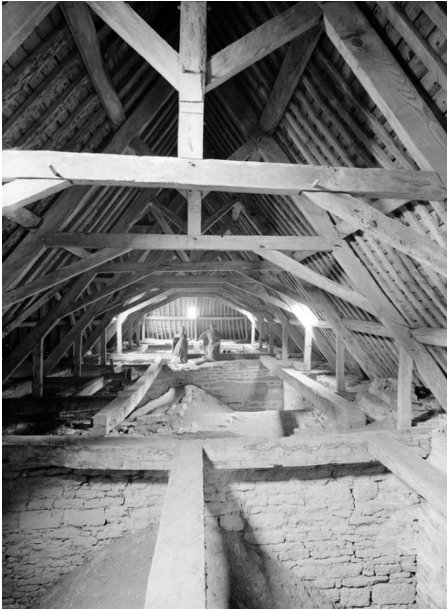
Vue générale de la charpente.
