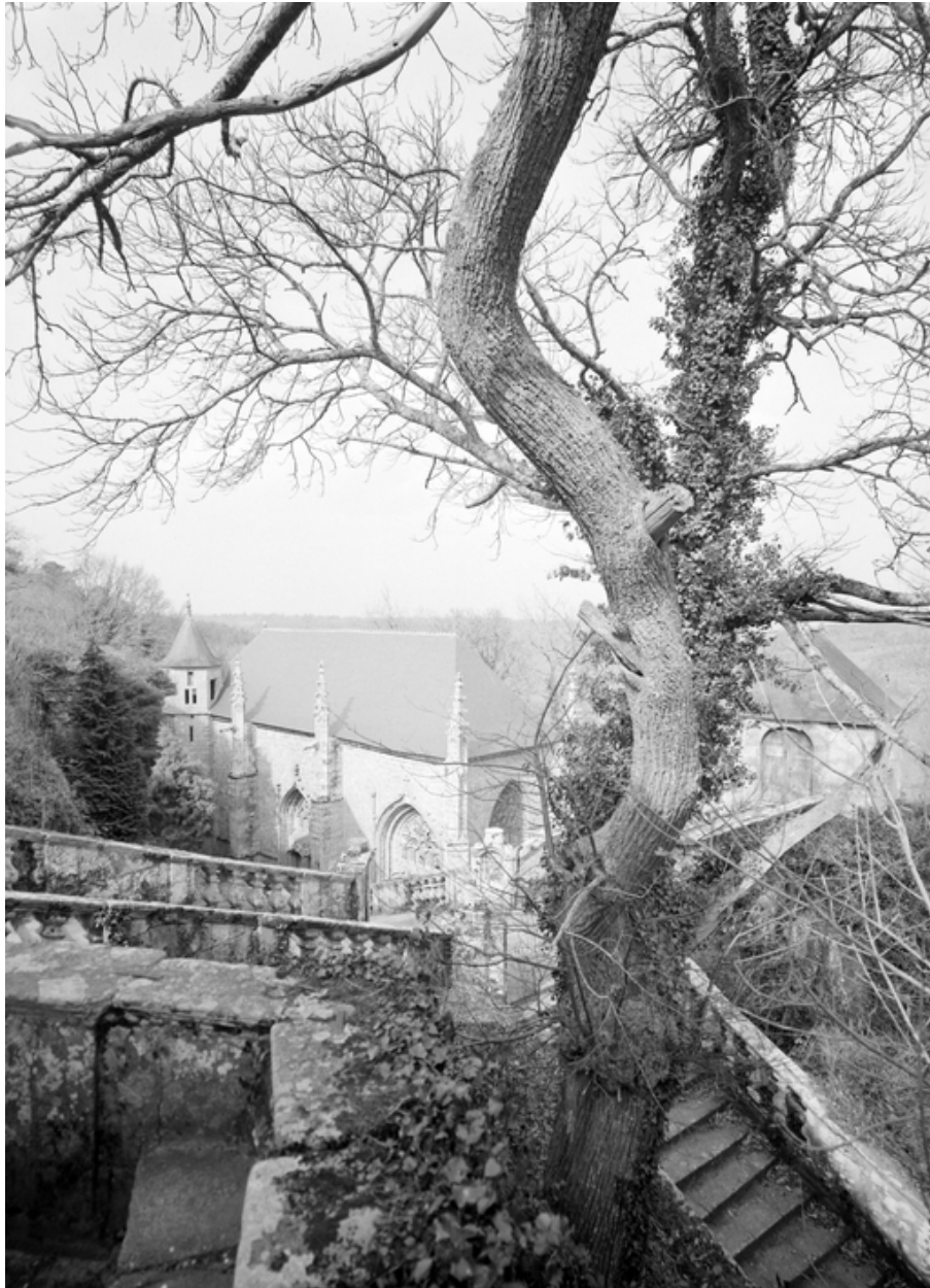
Vue générale prise du sud.
