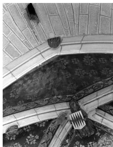
Ange tenant un écu aux armes des Boutteville à la clé de voûte du choeur et écu situé à la clé de l'arcade. Phot. François Dagorn IVR53_19705600112X
