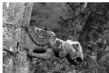
Gargouille au sud-ouest. Phot. François Dagorn IVR53_19685600052Z
