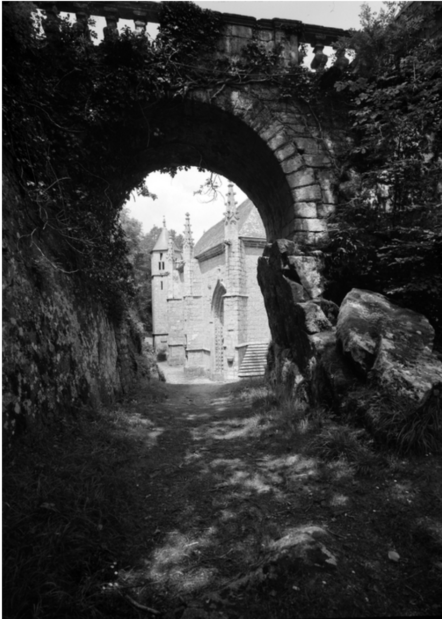
Vue générale du pont et de la chapelle.
