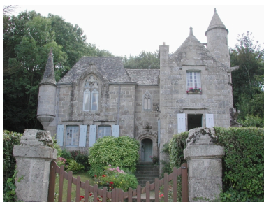
Façade antérieure Phot. Patrick Pichouron IVR53_20042205705NUCA
