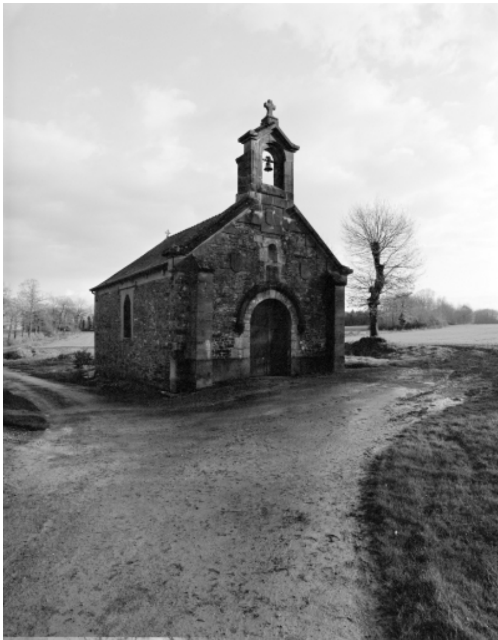
Vue générale de la façade principale.
