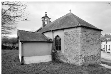
Élévation Nord : vue générale Phot. Bernard Bègne, Phot. M. Loyon IVR53_19923501006X
