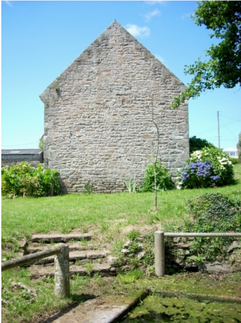
Ploudalmézeau, chapelle Saint-Eloi : élévation est
