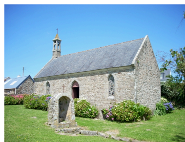
Ploudalmézeau, chapelle Saint- Eloi : vue générale sud-est Phot. Gwénaél Fauchille IVR53_20082906183NUCA
