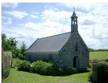
Ploudalmézeau, chapelle Saint- Eloi : vue générale nord-ouest Phot. Gwénaél Fauchille IVR53_20082906182NUCA
