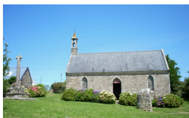
Ploudalmézeau, chapelle Saint-Eloi : élévation sud Phot. Gwénaél Fauchille IVR53_20082906181NUCA
