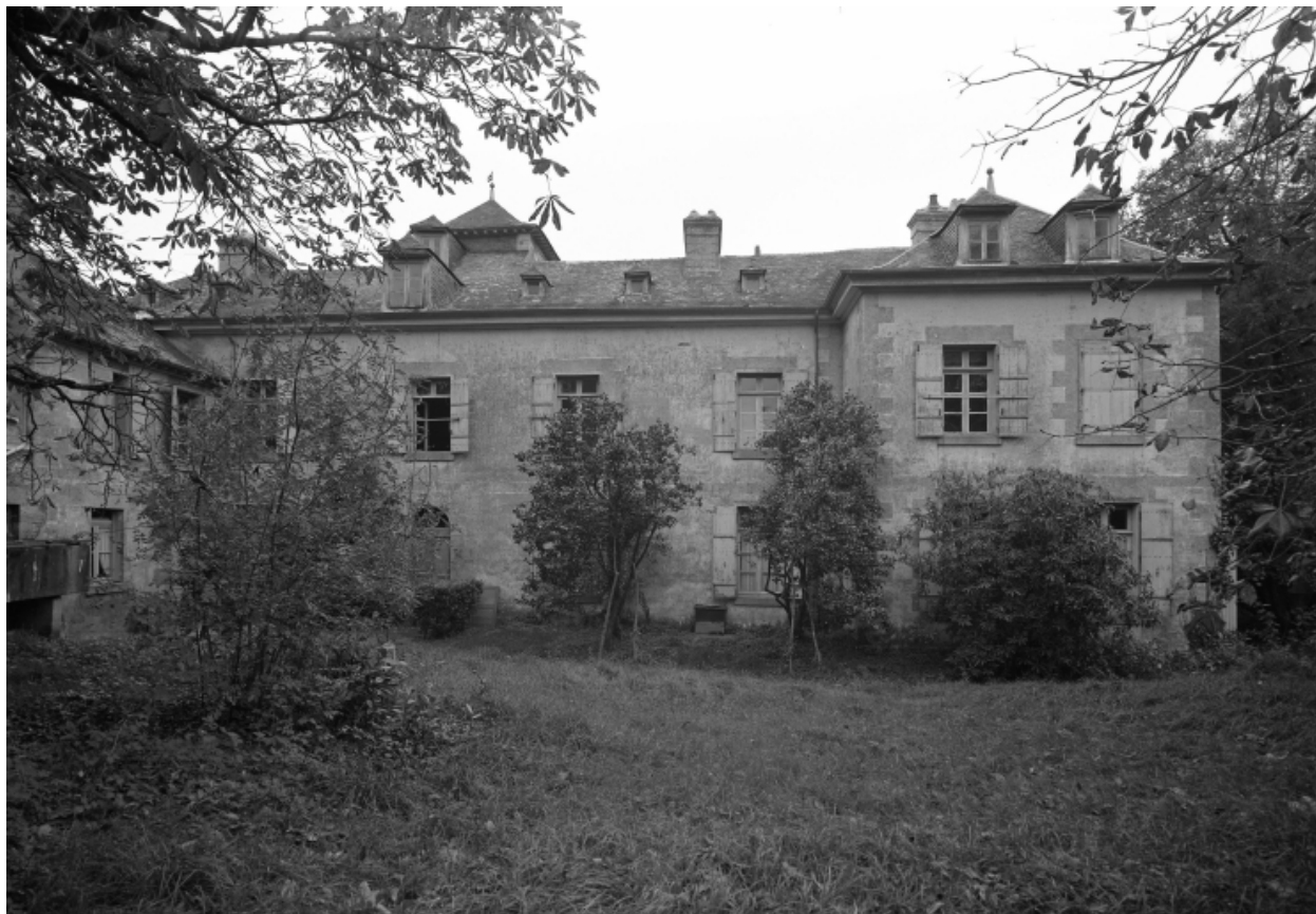
Vue générale nord
