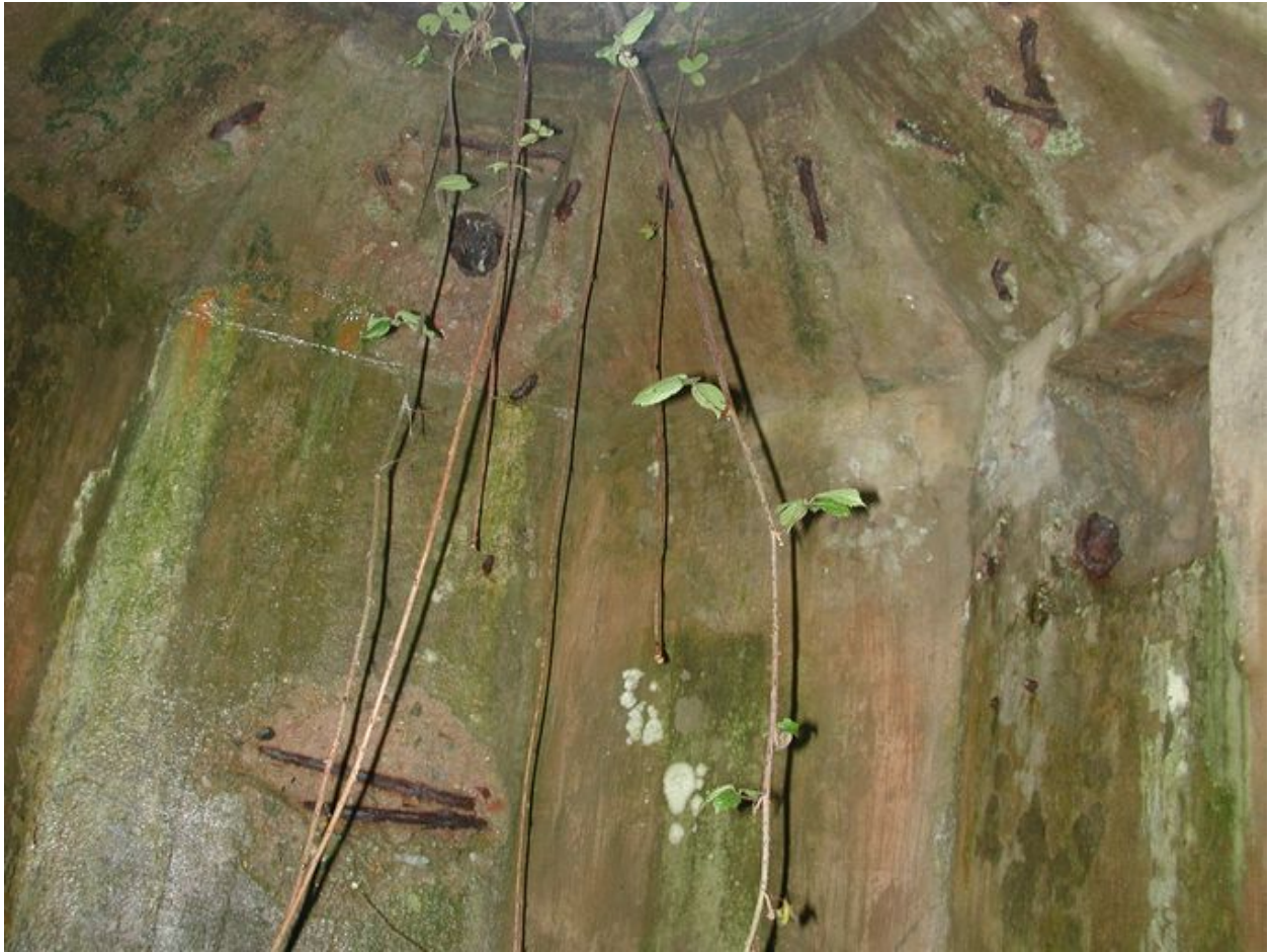
Vue du poste d'observation ouvert dit Offener Beobachter (dépourvu de chambre d'abri pour le stockage des munitions) (état en 2002). Son accès est indépendant du bunker
