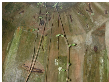
Vue du poste d'observation ouvert dit Offener Beobachter (dépourvu de chambre d'abri pour le stockage des munitions) (état en 2002). Son accès est indépendant du bunker Phot. Guillaume Lécueillier IVR53_20022901512NUCA
