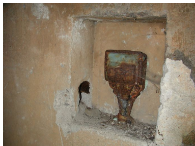
Vue du couloir d'accès : niche murale avec prise en place et passage de câble (état en 2002). La peinture ocre jaune est d'origine Phot. Guillaume Lécueillier IVR53_20022901513NUCA
