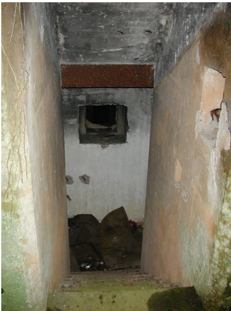
Vue du couloir d'accès flanqué par un créneau de tir (état en 2002). A droite, niche murale avec passage de câble. La peinture ocre jaune est d'origine ; au fond, enduit blanc à la chaux
