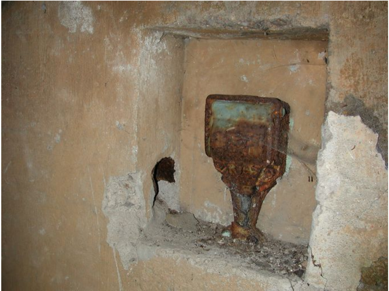
Vue du couloir d'accès : niche murale avec prise en place et passage de câble (état en 2002). La peinture ocre jaune est d'origine
