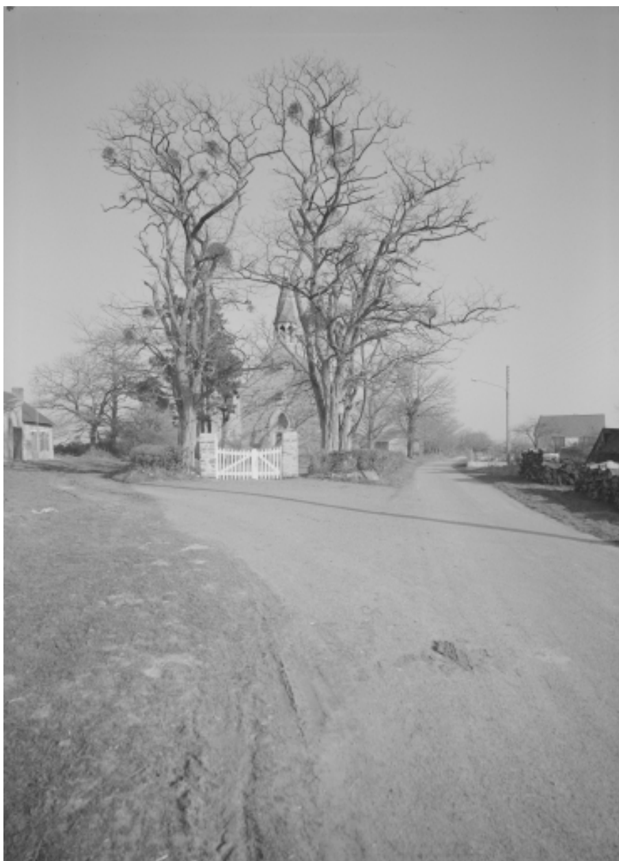
Elévation Ouest : vue de situation
