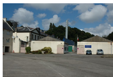
Vue générale depuis le domaine public (état en 2007) Phot. Guillaume Lécueillier IVR53_20082909792NUCA
