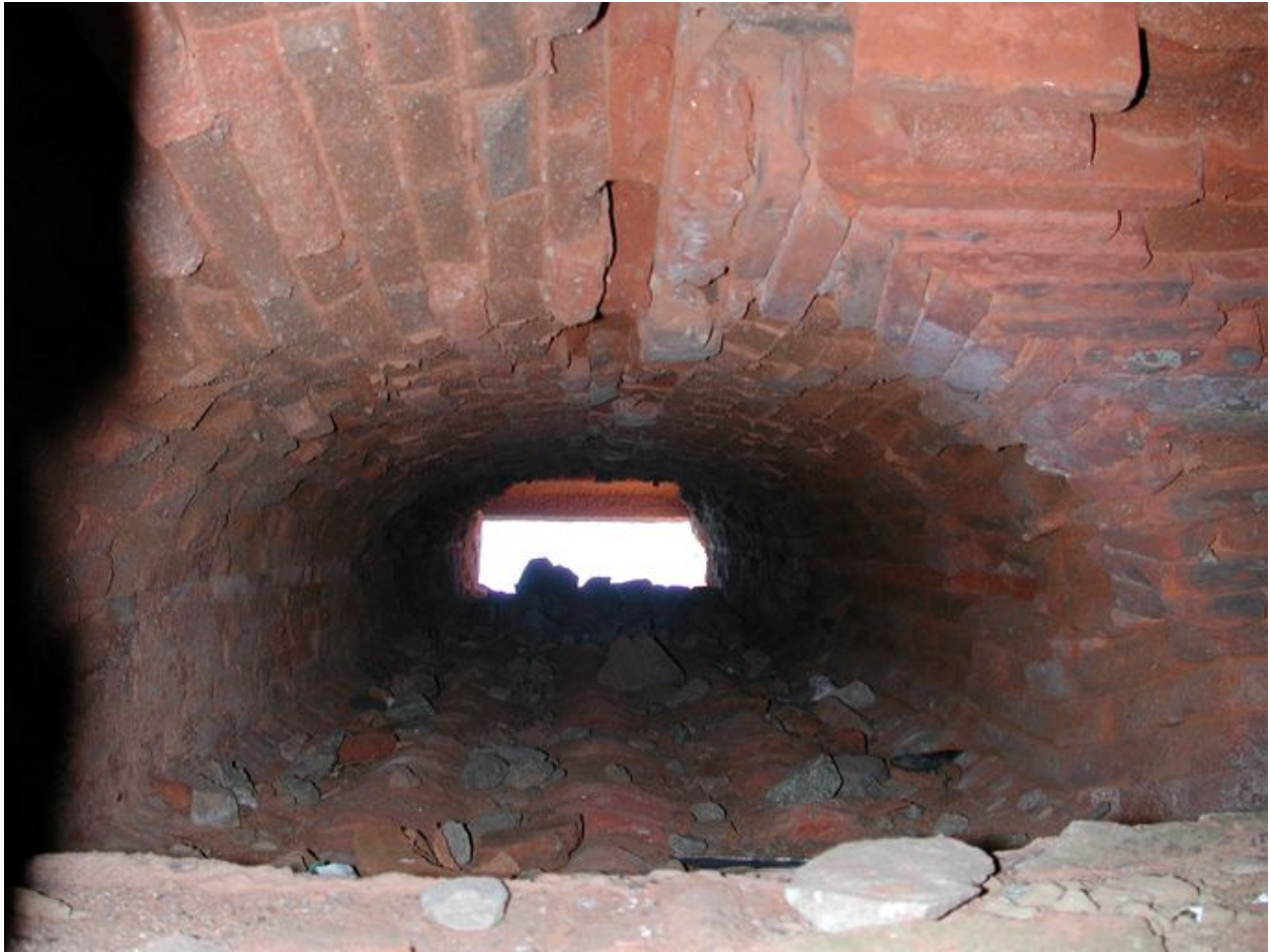
Vue du couloir de chauffe des boulets (état en 2002). Il est construit en brique réfractaire
