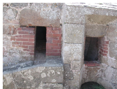
Vue de détail de l'élévation nord : orifice de sortie et goulotte de réception des boulets rouges (à gauche) et foyer (à droite) Phot. Guy Prigent IVR53_20042208869NUCA
