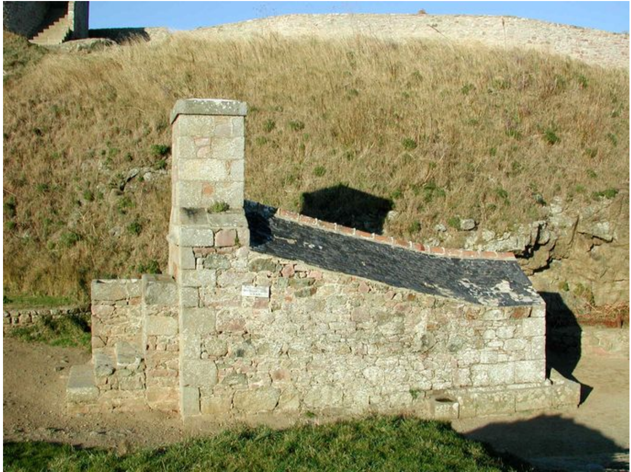
Vue de l'élévation est (état en 2002)
