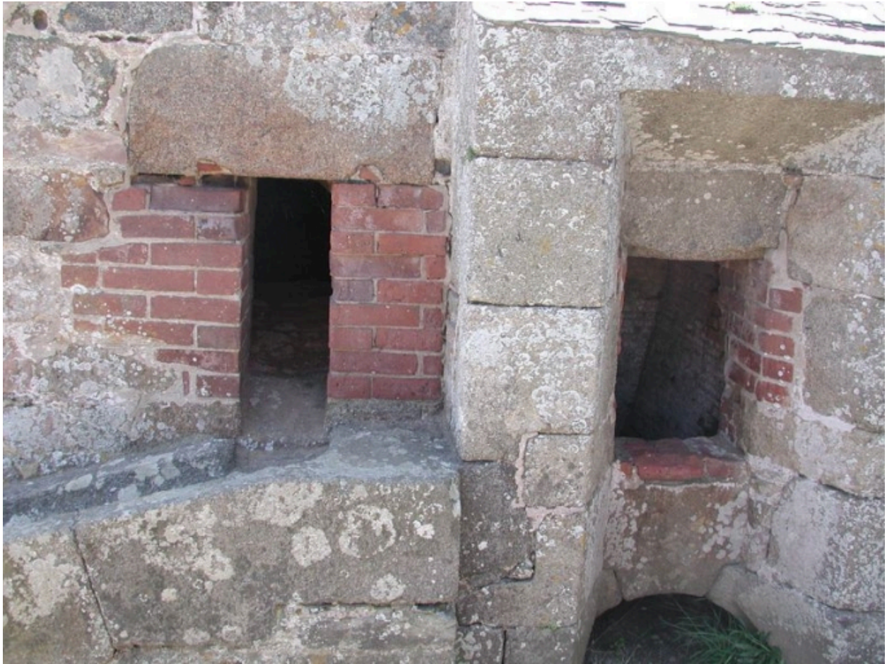
Vue de détail de l'élévation nord : orifice de sortie et goulotte de réception des boulets rouges (à gauche) et foyer (à droite)
