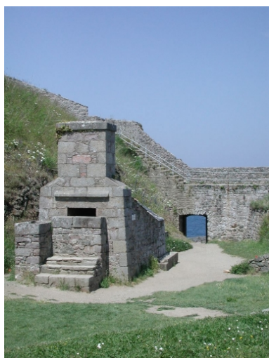
Vue de l'élévation sud (état en 2004). Trois marches donnent accès à la gueule d'enfournement Phot. Guy Prigent IVR53_20042208870NUCA
