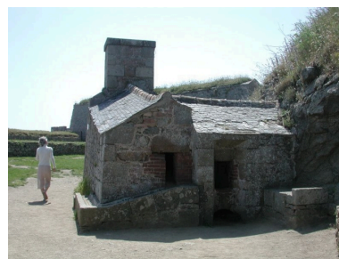
Vue de l'élévation nord (état en 2004). Elle est construite en pierre de taille et en maçonnerie de moellon de granite Phot. Guy Prigent IVR53_20042208868NUCA
