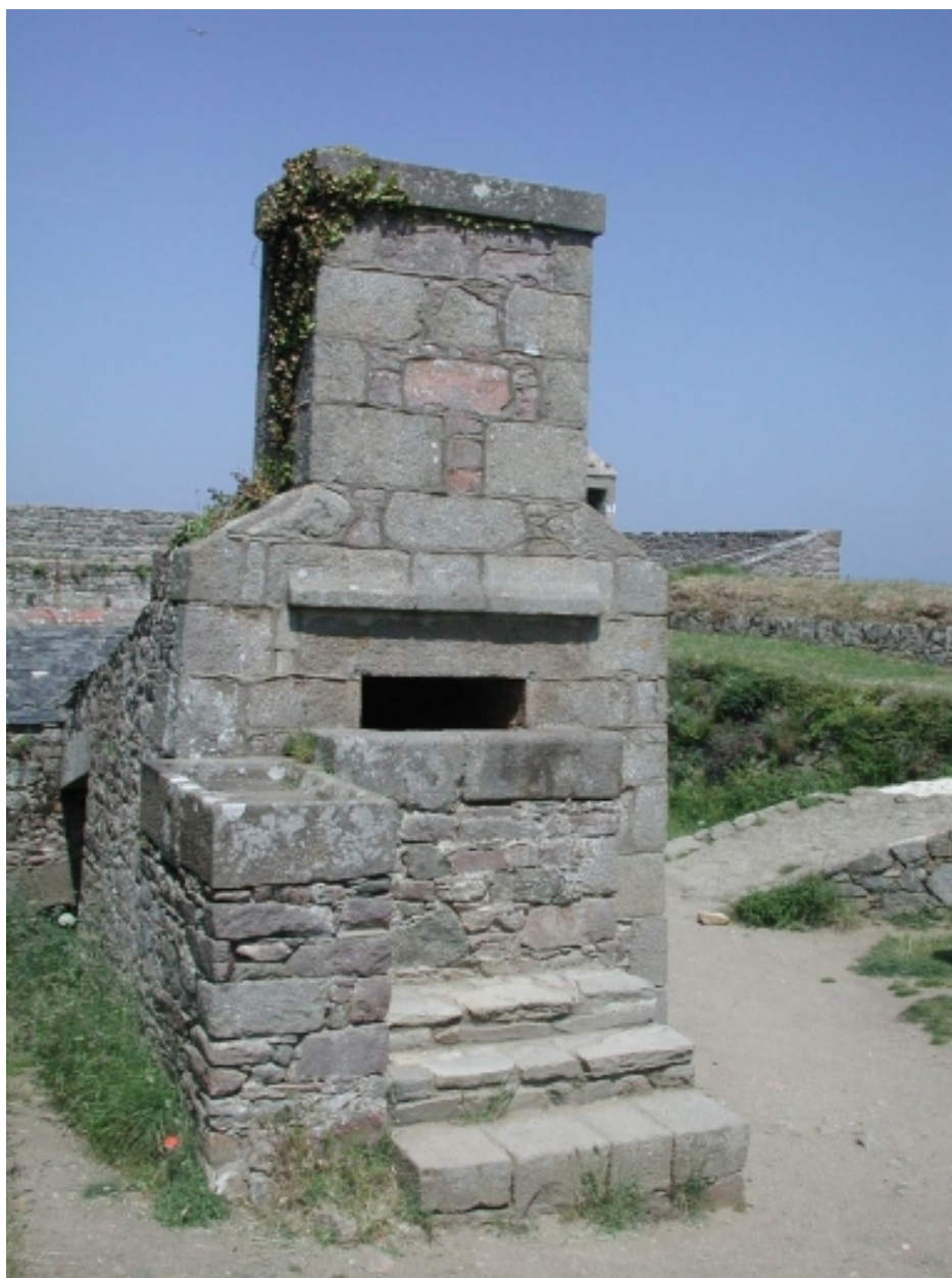
Vue de l'élévation sud (état en 2004). Trois marches donnent accès à la gueule d'enfournement. A gauche, la table pour les boulets froids
