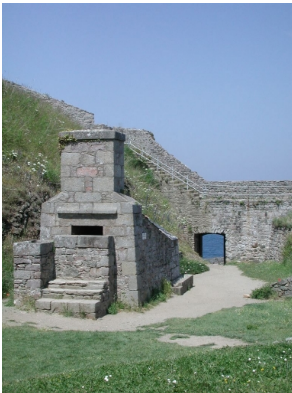
Vue de l'élévation sud (état en 2004). Trois marches donnent accès à la gueule d'enfournement
