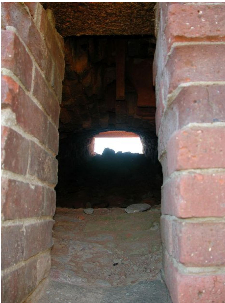
Vue du jour de sortie des boulest rouges (état en 2002)
