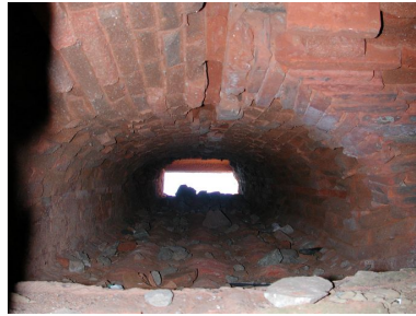
Vue du couloir de chauffe des boulets (état en 2002). Il est construit en brique réfractaire Phot. Guillaume Lécueillier IVR53_20052203876NUCA
