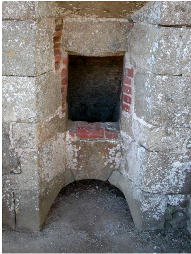
Vue de l'ouverture du foyer (état en 2002). Au ras du sol, jour de ventilation Phot. Guillaume Lécueillier IVR53_20052203873NUCA
