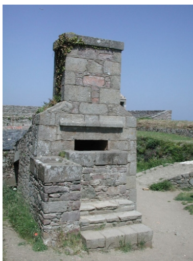
Vue de l'élévation sud (état en 2004). Trois marches donnent accès à la gueule d'enfournement. A gauche, la table pour les boulets froids Phot. Guy Prigent IVR53_20052204756NUCA
