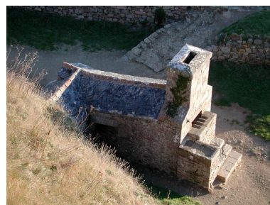
Vue générale (état en 2002). Le four conserve sa table pour les boulets froids avant enfournement et sa souche de cheminée. La gueule du four est dotée de quatre rainures Phot. Guillaume Lécueillier IVR53_20052203869NUCA
