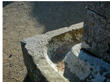
Vue de la goulotte de reception en granite des boulets rouges (état en 2002) Phot. Guillaume Lécueillier IVR53_20052203878NUCA
