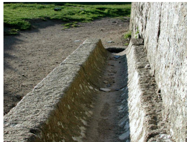
Vue de la goulotte de reception en granite des boulets rouges (état en 2002) Phot. Guillaume Lécueillier IVR53_20052203877NUCA
