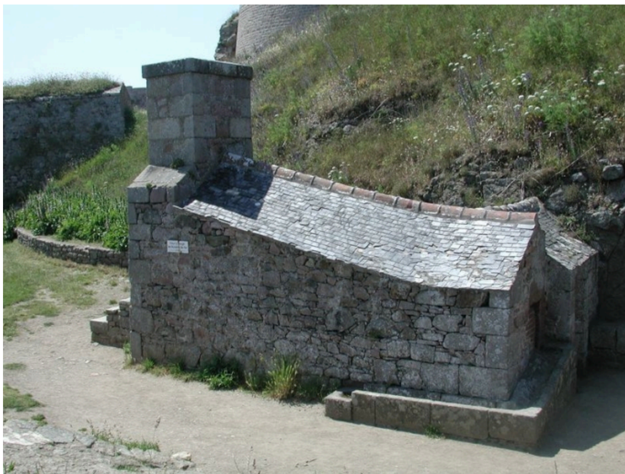
Vue de l'élévation est (état en 2004)
