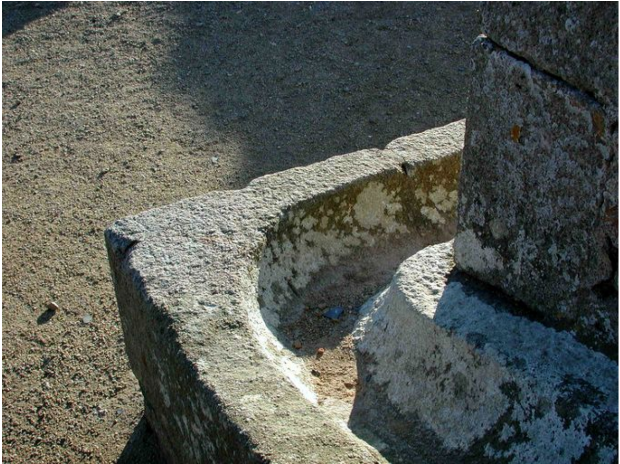
Vue de la goulotte de reception en granite des boulets rouges (état en 2002)
