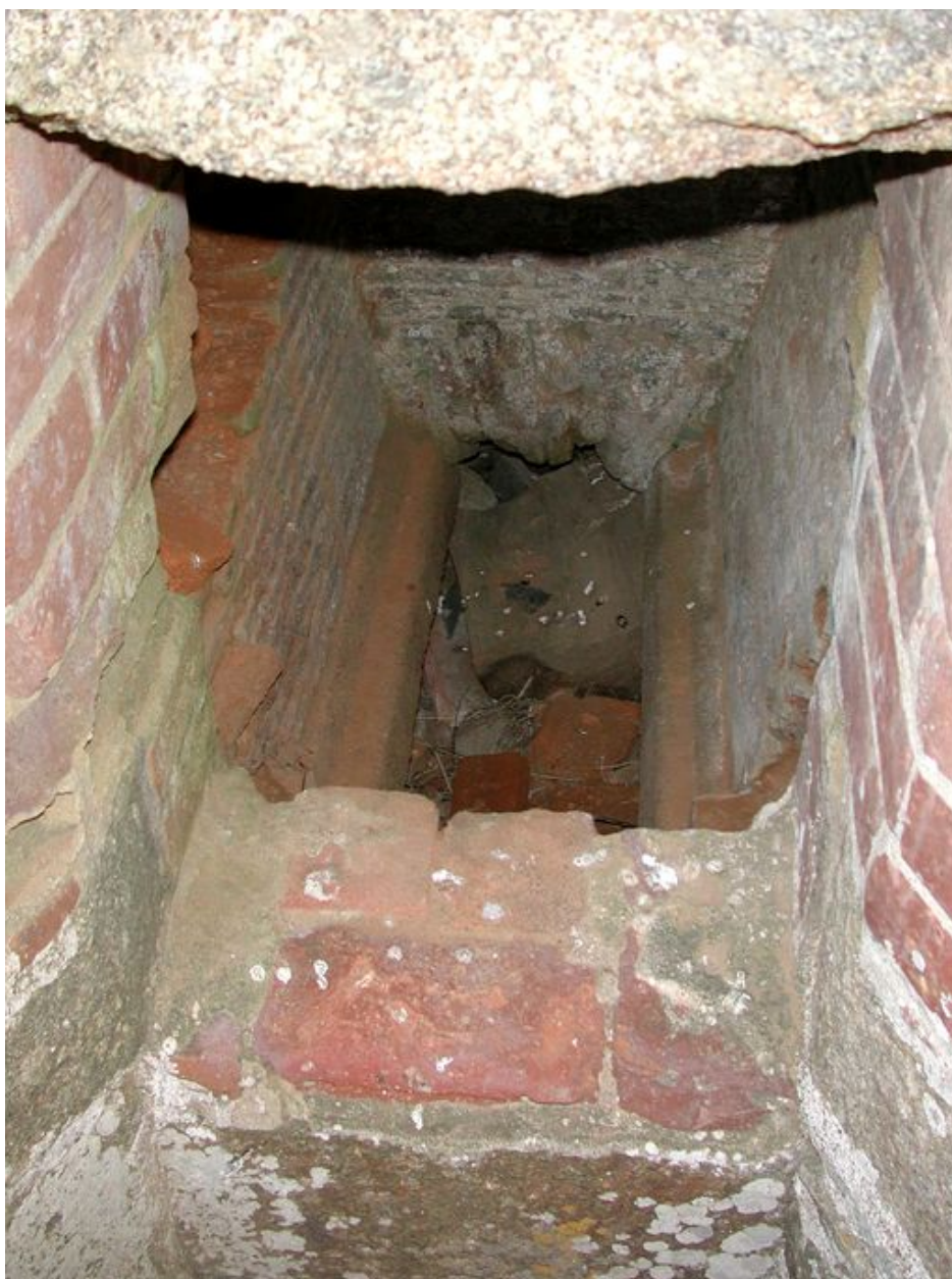
Vue du foyer (état en 2002)
