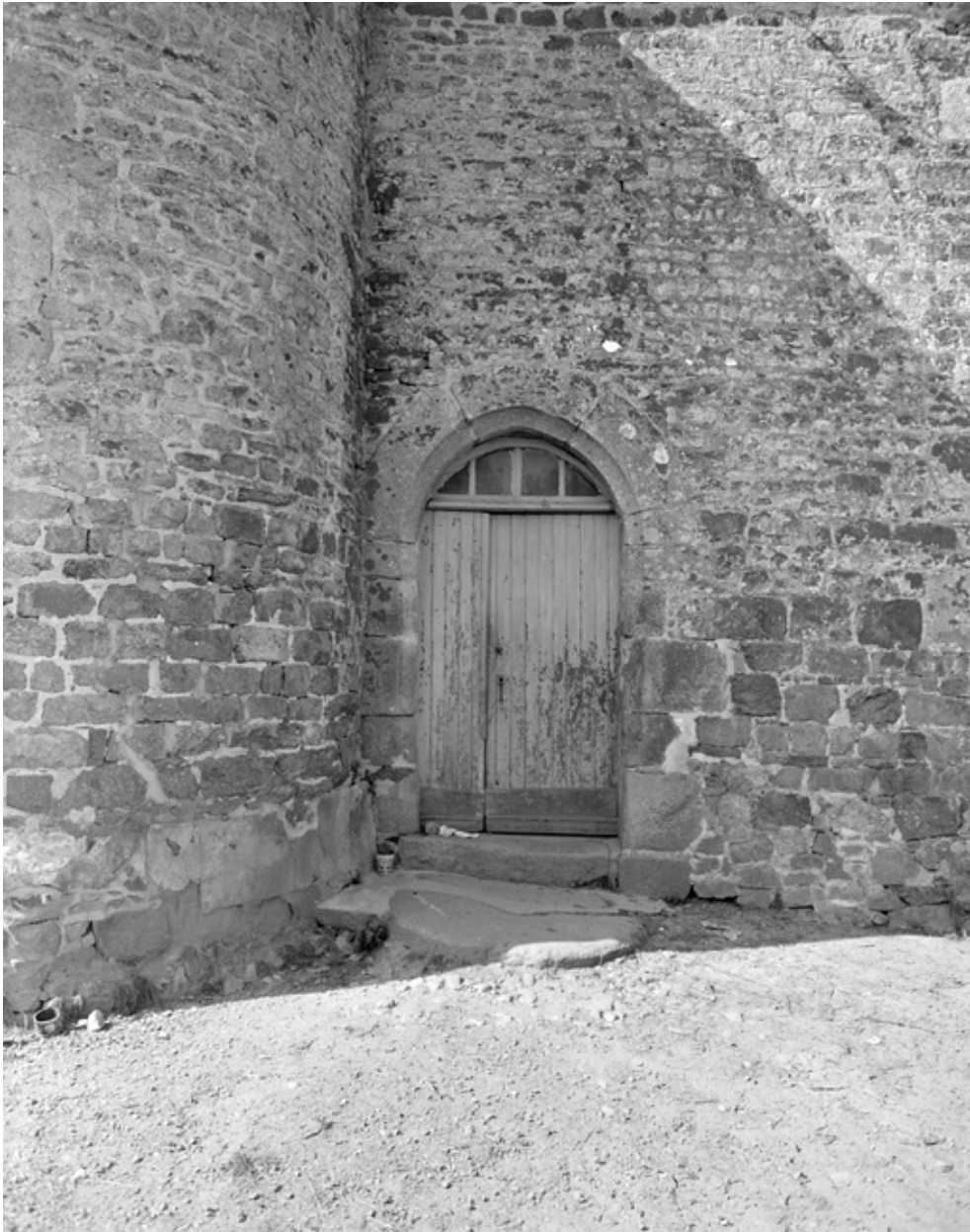
Vue de la porte de la façade sud
