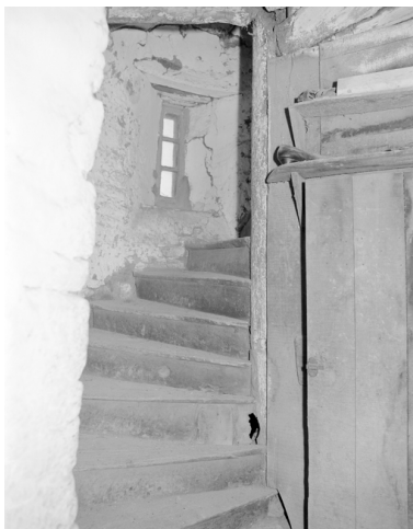
Vue de l'escalier prise du bas
