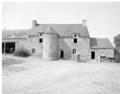
Vue générale de la façade sud Phot. Guy Artur IVR53_19752200309X
