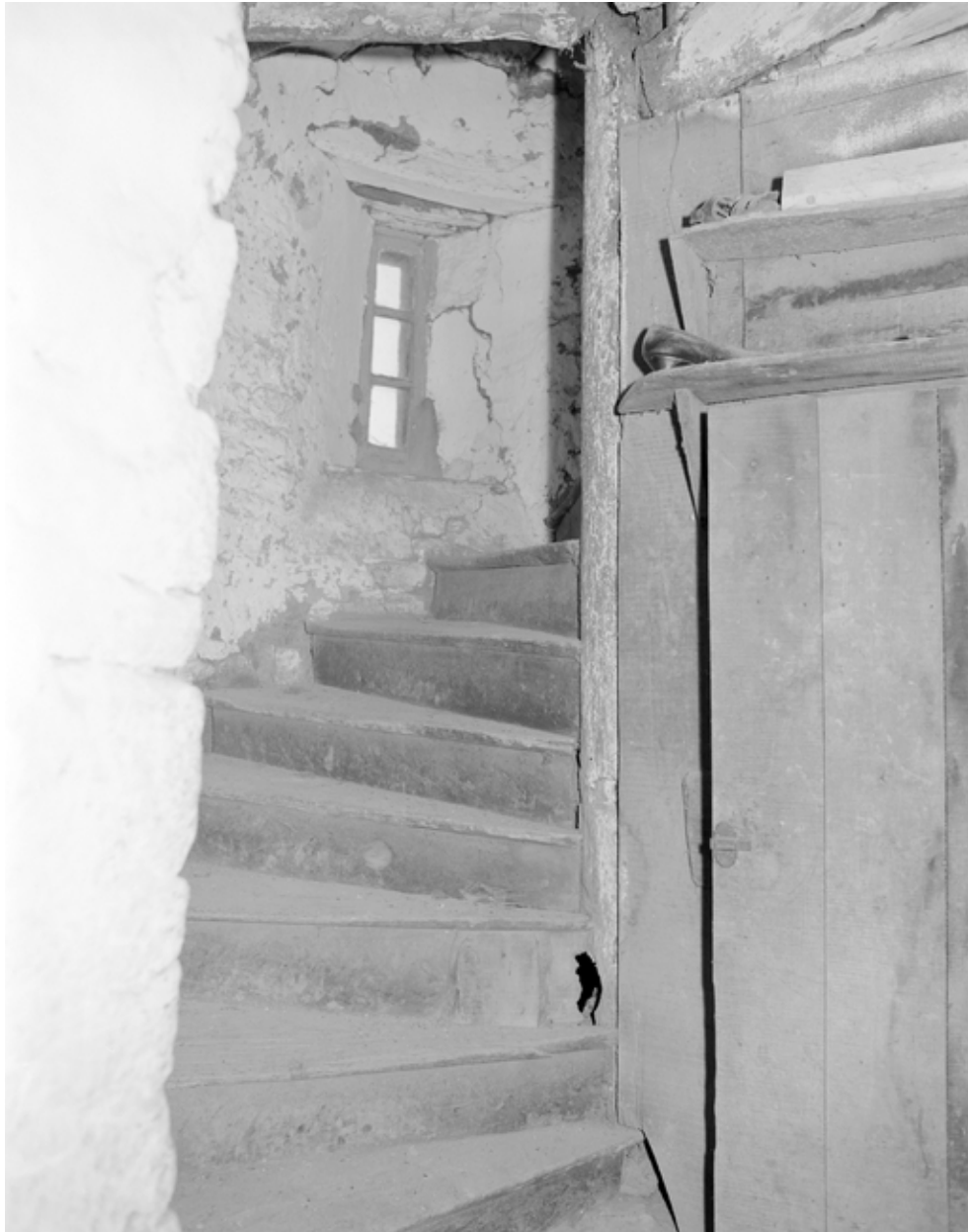
Vue de l'escalier prise du bas
