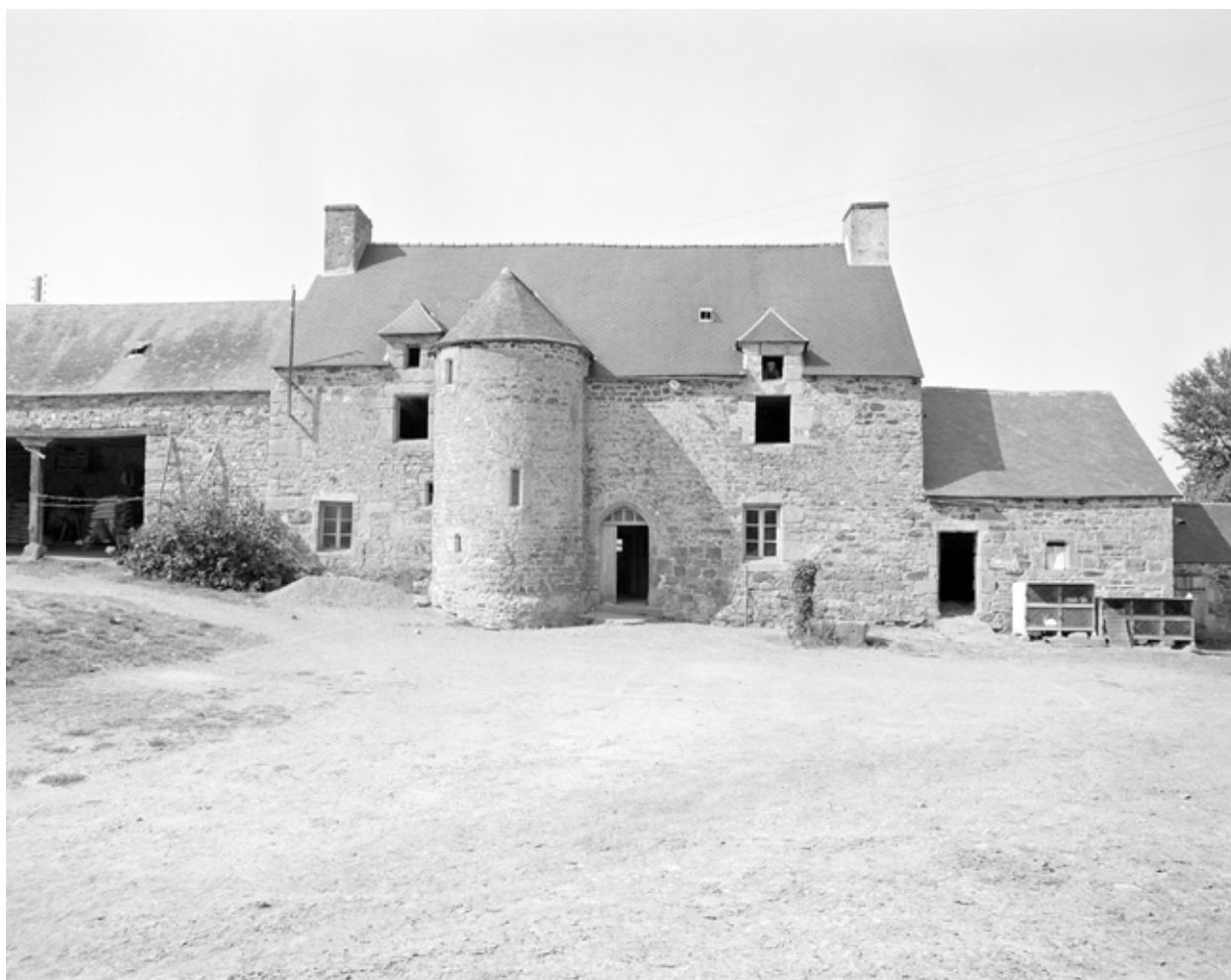
Vue générale de la façade sud
