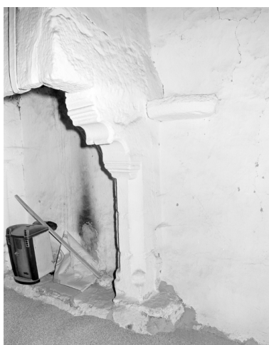
Cheminée, étage, mur est : détail console et haut du piedroit Phot. Guy Artur IVR53_19752200311X
