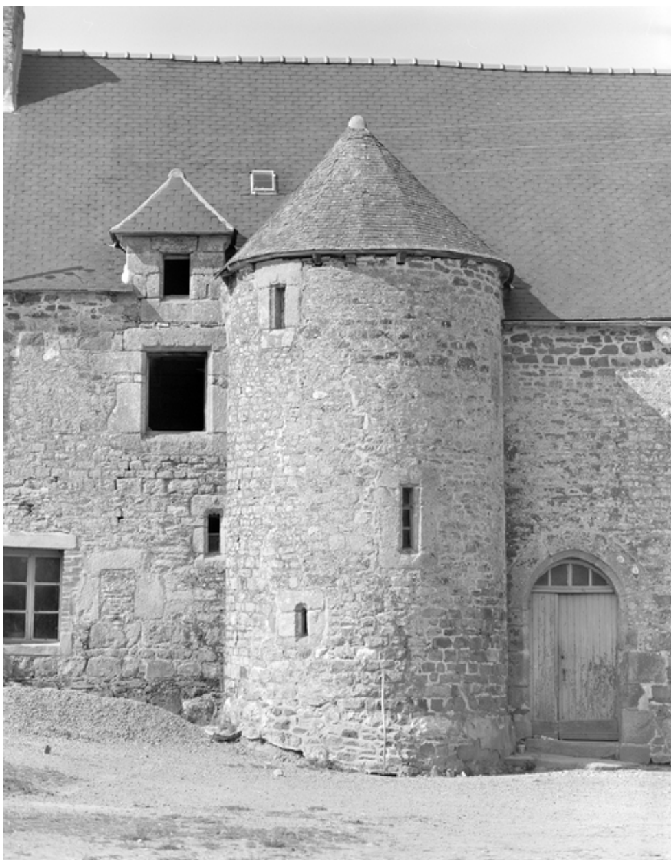
Vue de la tour, face ouest
