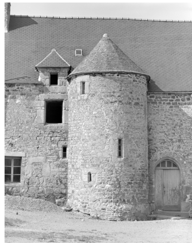
Vue de la tour, face ouest Phot. Guy Artur IVR53_19752200362X
