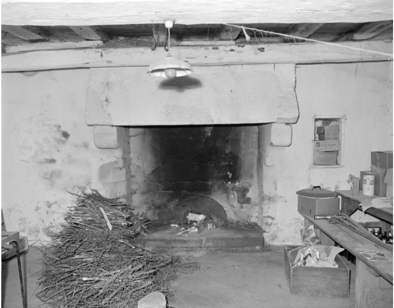
Cheminée, rez-de-chaussée, mur ouest
