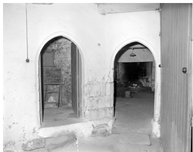
Portes de communication à l'étage entre l'escalier et la pièce de l'étage
