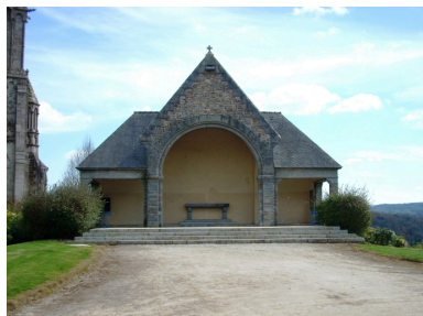
Châteauneuf-du-Faou, chapelle Notre-Dame-des-Portes : chapelle extérieure, élévation ouest Phot. Gwénaél Fauchille IVR53_20082905570NUCA
