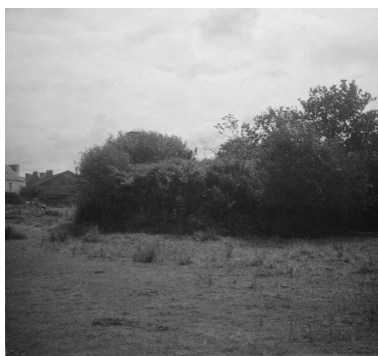
Kermaria-Sulard : motte féodale nord du bourg (face est), photographie de 1975 Phot. Dominique Chouteau IVR53_20102201918Z
