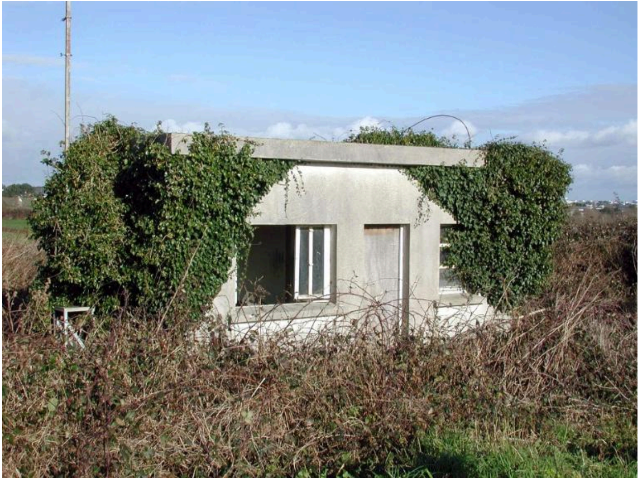
Vue d'un bunker en construction de campagne
