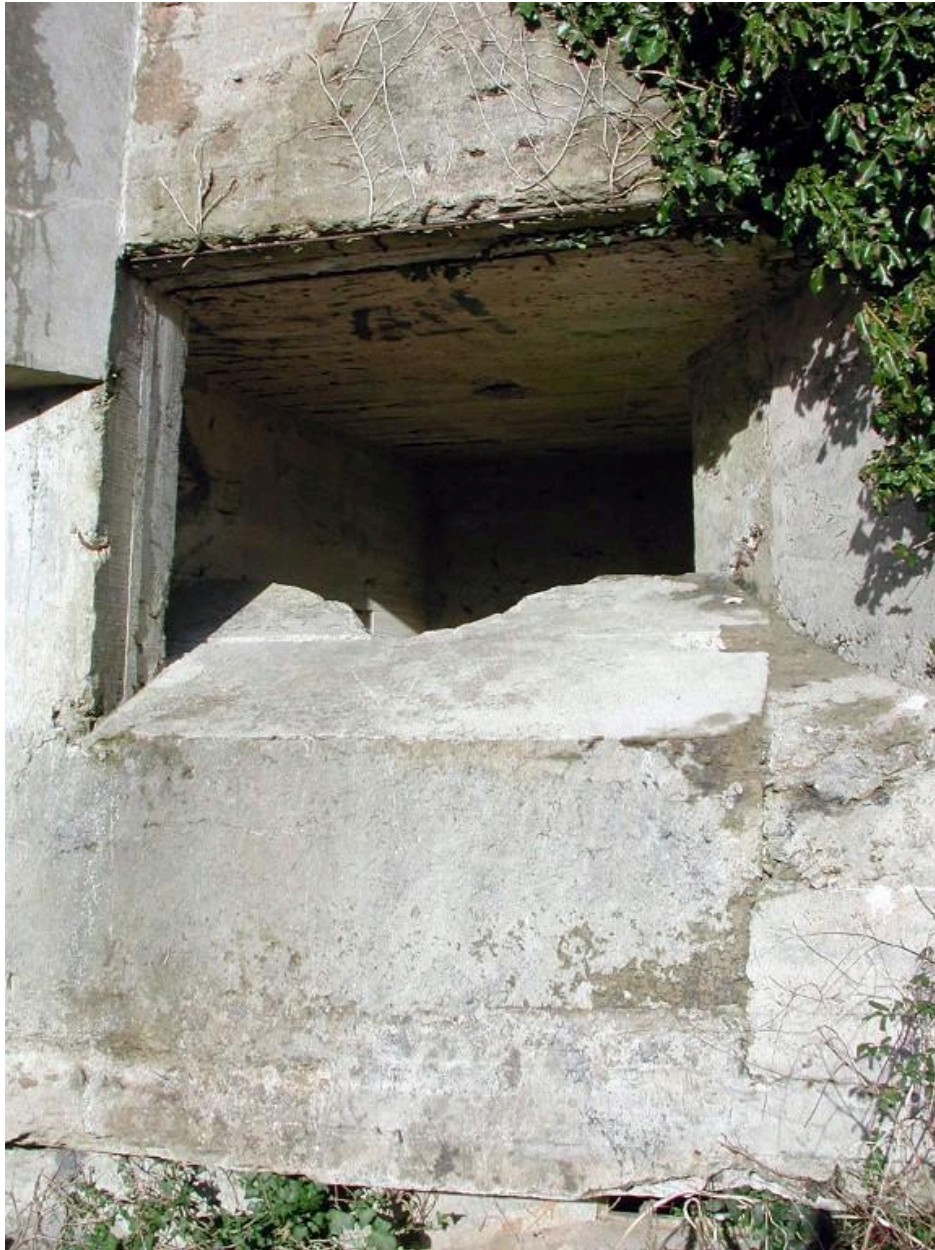
Vue du détail du poste d'observation et de télémétrie n° 1 (état en 2003)
