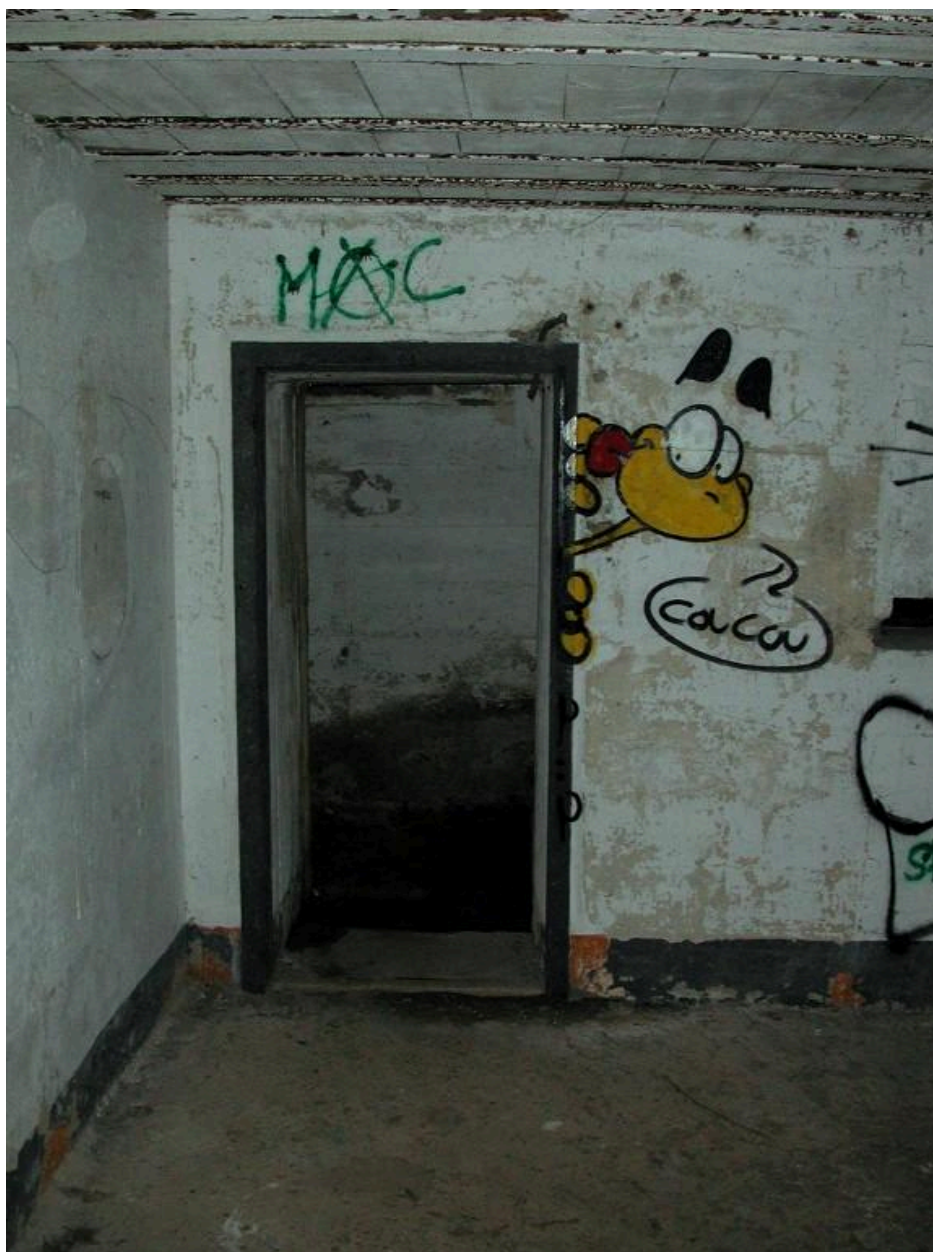
Vue intérieure du poste d'observation et de télémétrie n° 1 (état en 2003)
