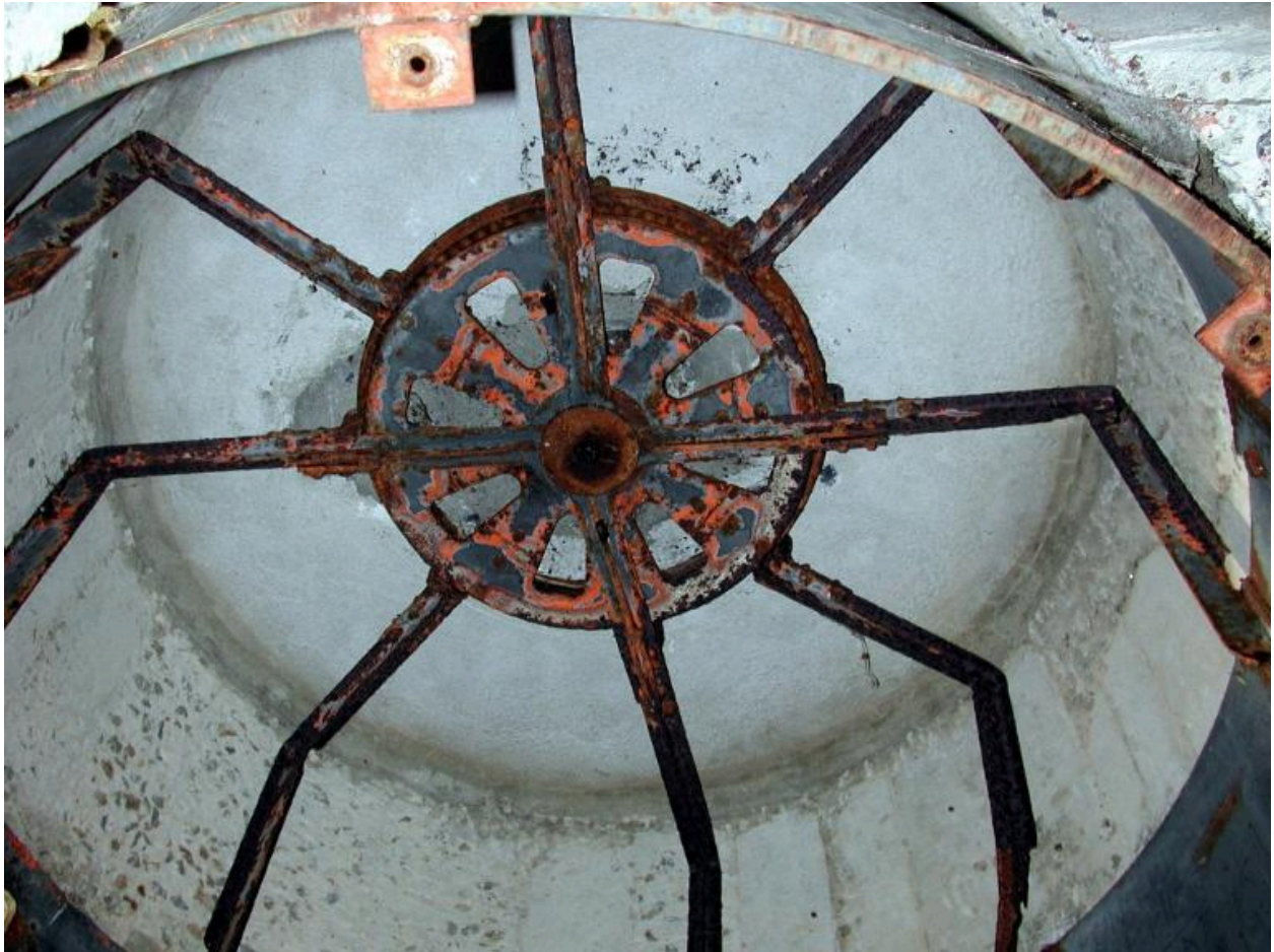
Vue intérieure du poste d'observation et de télémétrie n° 1 (état en 2003)
