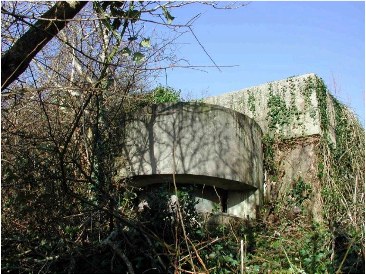
Vue du poste d'observation et de télémétrie n° 2 (état en 2003)
