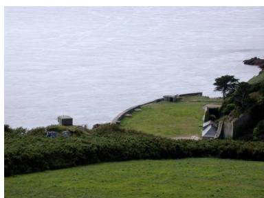
Vue de situation du poste d'observation et de télémétrie n° 1 (état en 2003). Au ras de la mer, la batterie basse du Mengant depuis Kerdalaez Phot. Guillaume Lécueillier IVR53_20072905958NUCA
