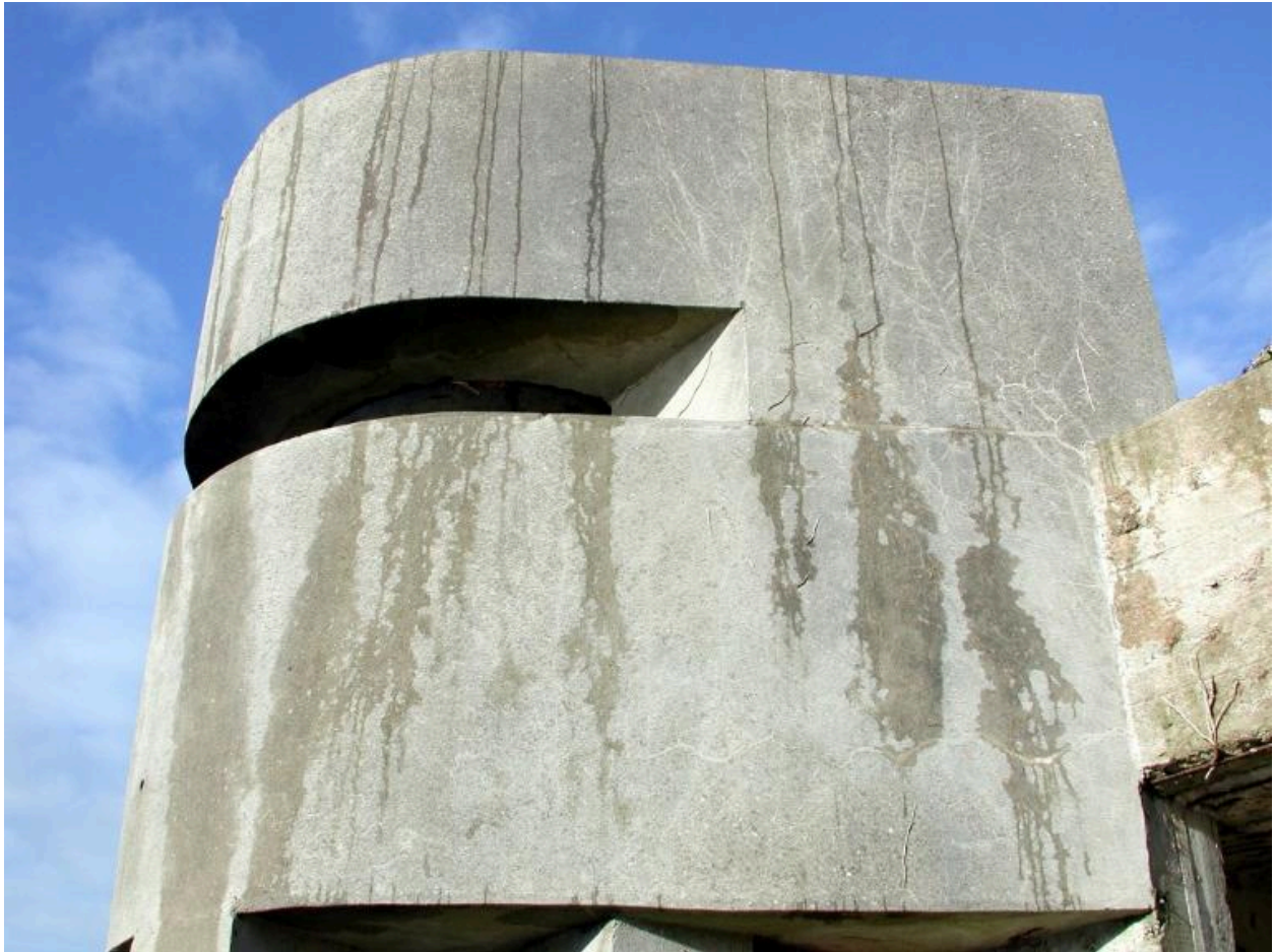
Vue de détail du poste d'observation et de télémétrie n° 1 (état en 2003)
