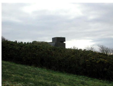
Vue de situation du poste d'observation et de télémétrie n° 1 (état en 2003) Phot. Guillaume Lécueillier IVR53_20072905960NUCA
