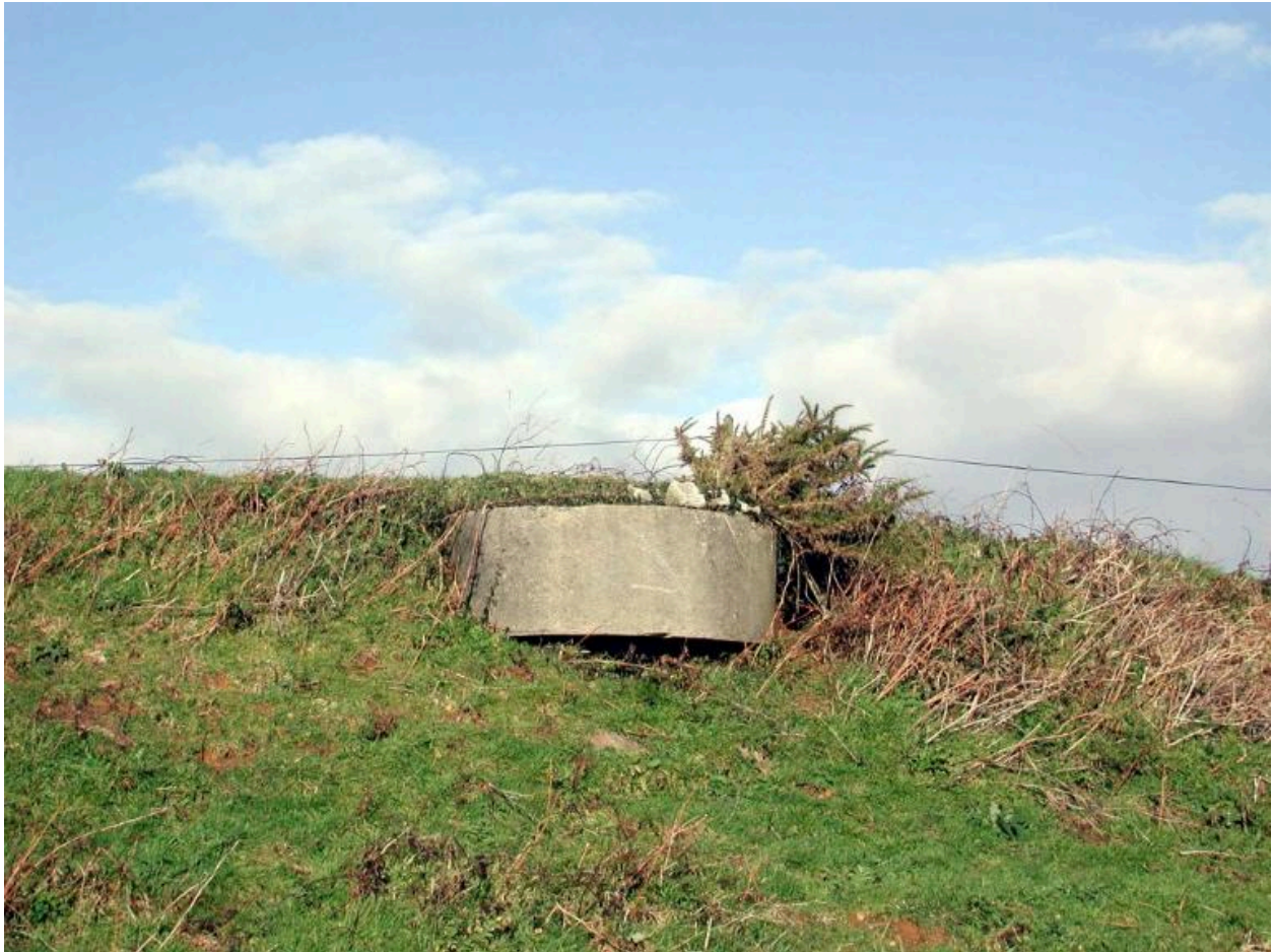
Vue du poste d'observation et de télémétrie n° 4 (état en 2003)
