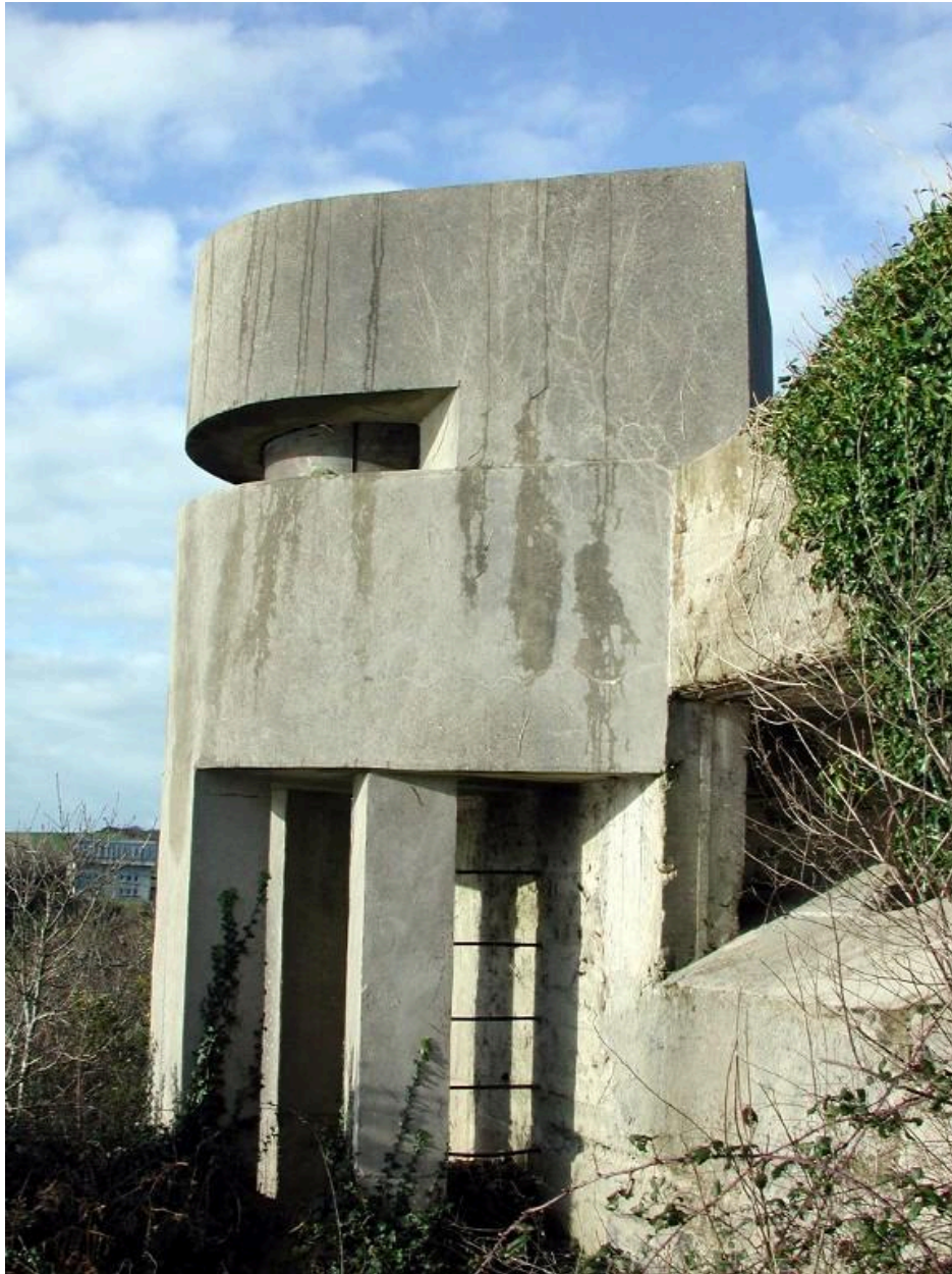
Vue du poste d'observation et de télémétrie n° 1 (état en 2003)
