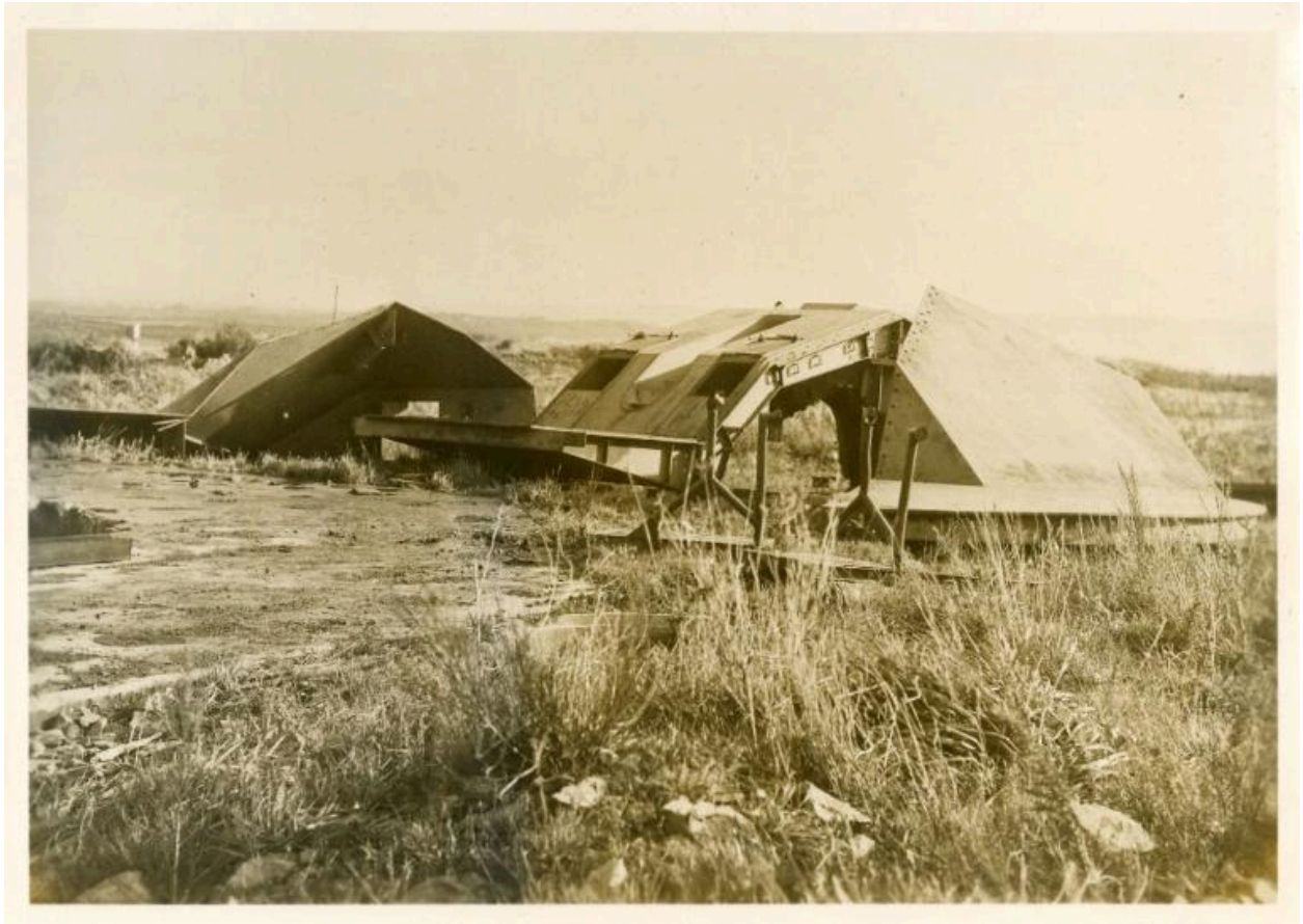
Vue du démontage de la coupole blindée de l'un des canons antiaériens de 10,5 cm de calibre (Archives municipales de Brest : 2Fi12646)
