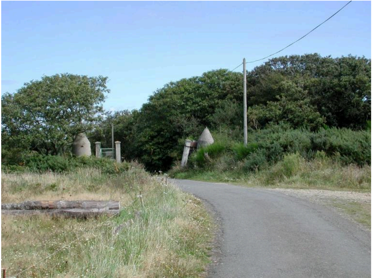
Vue des deux guérites en béton armé implantées à l'entrée de la batterie antiaérienne (état en 2002)
