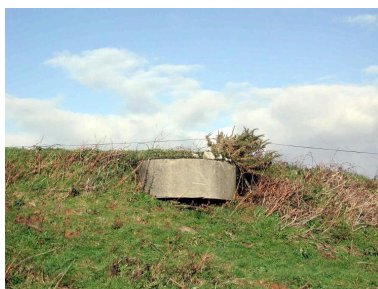
Vue du poste d'observation et de télémétrie n° 4 (état en 2003) Phot. Guillaume Lécueillier IVR53_20072905956NUCA
