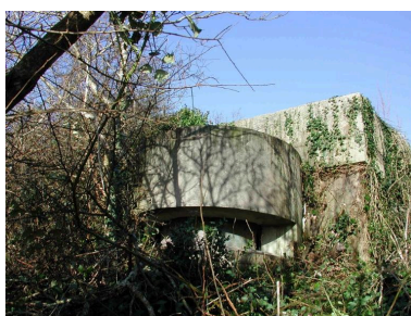
Vue du poste d'observation et de télémétrie n° 2 (état en 2003) Phot. Guillaume Lécueillier IVR53_20072905969NUCA
