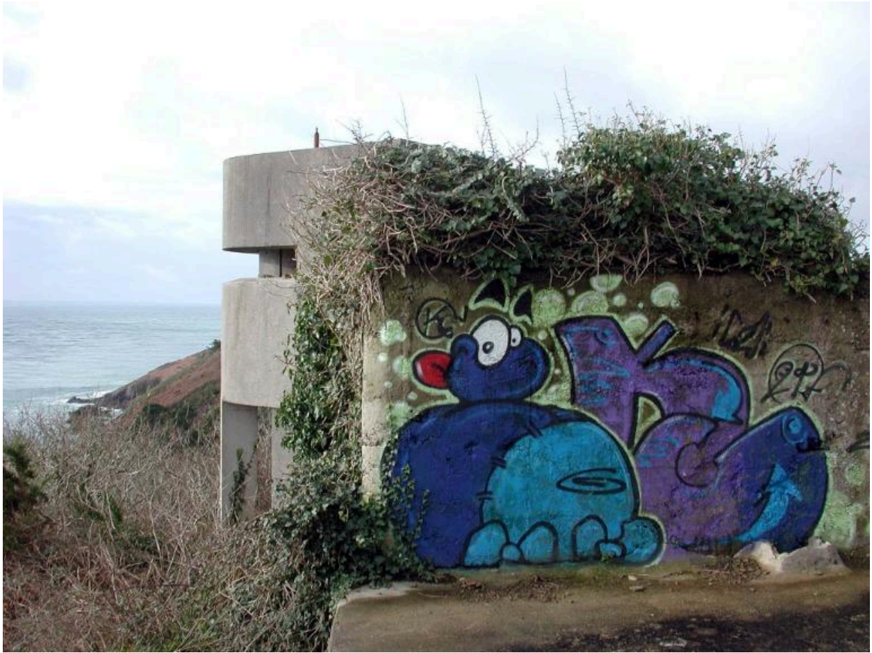
Vue du poste d'observation et de télémétrie n° 1 (état en 2003)
