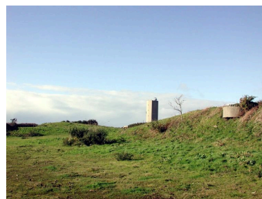
Vue du poste d'observation et de télémétrie n° 4 (état en 2003). En arrière-plan, la tour de mesures de la base d'essais du Mengant Phot. Guillaume Lécueillier IVR53_20072905957NUCA
