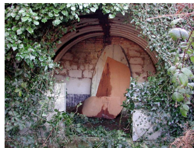
Vue d'une bunker-abri type tôle métro (état en 2003) Phot. Guillaume Lécueillier IVR53_20072905948NUCA
