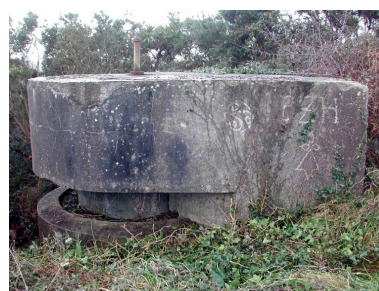
Vue du poste d'observation et de télémétrie n° 3 (état en 2003) Phot. Guillaume Lécueillier IVR53_20072905970NUCA
