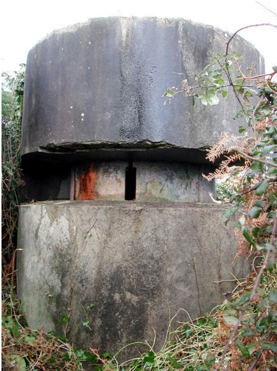
Vue du poste d'observation et de télémétrie n° 3 (état en 2003)
