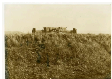
Vue du télémètre blindé du bunker-poste de direction de tir (Archives municipales de Brest : 2Fi12645 ;
