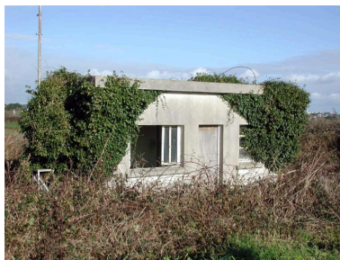
Vue d'un bunker en construction de campagne Phot. Guillaume Lécueillier IVR53_20072905947NUCA
