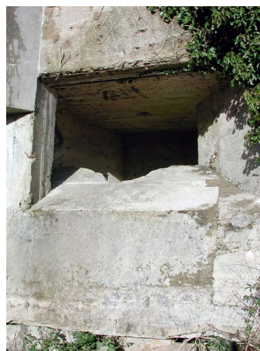
Vue du détail du poste d'observation et de télémétrie n° 1 (état en 2003) Phot. Guillaume Lécueillier IVR53_20072905964NUCA
