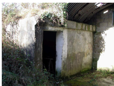
Vue d'un bunker en construction de campagne (état en 2003) Phot. Guillaume Lécueillier IVR53_20072905949NUCA
