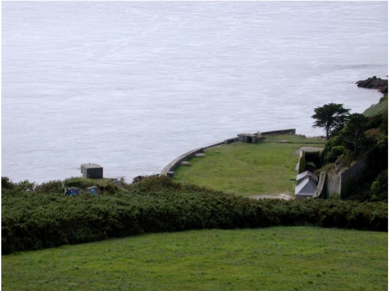
Vue de situation du poste d'observation et de télémétrie n° 1 (état en 2003). Au ras de la mer, la batterie basse du Mengant depuis Kerdalaez
