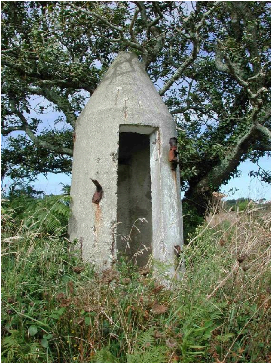
Vue de l'une des deux guérites en béton armé implantées à l'entrée de la batterie antiaérienne (état en 2002)
