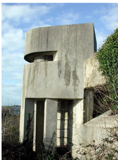
Vue du poste d'observation et de télémétrie n° 1 (état en 2003) Phot. Guillaume Lécueillier IVR53_20072905963NUCA
