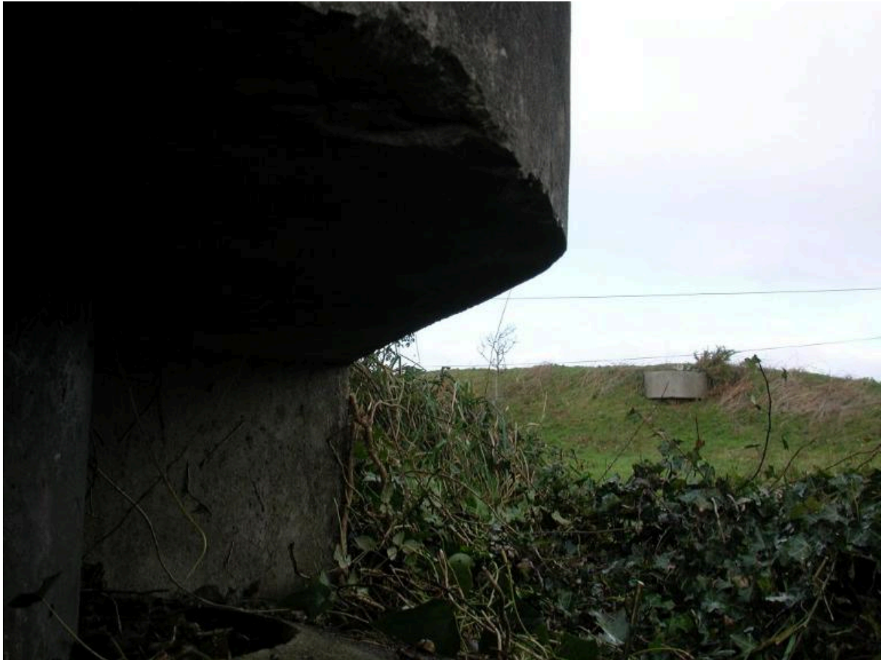
Vue du poste d'observation et de télémétrie n° 3 (état en 2003)
