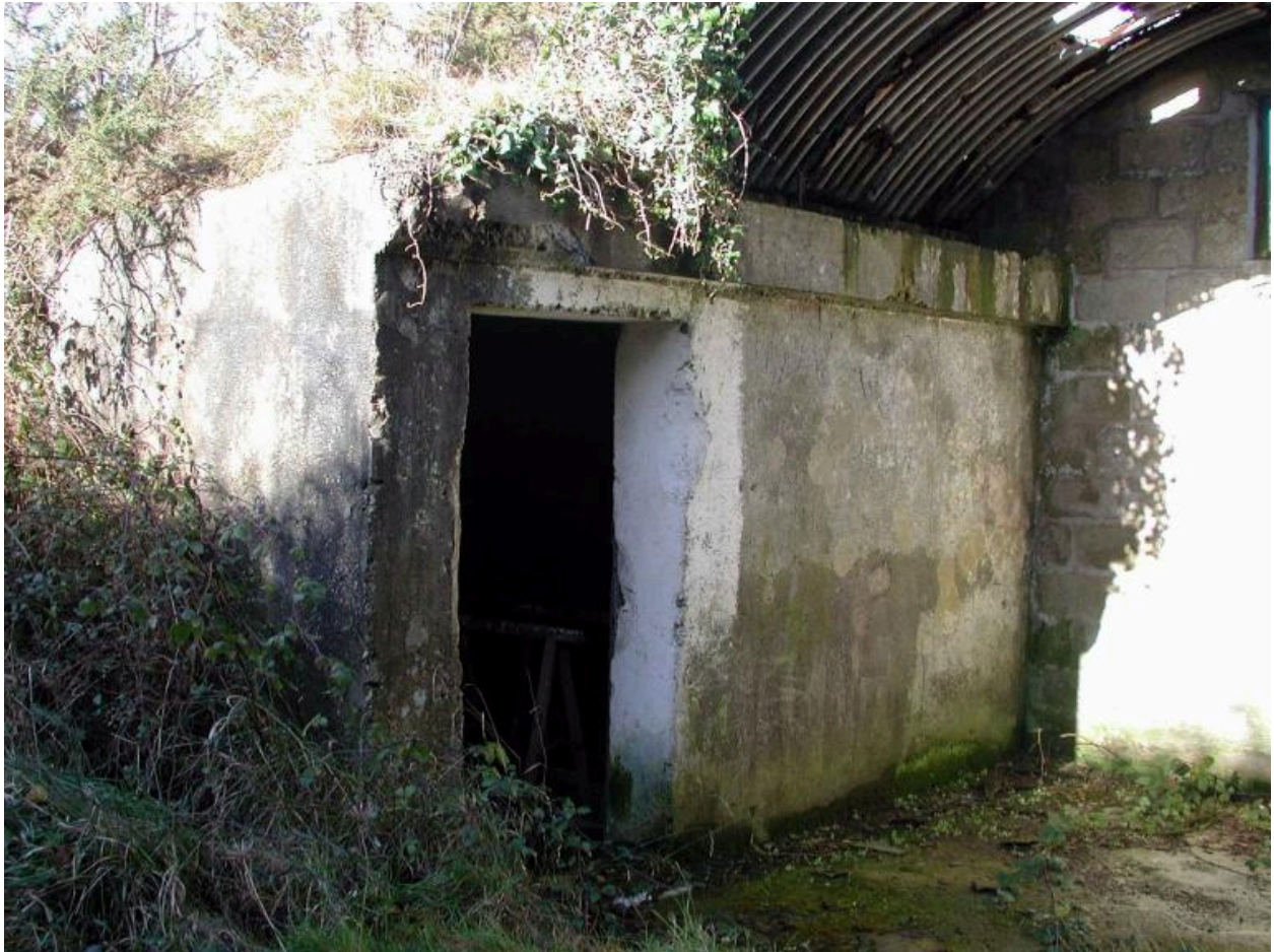
Vue d'un bunker en construction de campagne (état en 2003)
