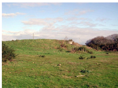
Vue du poste d'observation et de télémétrie n° 4 (état en 2003) Phot. Guillaume Lécueillier IVR53_20072905955NUCA
