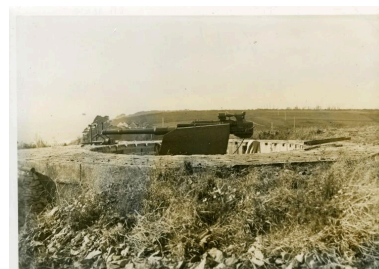
Vue de l'un des canons antiaériens de 10,5 cm de calibre (Archives municipales de Brest : 2Fi12642 ;
