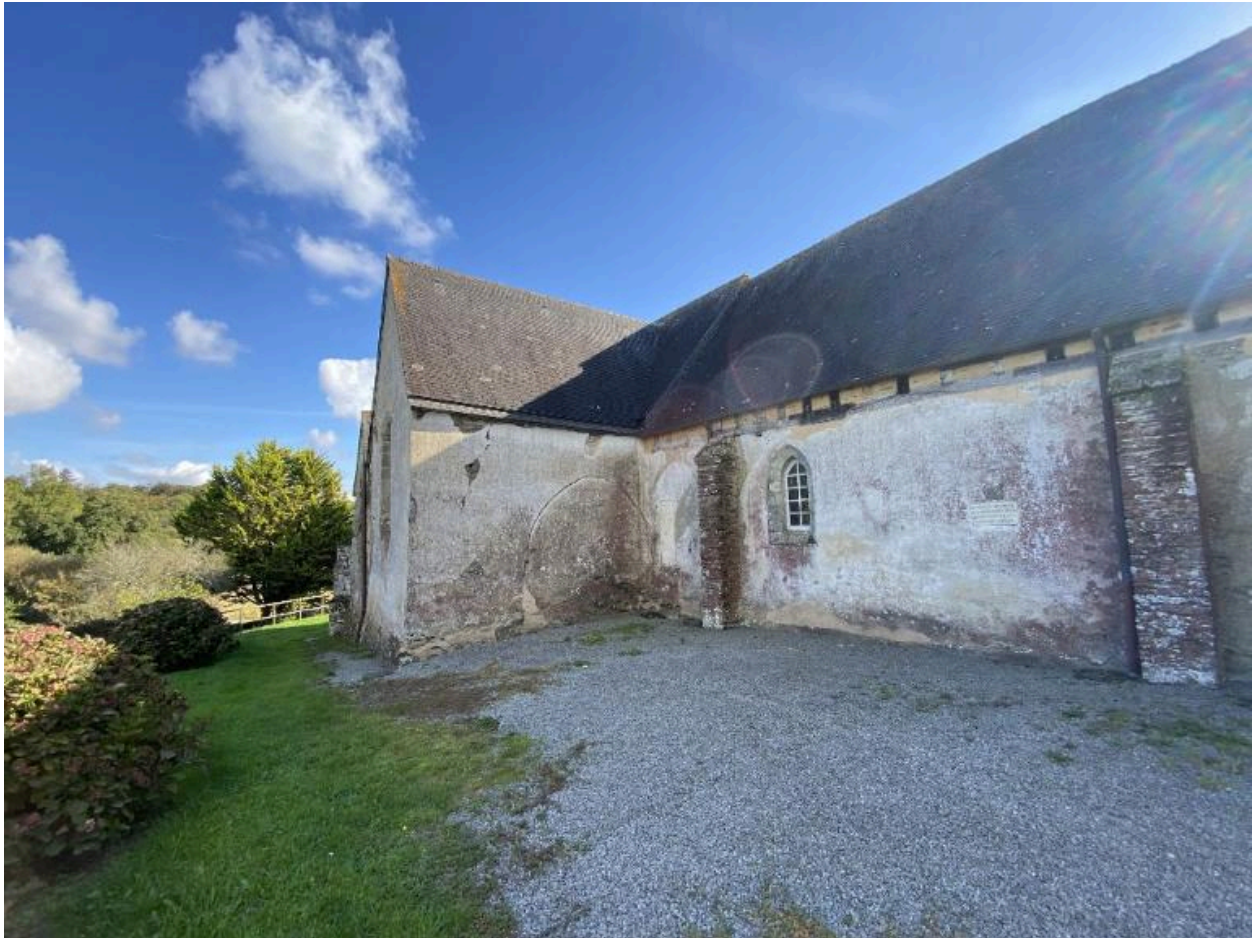
Élévation nord, vue générale
