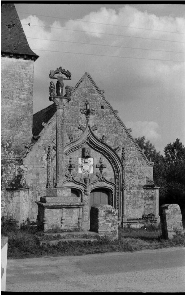
Chapelle Saint-Golven : élévation ouest : le portail
