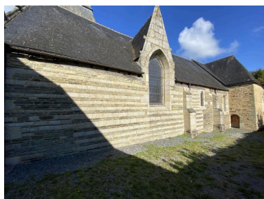
Élévation sud, vue générale Phot. Baptiste Oligo IVR53_20265610907NUCA
