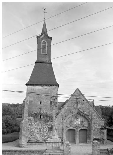
Chapelle Saint-Golven : élévation ouest (état en 1984) Phot. Norbert Lambart IVR53_19845601376V
