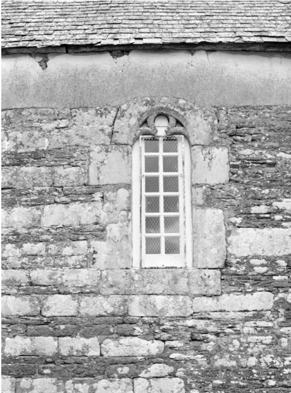
Chapelle Saint-Golven, nef, mur sud : fenêtre (état en 1984)
