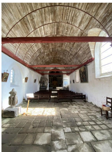
Vue générale de l'intérieur Phot. Baptiste Oligo IVR53_20265610904NUCA
