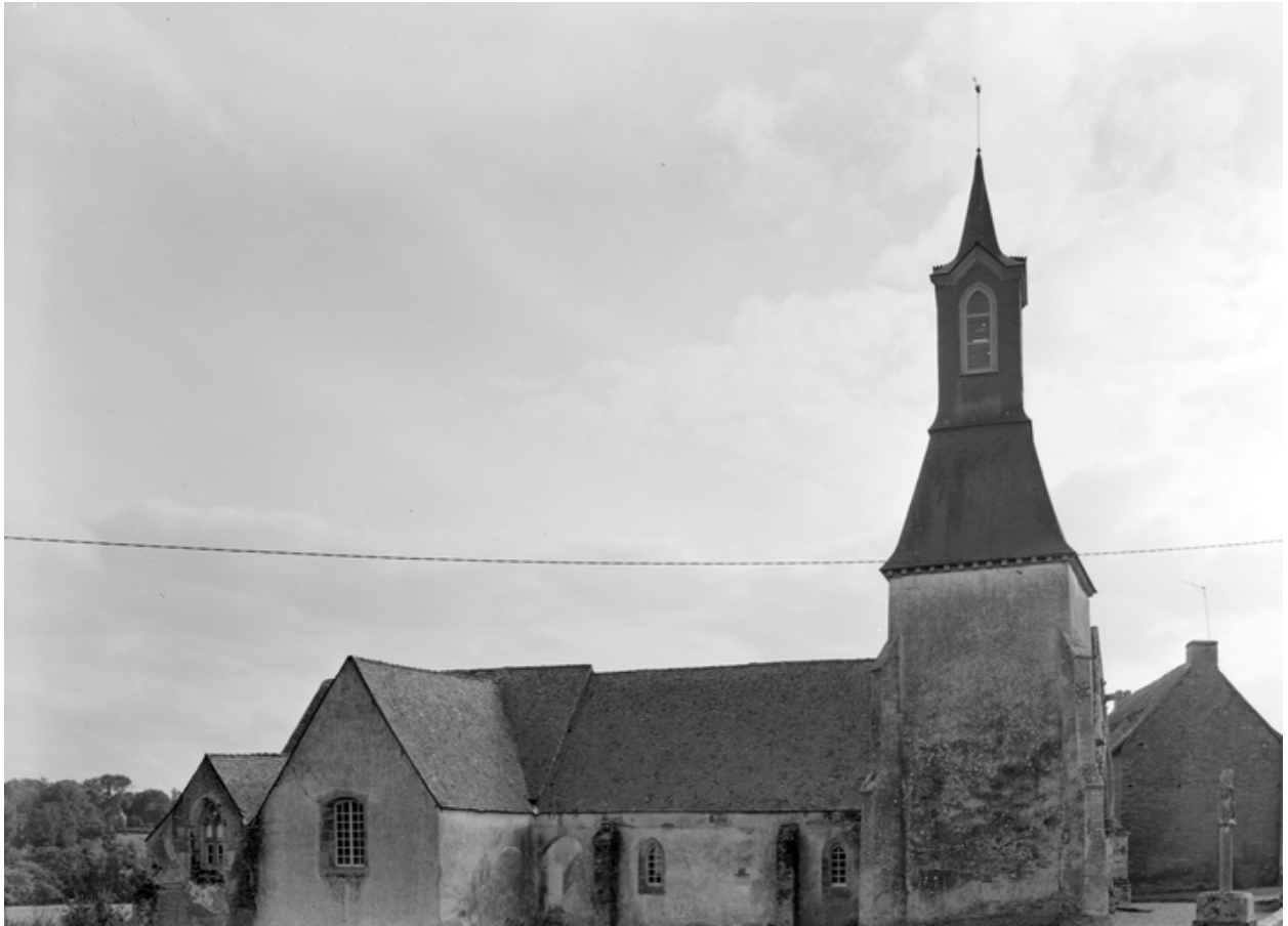
Chapelle Saint-Golven : élévation nord (état en 1984)
