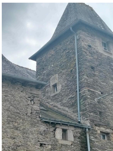
Façade nord, détail Phot. Michèle Bureau IVR53_20265610844NUCA
