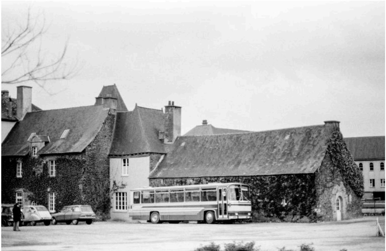
Vue sud-est (état en 1974)
