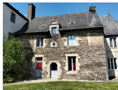
Façade sud, détail Phot. Michèle Bureau IVR53_20265610850NUCA
