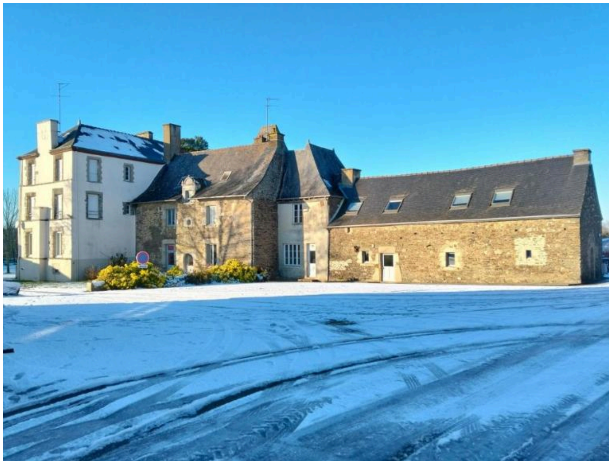
Façade sud, vue générale
