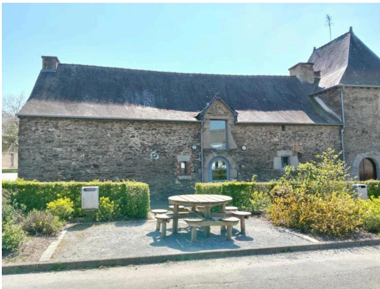
Façade nord, détail
