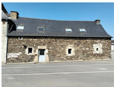
Façade sud, détail Phot. Michèle Bureau IVR53_20265610846NUCA
