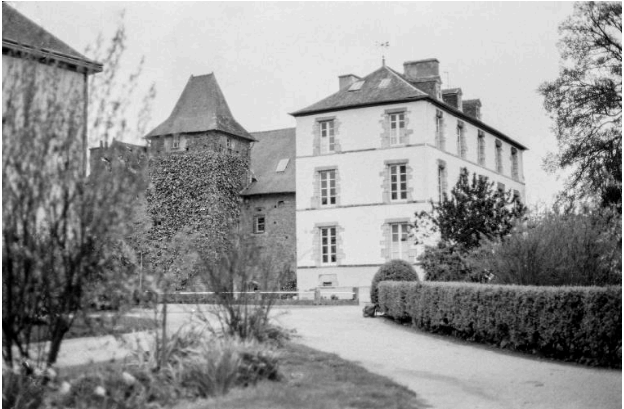
Vue nord (état en 1974)
