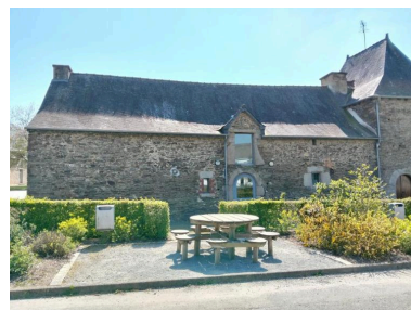
Façade nord, détail Phot. Michèle Bureau IVR53_20265610845NUCA
