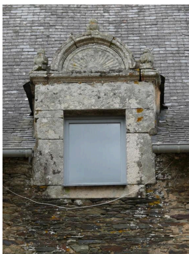
Lucarne Renaissance, façade sud, détail Phot. Michèle Bureau IVR53_20265610843NUCA
