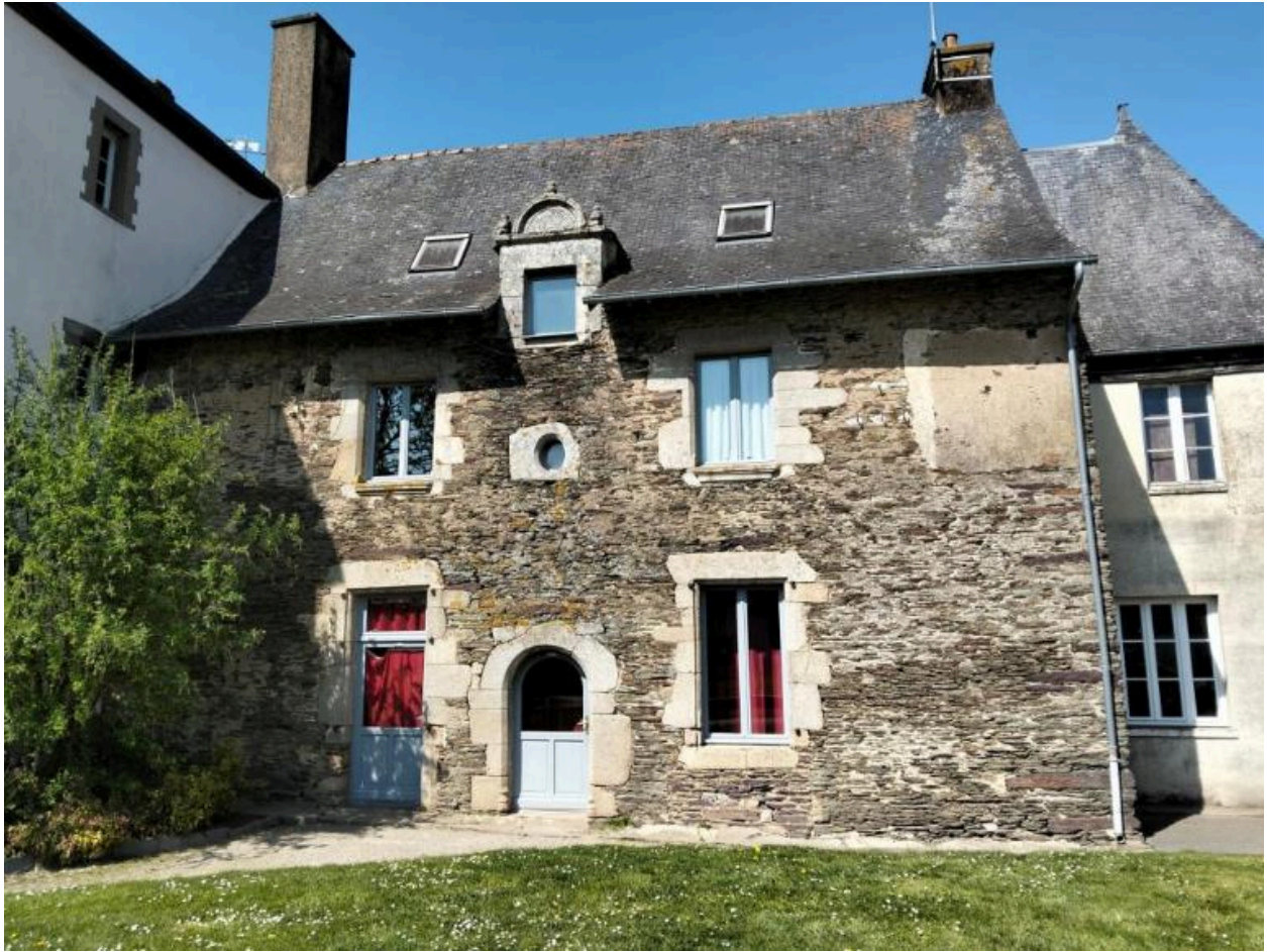
Façade sud, détail
