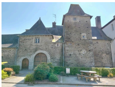
Façade nord, vue générale Phot. Michèle Bureau IVR53_20265610847NUCA
