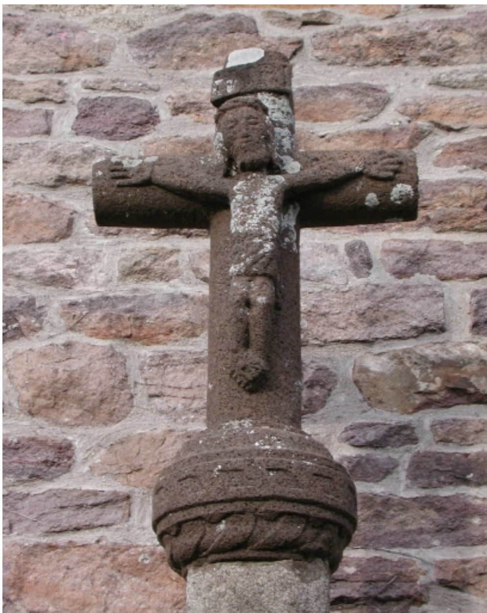
Vue détaillée du croisillon.
