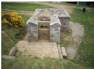
Vue du four à boulets Phot. Guy Prigent IVR53_20082213424NUCA
