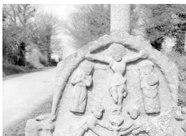
Croix de chemin, face portant le Calvaire (état en 1985) Phot. Loïck Lamandé IVR53_19855600286X
