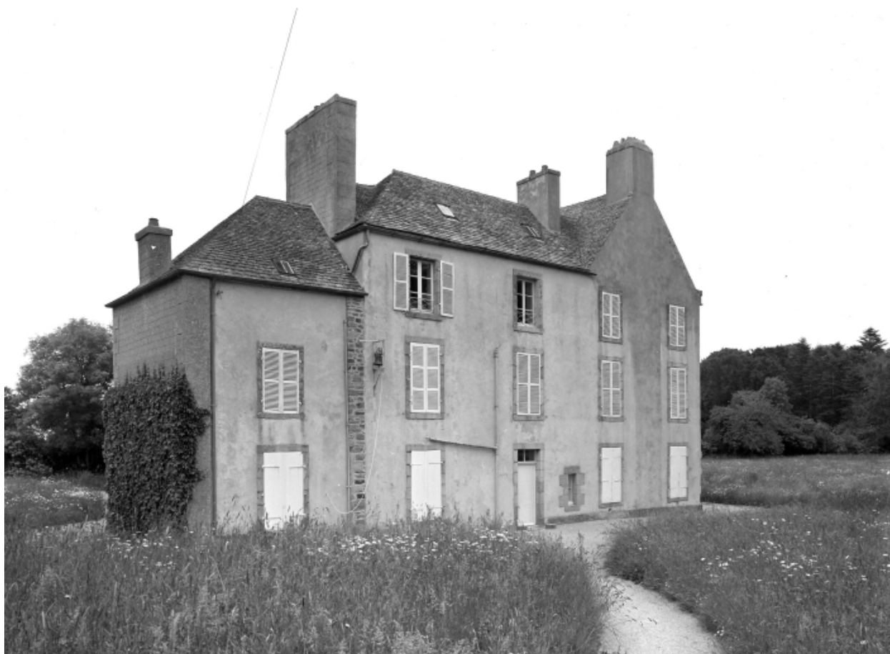
Logis, élévation sud, vue générale
