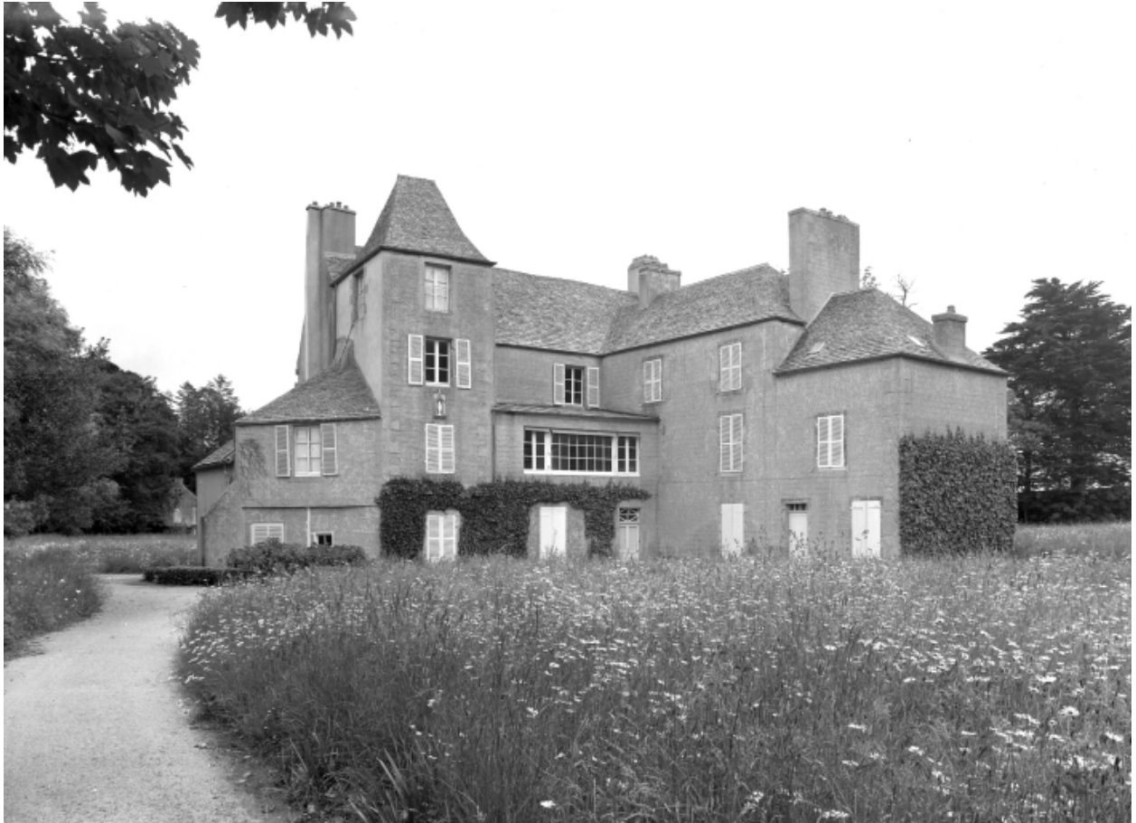
Logis, élévation ouest, vue générale
