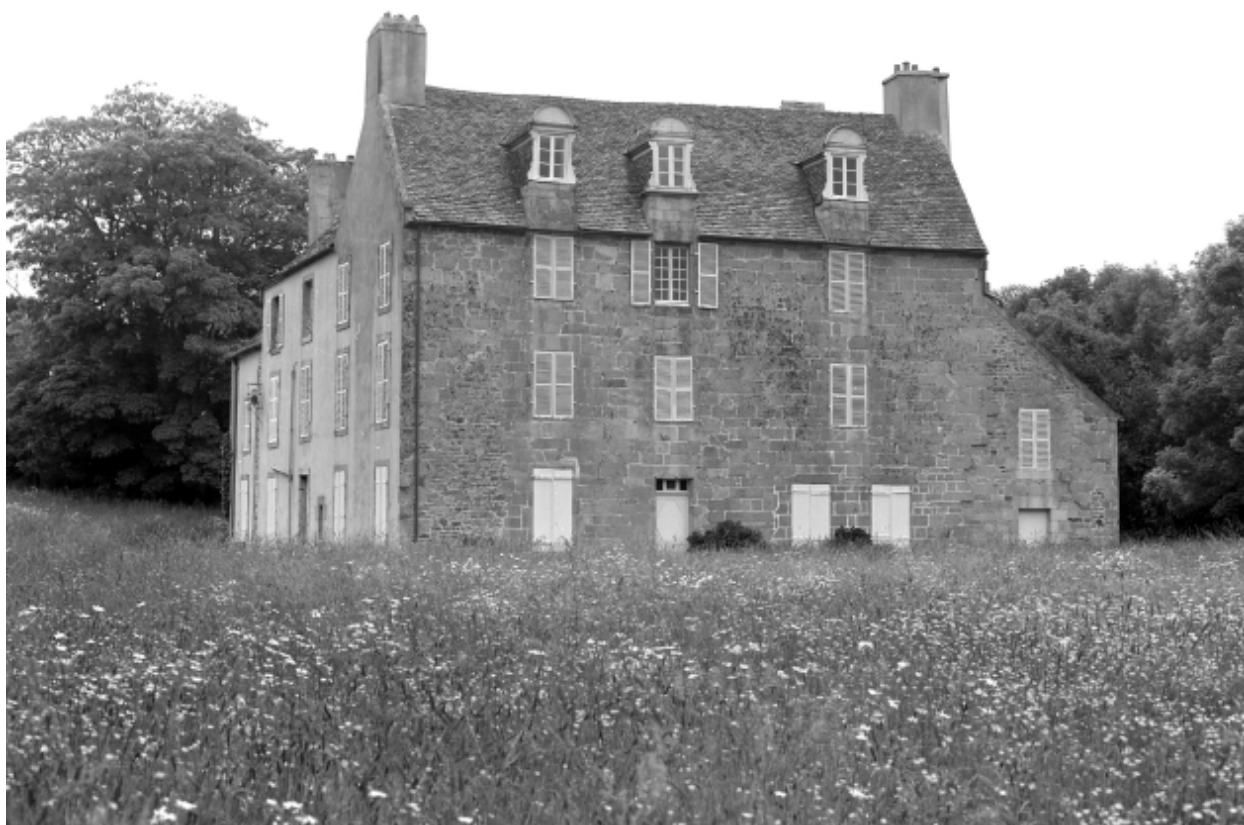
Logis, élévation est, vue générale
