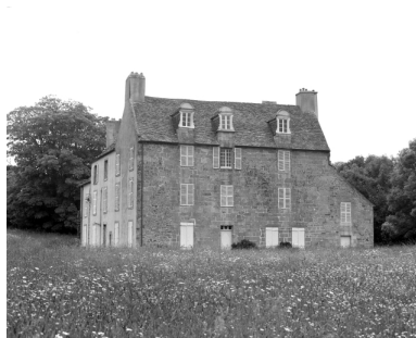
Logis, élévation est, vue générale Phot. Guy Artur, Phot. Norbert Lambart IVR53_19842900869X
