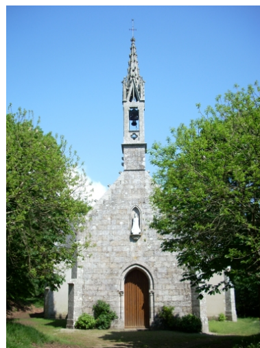
Plogonnec, chapelle Notre-Dame-de-Lorette : élévation ouest Phot. Gwénaél Fauchille IVR53_20082905920NUCA
