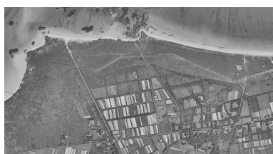
Vue aérienne verticale : partie centrale (1950-1965). Le fossé antichar est bien visible Phot. Institut national géographique et forestière IVR53_20252910935NUC
