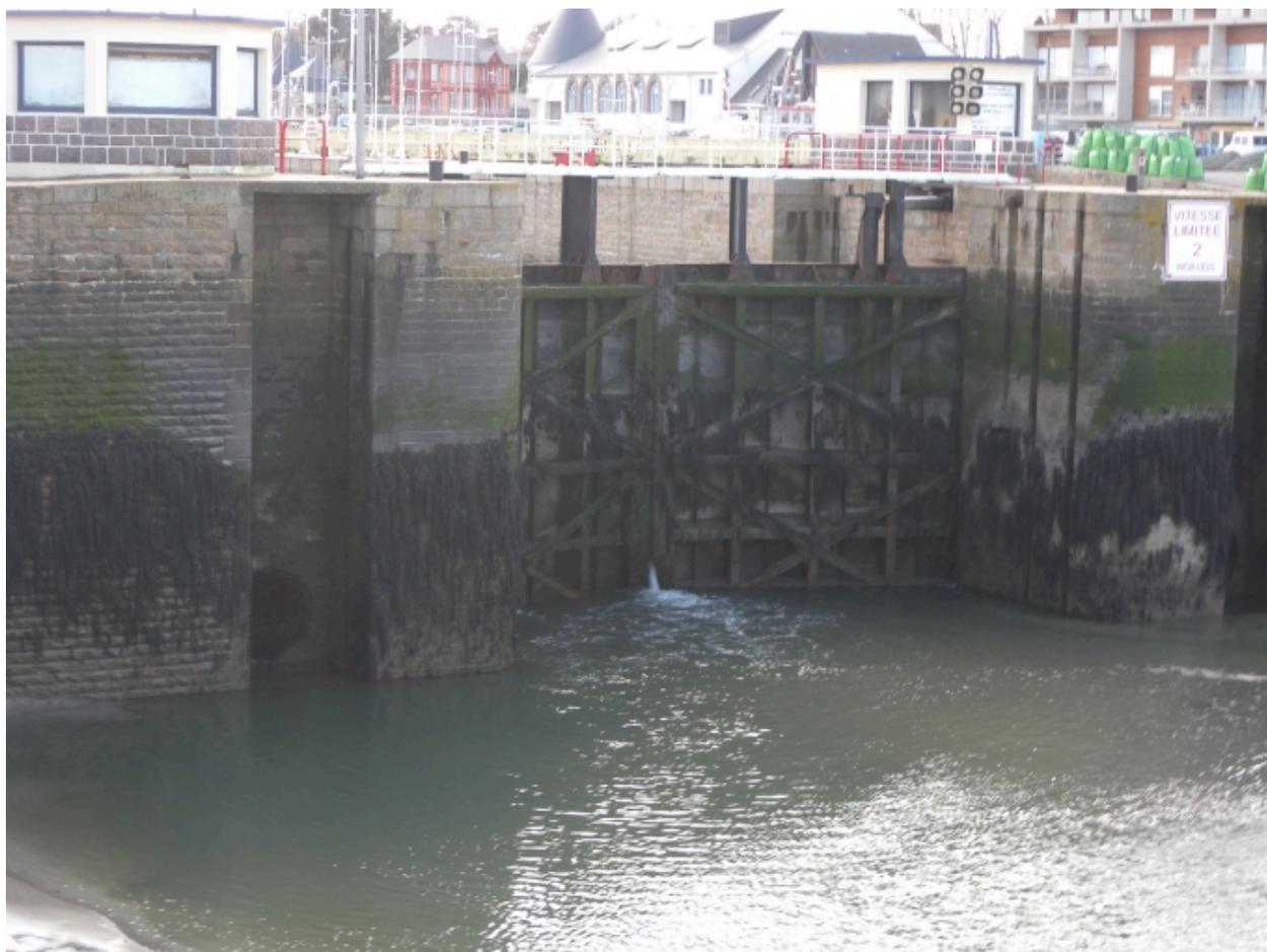
Vue des portes de l'écluse et des vannes de l'aqueduc
