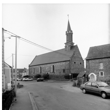
Elévation Sud-Est : vue générale Phot. Bernard Bègne, Phot. M. Loyon IVR53_19933500467X
