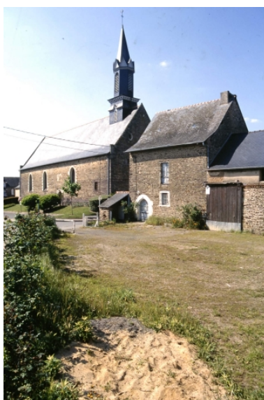
Vue générale prise du sud-ouest. Phot. Claude Quillivic IVR53_19943502492ZA
