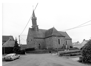
Elévation Nord-Est : vue générale Phot. Bernard Bègne, Phot. M. Loyon IVR53_19933500470X
