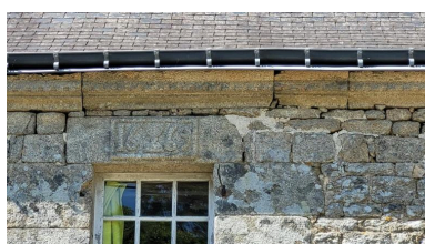
Linteau sculpté, façade sud Phot. Nathalie Vedovotto IVR53_20265610873NUCA
