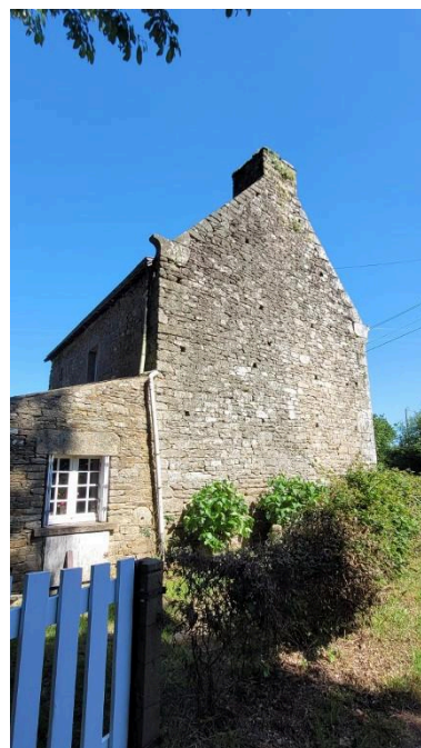
Pignon ouest, vue générale Phot. Nathalie Vedovotto IVR53_20265610874NUCA
