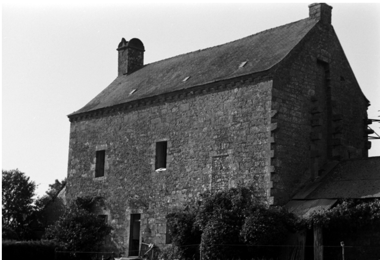
Vue de la façade sud
