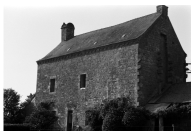
Vue de la façade sud
