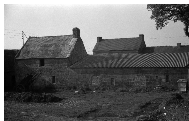
Communs au nord : élévation sud Phot. Brulon IVR53_19662200518Z
