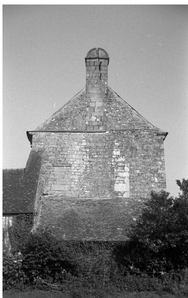
Elévation ouest Phot. Brulon IVR53_19662200519Z
