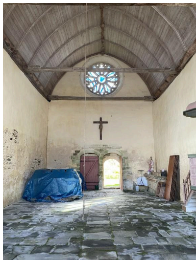
Vue générale de l'intérieur Phot. Baptiste Oligo IVR53_20265610599NUCA
