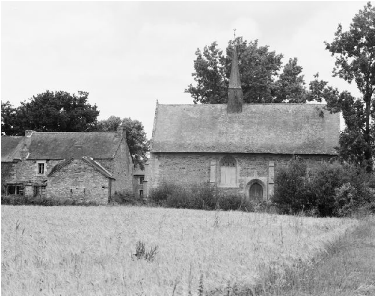
Vue de situation prise du sud
