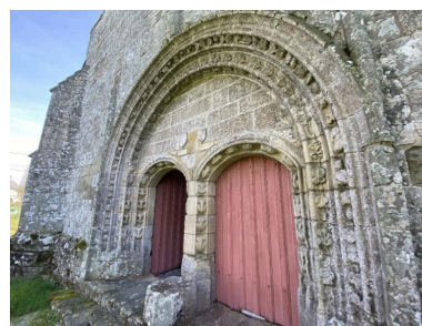
Portail ouest, vue générale Phot. Baptiste Oligo IVR53_20265610608NUCA
