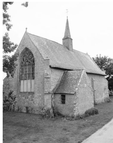
Vue nord-est Phot. Guy Artur, Phot. Norbert Lambart IVR53_19915600555X
