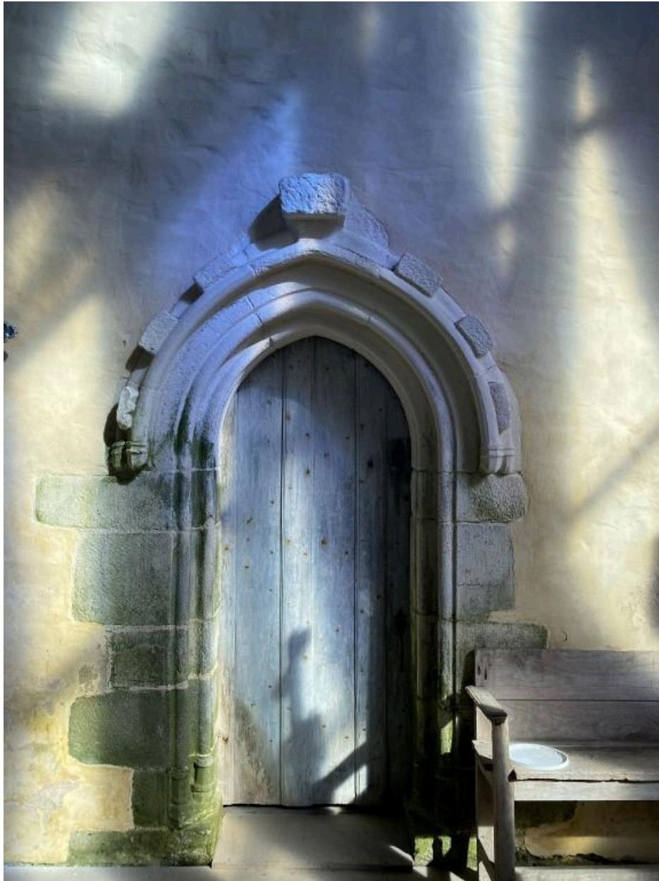
Porte, élévation nord, vue depuis l'intérieur de l'édifice
