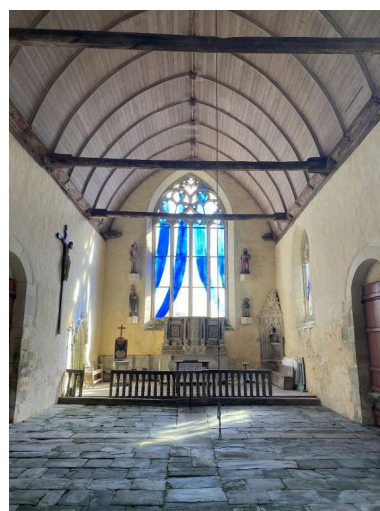
Vue générale de l'intérieur Phot. Baptiste Oligo IVR53_20265610597NUCA
