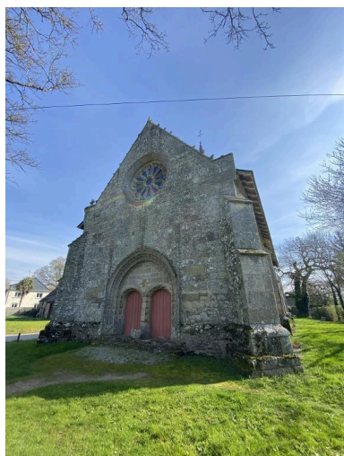
Élévation ouest Phot. Baptiste Oligo IVR53_20265610594NUCA
