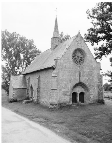
Vue nord-ouest Phot. Guy Artur, Phot. Norbert Lambart IVR53_19915600552X
