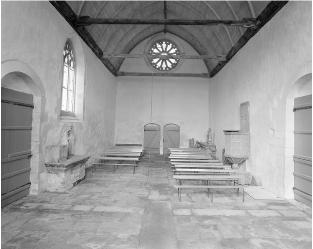
Vue générale vers la nef
