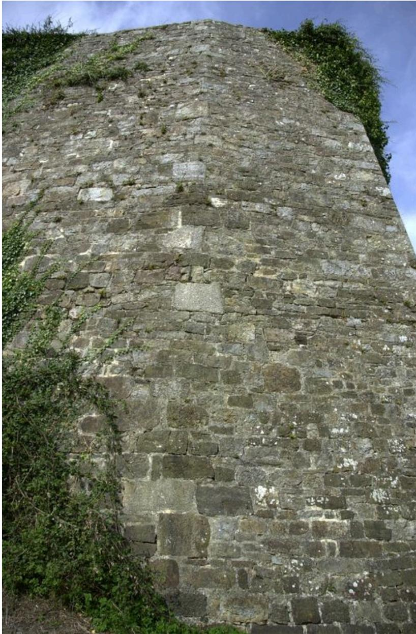
Vue du fort de Lanvéoc : demi-bastion de l'extrémité est, détail du liaisonnement du parement. Chaîne en granite
