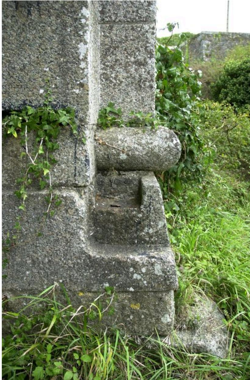
Vue de détail de la porte monumentale datée de 1878 : support en granite du pont-levis basculant (état en 2007)
