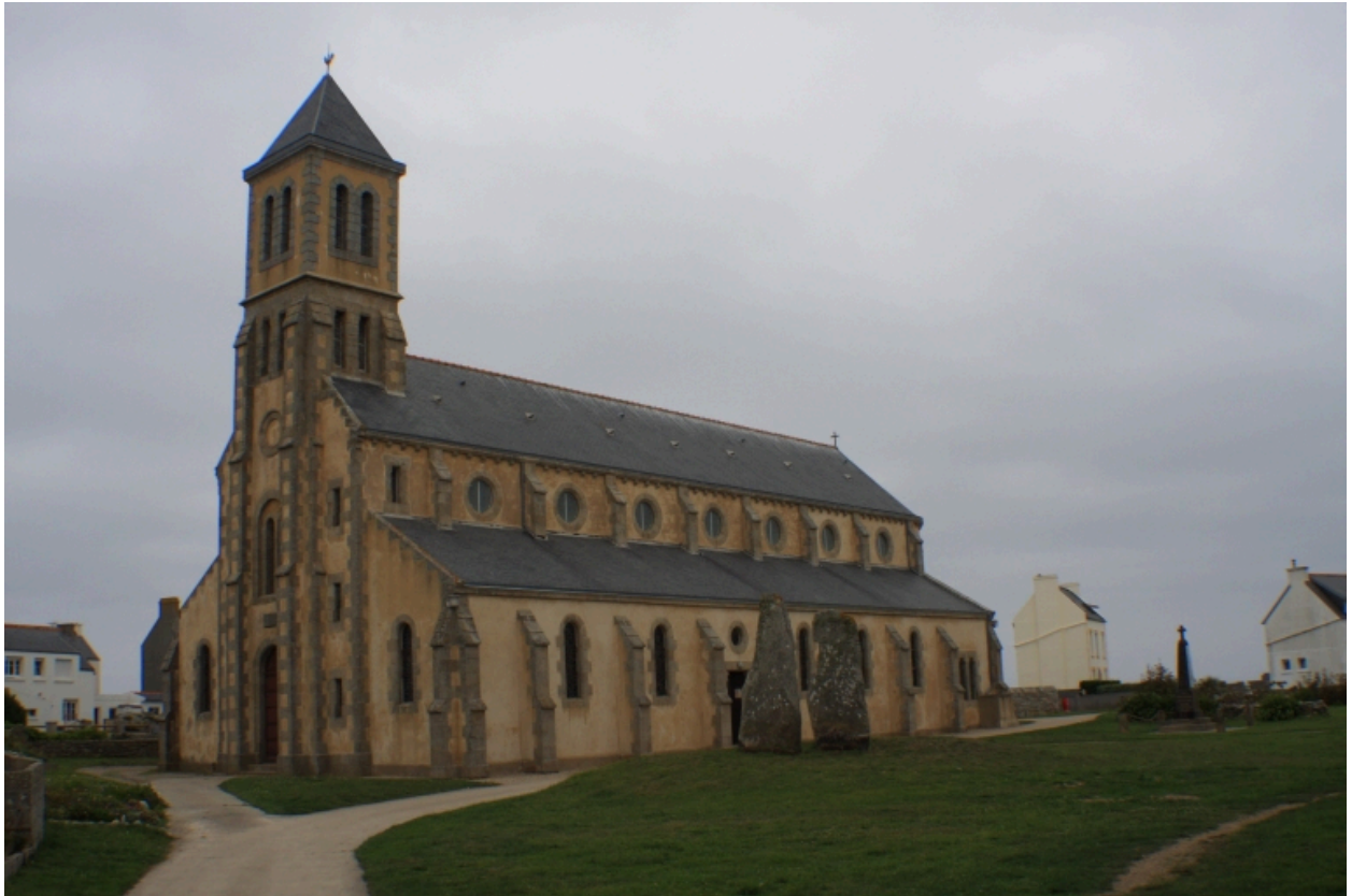
Ile-de-Sein, église paroissiale Saint-Collodan et Saint-Guénoles : vue générale sud-ouest
