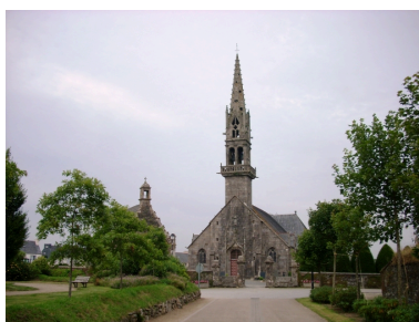
Ploudiry, église paroissiale Saint-Pierre : vue générale ouest Phot. Gwénaél Fauchille IVR53_20082906428NUCA
