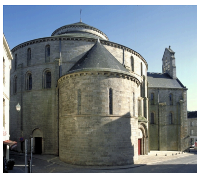
Quimperlé, église paroissiale Sainte-Croix : vue générale nord-ouest Phot. Bernard Bègne IVR53_20022900509XA
