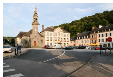
Port-Launay, église paroissiale Saint-Nicolas : vue générale nord-ouest Phot. Florent Maillard IVR53_20082906709NUCA
