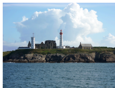
Plougonvelin, chapelle Notre-Dame-des-Grâces à Saint-Mathieu : vue de situation depuis le sud Phot. Gwénaél Fauchille IVR53_20082906246NUCA
