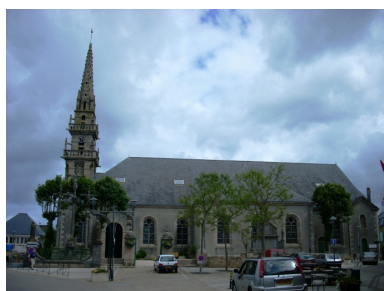
Plouguerneau, église paroissiale Saint-Pierre et Saint-Paul : élévation sud Phot. Gwénaél Fauchille IVR53_20082906097NUCA
