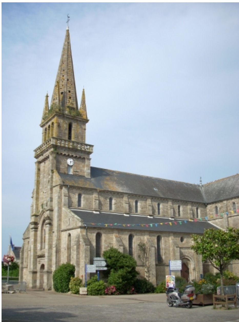
Lanmeur, église paroissiale Saint-Mélar : élévation ouest
