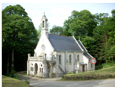
Plonéis, chapelle Sainte- Anne : vue générale sud-ouest Phot. Gwénaél Fauchille IVR53_20082906239NUCA
