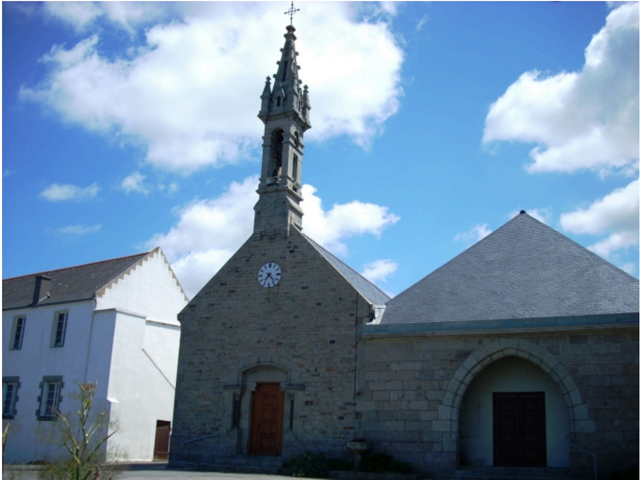
Ploudalmézeau, église paroissiale Notre-Dame de Portsall : vue générale ouest
