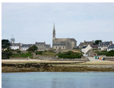
Ile-de-Batz, église paroissiale Notre- Dame : vue de situation depuis le sud Phot. Gwénaél Fauchille IVR53_20082906553NUCA
