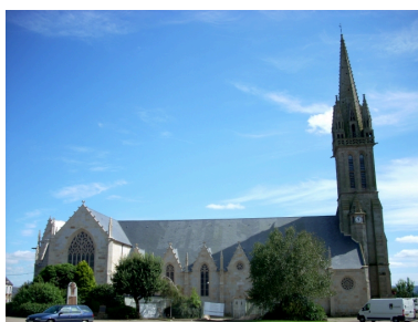
Plouigneau, église paroissiale Saint-Ignace : élévation nord Phot. Gwénaél Fauchille IVR53_20082906634NUCA
