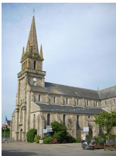
Lanmeur, église paroissiale Saint-Mélar : élévation ouest Phot. Gwénaél Fauchille IVR53_20082906526NUCA
