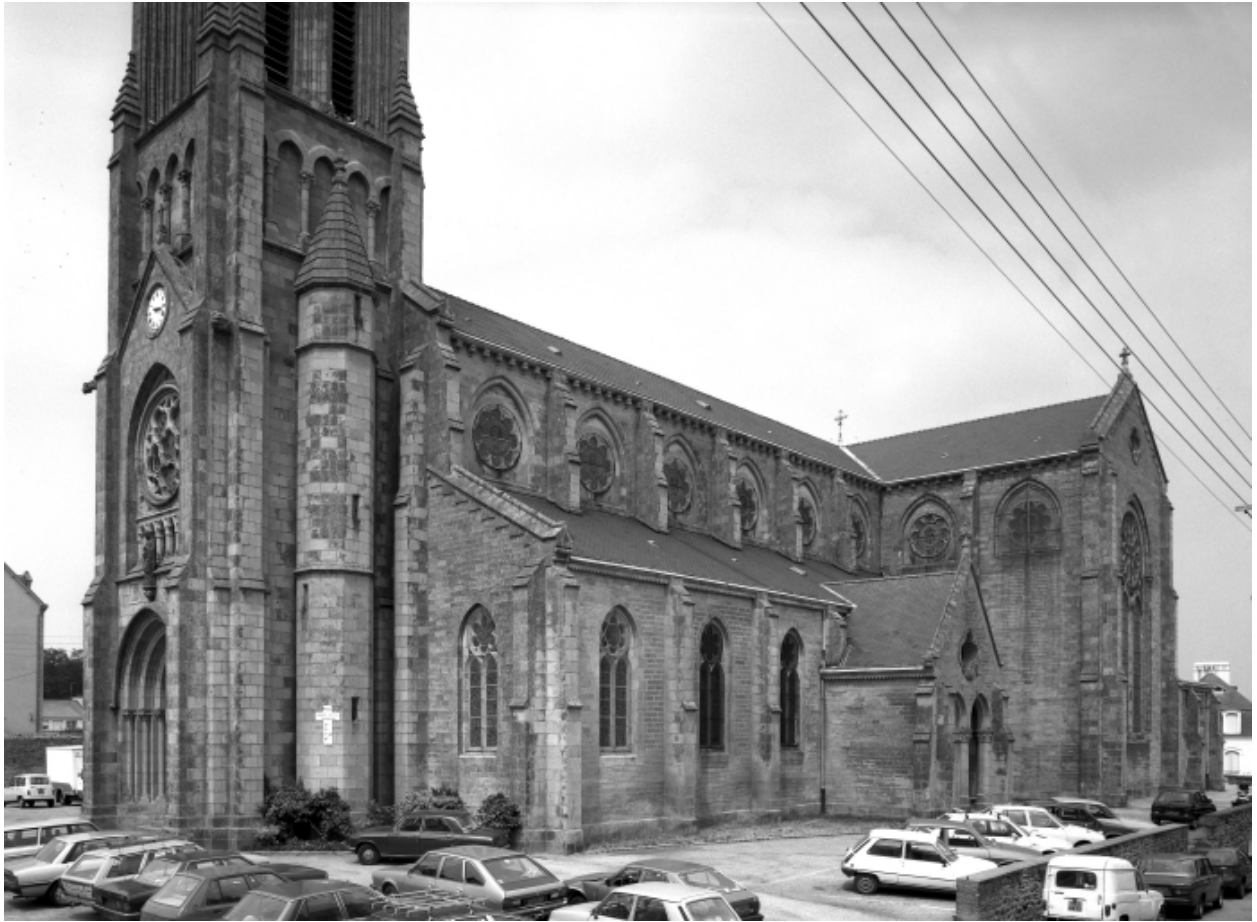
Douarnenez, église paroissiale du Sacré-Coeur : vue générale sud-ouest
