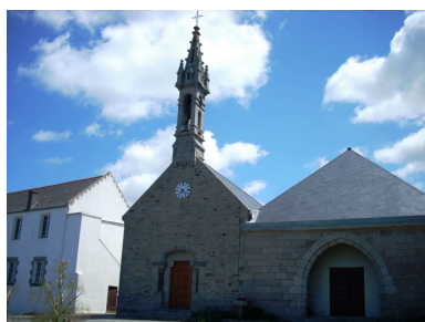
Ploudalmézeau, église paroissiale Notre-Dame de Portsall : vue générale ouest Phot. Gwénaél Fauchille IVR53_20082906162NUCA
