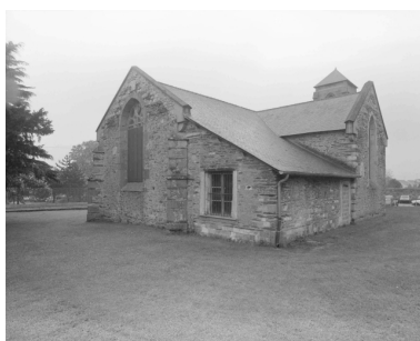
Vue de l'église et de l'enclos depuis le nord-est
