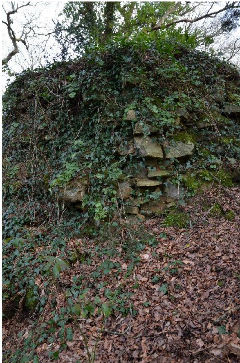
Vue du pied de la tour : maçonnerie de moellon montée à la terre
