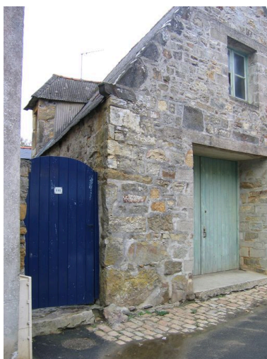
Maison au 8 bis rue de Bruxelles Phot. Françoise Péron IVR53_20062908415NUCA
