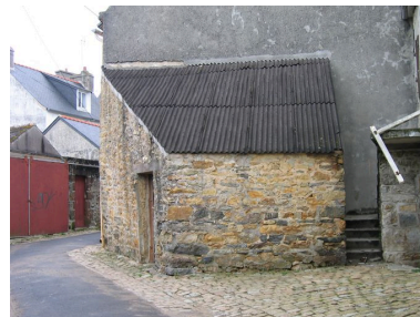
Maison au 9 rue de Bruxelles avec escalier extérieur Phot. Françoise Péron IVR53_20062908414NUCA
