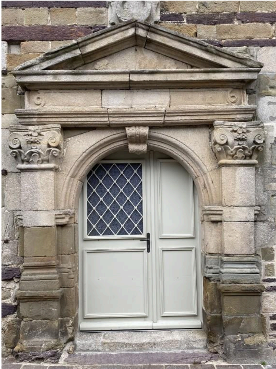
Porte, détail, façade est
