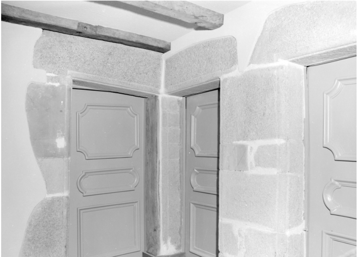
Maison : le palier de l'étage (état en 1985)
