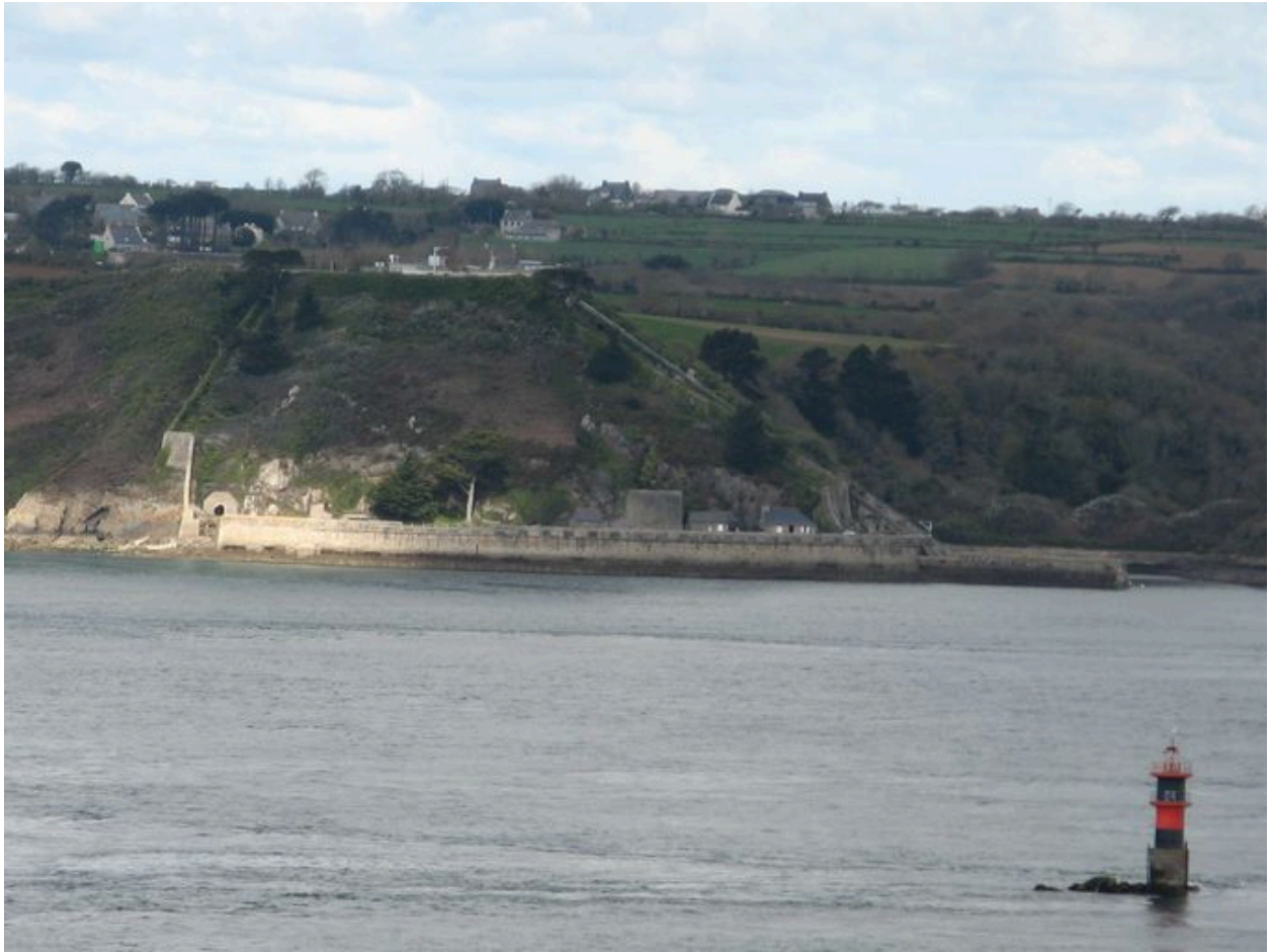
Tourelle de la Roche Mengant et batterie de Mengant (Plouzané)
