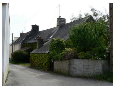
Rue de l'écart de la Grange Phot. Julien Amghar IVR53_20082908616NUCA
