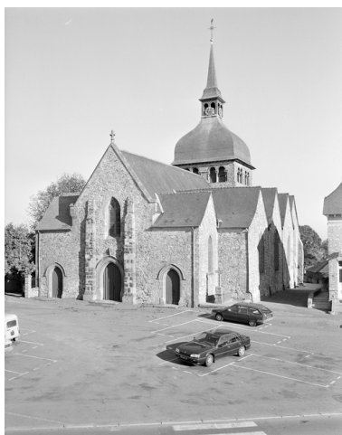
Vue générale. Phot. Service régional de l'Inventaire de Bretagne IVR53_19983500036X
