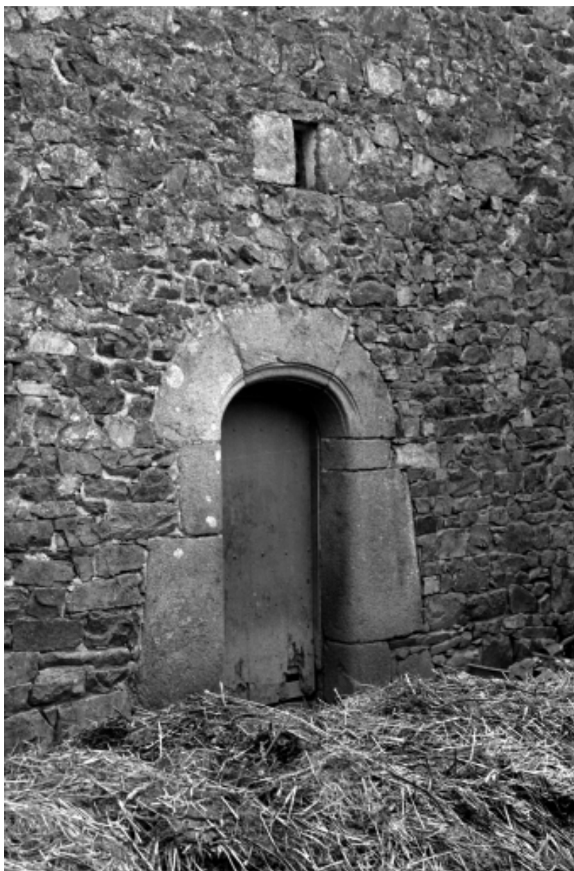
Détail, façade postérieure (cliché S. Laffiché, pré-inventaire, 1973)
