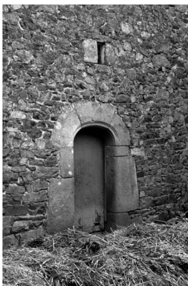
Détail, façade postérieure (cliché S. Laffiché, pré-inventaire, 1973)
