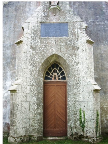
Bannalec, chapelle Notre-Dame-des-Neiges : porche occidental Phot. Gwénaél Fauchille IVR53_20082905565NUCA
