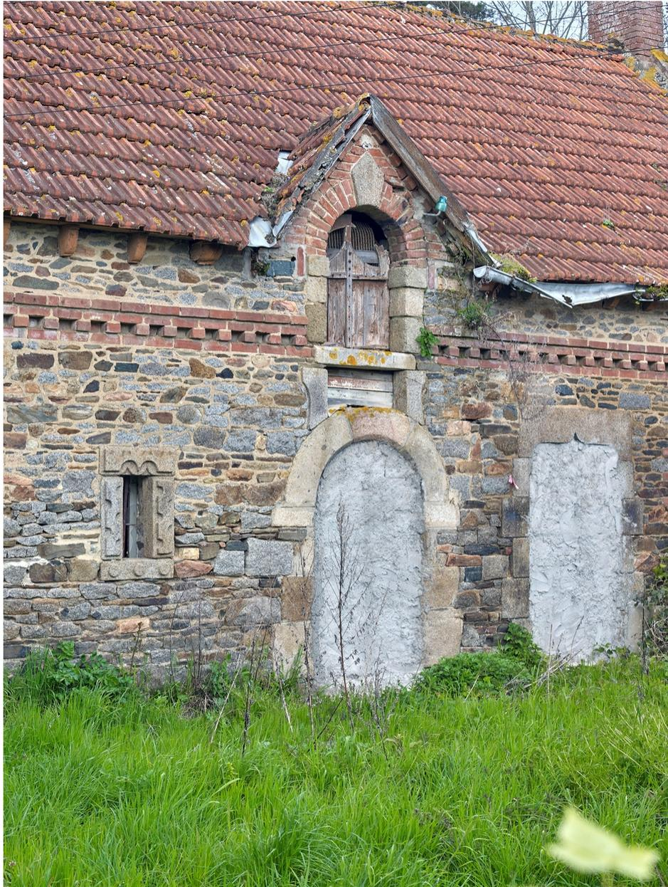
Vue du logis de la ferme modèle : détail de l'élévation principale orientée vers le Sud-est associant moellons, briques et couverture en tuile. On peut voir des remplois : linteaux et piédroits des ouvertures en pierre de taille de granite
