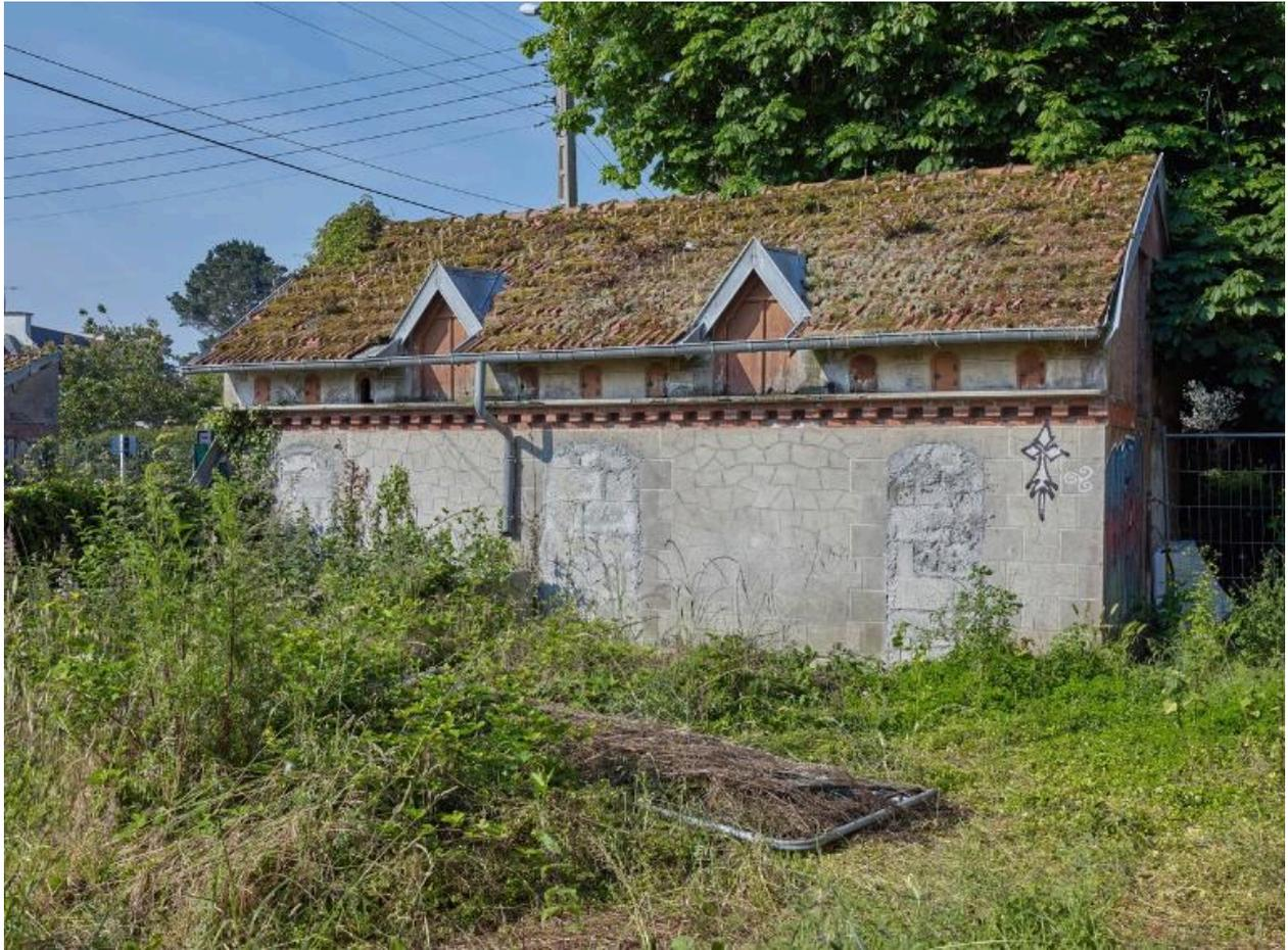
Vue de la ferme de Le Bourrivet / du Bourrivet : dépendance Ouest à usage d'étable et pigeonnier (doté de deux lucarnes de forme triangulaire). L'enduit peint figure un appareillage polygona. Ses ouvertures sont murées
