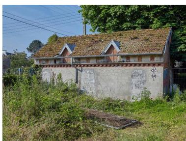
Vue de la ferme de Le Bourrivet / du Bourrivet : dépendance Ouest à usage d'étable et pigeonnier (doté de deux lucarnes de forme triangulaire). L'enduit peint figure un appareillage polygone. Ses ouvertures sont murées
