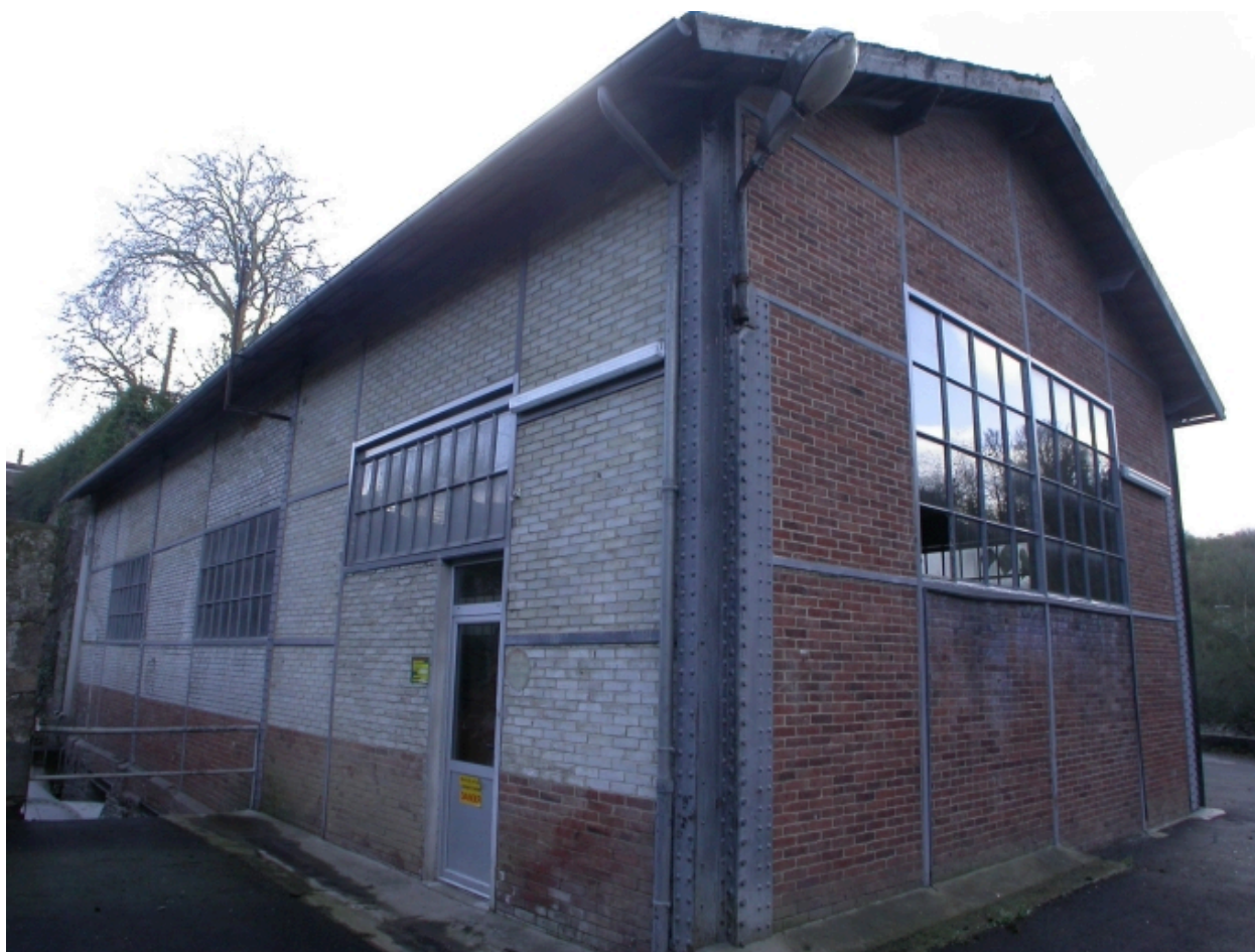
La salle des machines édifée en briques avec ossature métallique rivetée, vue générale nord-est.
