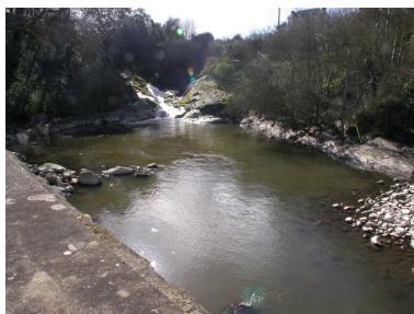
Les eaux du Gouessant s'écoulant après leur passage dans le vannage de décharge et le déversoir. Phot. Marina Gasnier IVR53_20042203091NUCA
