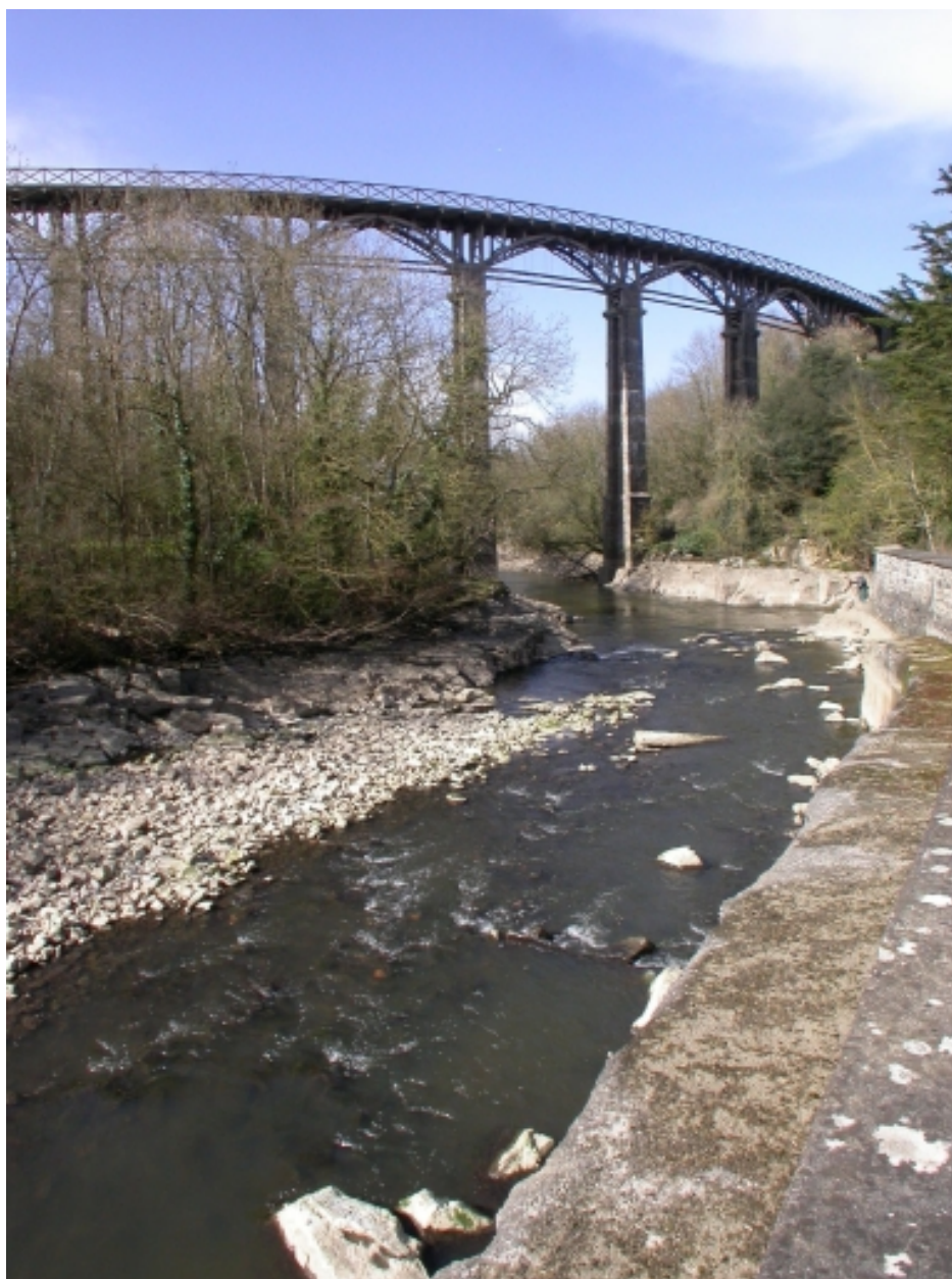
Les eaux du Guessant s'écoulant près de la centrale.
