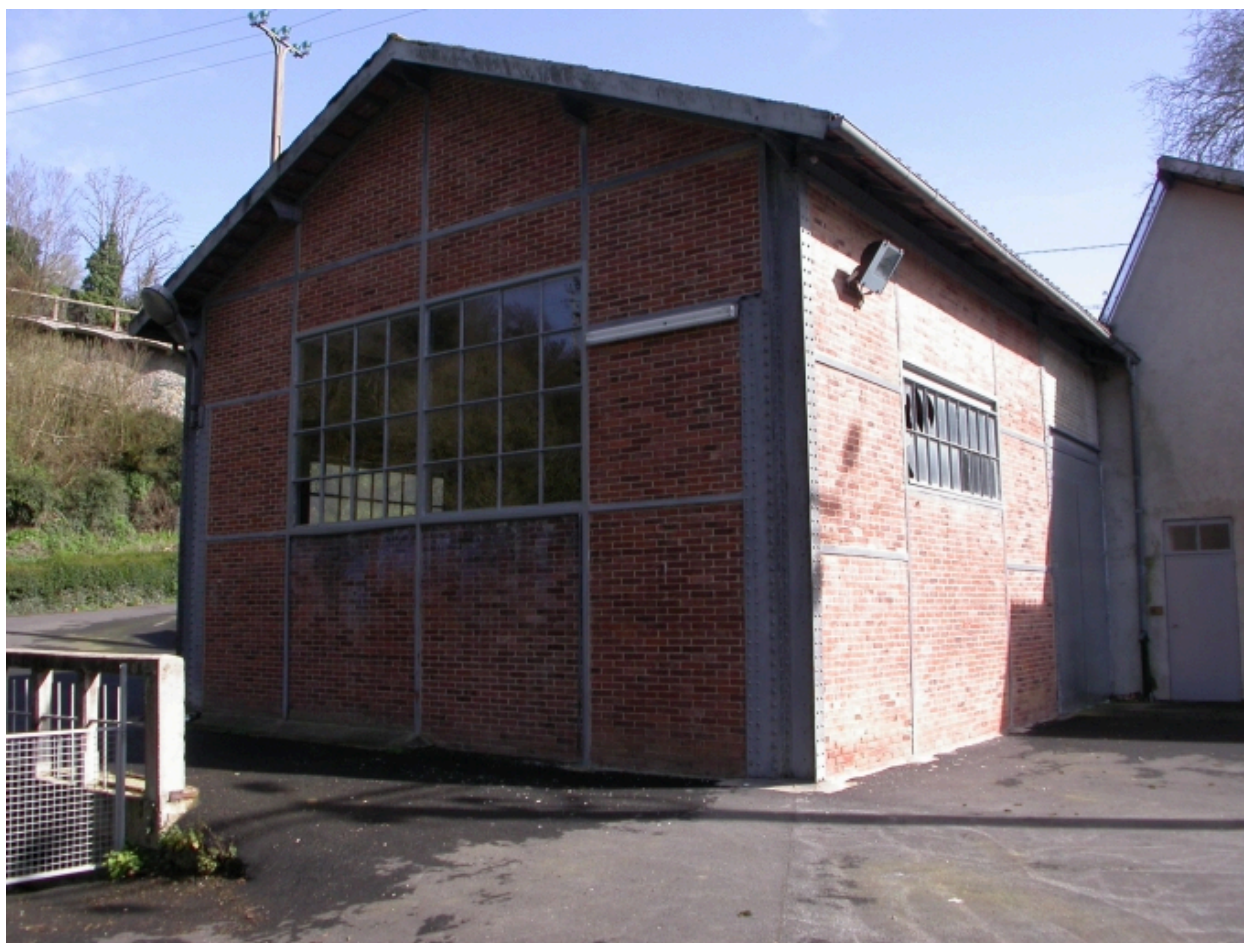
La salle des machines, vue générale nord-ouest.
