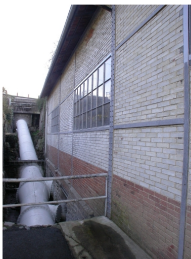
La salle des machines (façade est) et la conduite forcée. Phot. Marina Gasnier IVR53_20042203078NUCA
