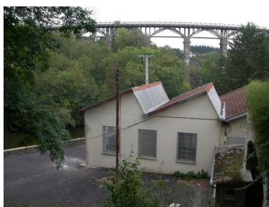
La "salle de relayage" couverte de sheds, façade sud. Phot. Marina Gasnier IVR53_20032207632NUCA
