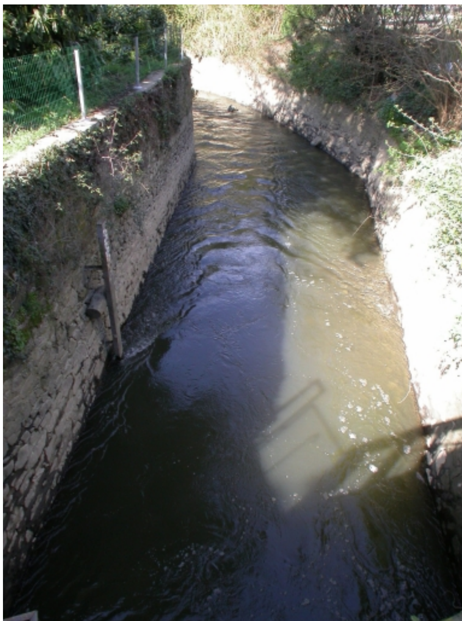
Canal de fuite : les eaux motrices après leur passage dans les turbines.
