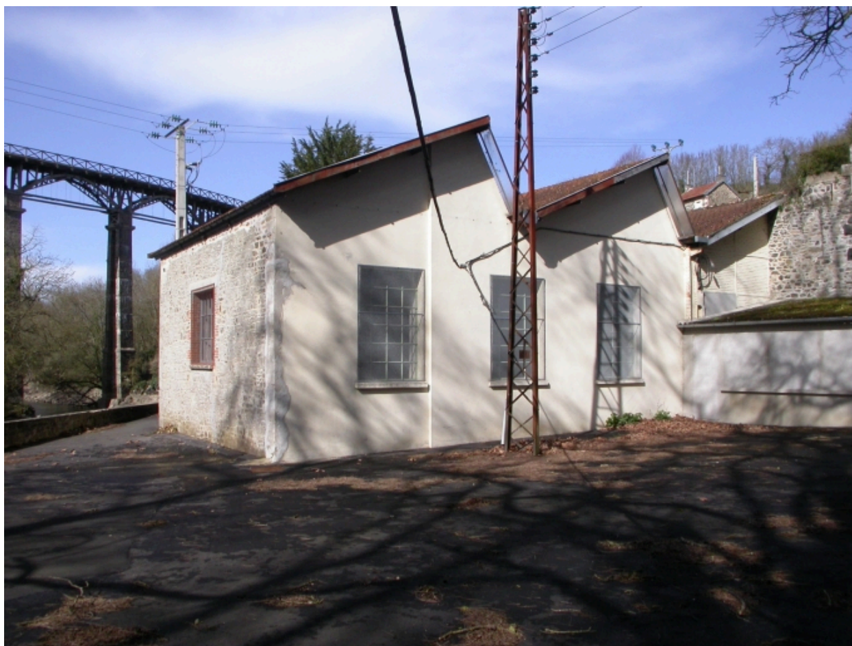
La "salle de relayage", façade sud.
