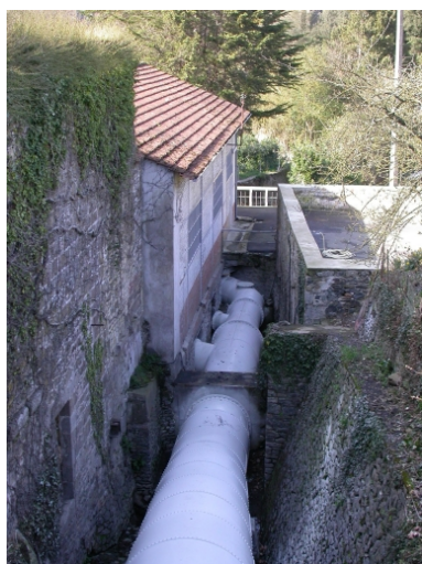
La salle des machines et la conduite forcée qui amène l'eau aux turbines. Phot. Marina Gasnier IVR53_20042203082NUCA
