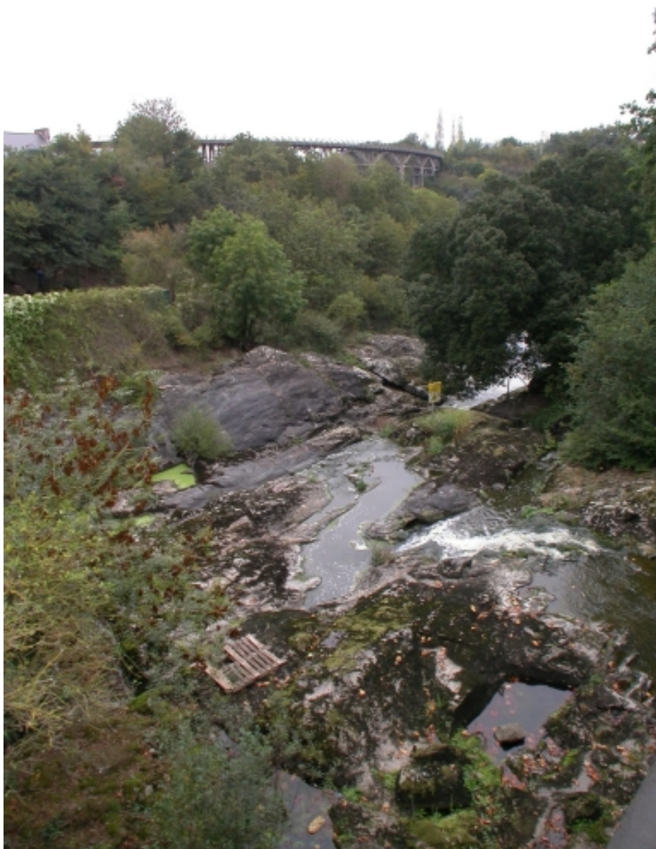
Déversoir placé à l'ouest de la centrale.
