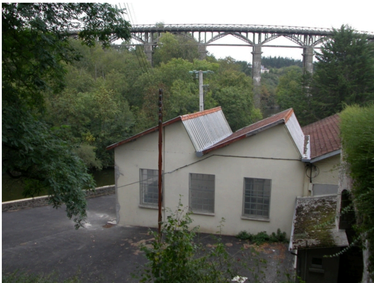
La "salle de relaying" couverte de sheds, façade sud.
