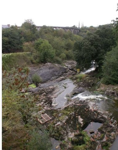
Déversoir placé à l'ouest de la centrale. Phot. Marina Gasnier IVR53_20032207593NUCA
