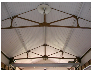
La salle des machines, vue intérieure : détail du plafond lambrissé et de la charpente métallique. Phot. Marina Gasnier IVR53_20042203085NUCA
