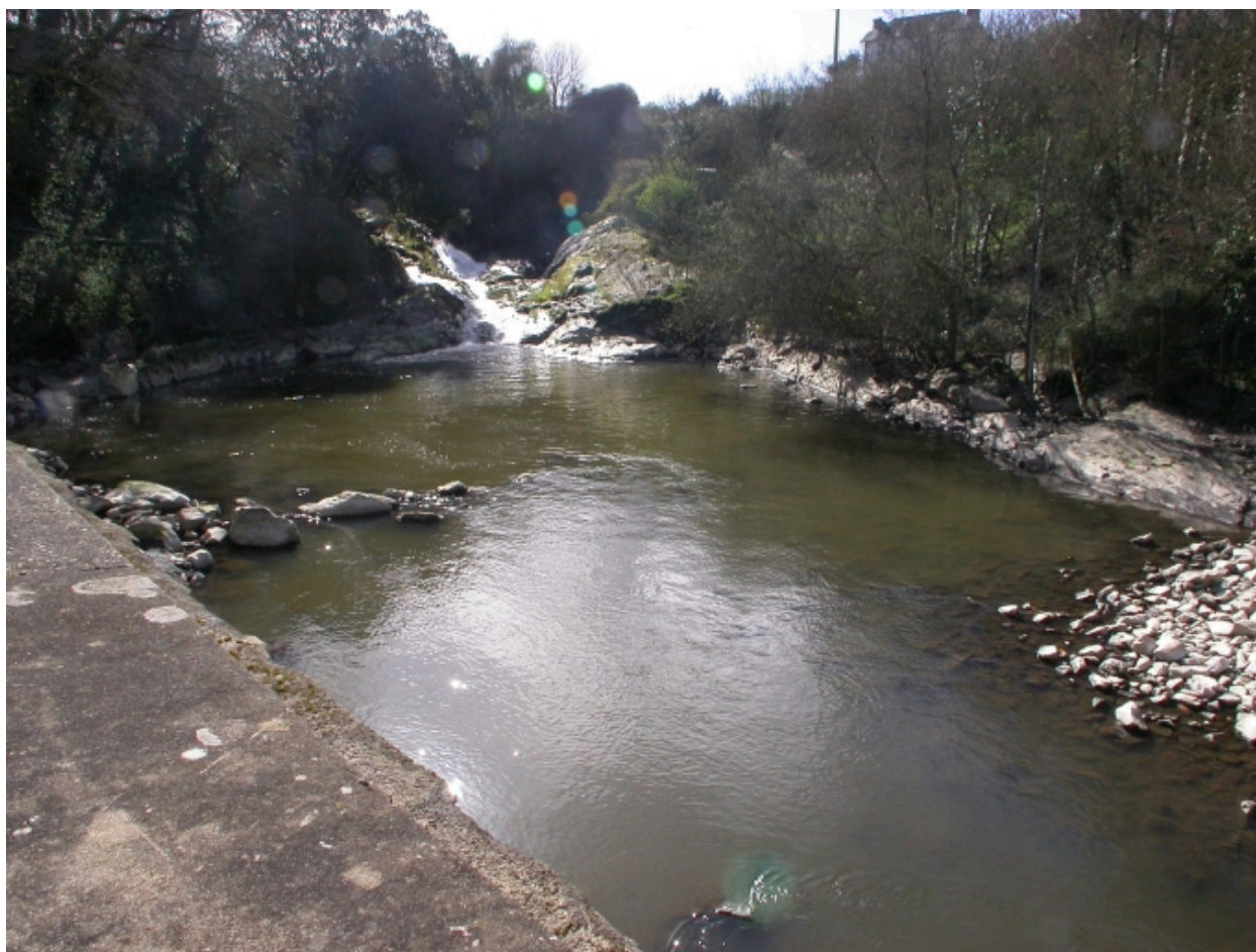
Les eaux du Gouessant s'écoulant après leur passage dans le vannage de décharge et le déversoir.
