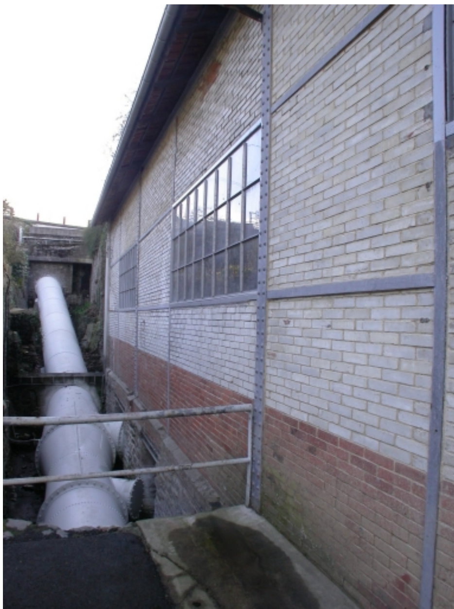
La salle des machines (façade est) et la conduite forcée.
