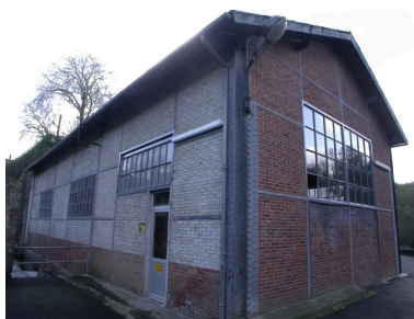
La salle des machines édifée en briques avec ossature métallique rivetée, vue générale nord-est. Phot. Marina Gasnier IVR53_20042203076NUCA
