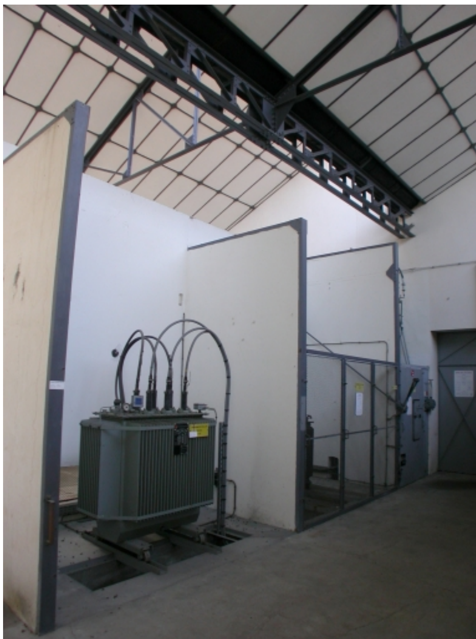
La "salle de relaying" couverte de sheds, vue intérieure.
