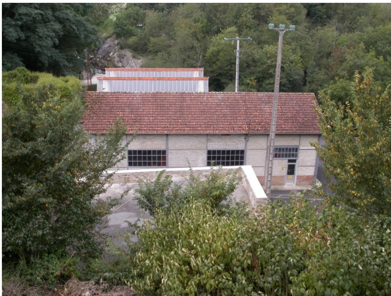
La salle des machines, façade nord-est.
