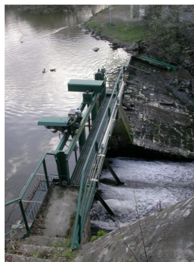
Vannage de décharge et déversoir. Phot. Marina Gasnier IVR53_20042203081NUCA
