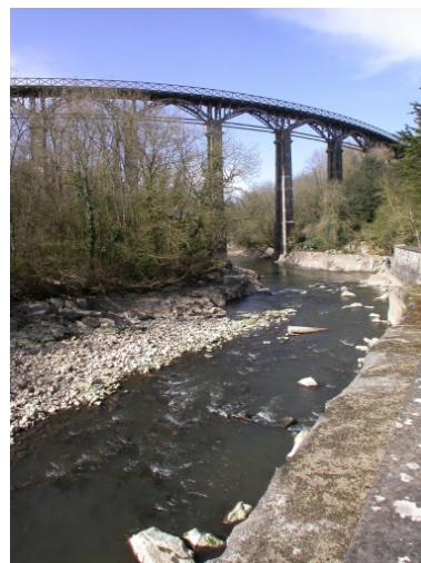
Les eaux du Gouessant s'écoulant près de la centrale. Phot. Marina Gasnier IVR53_20042203075NUCA
