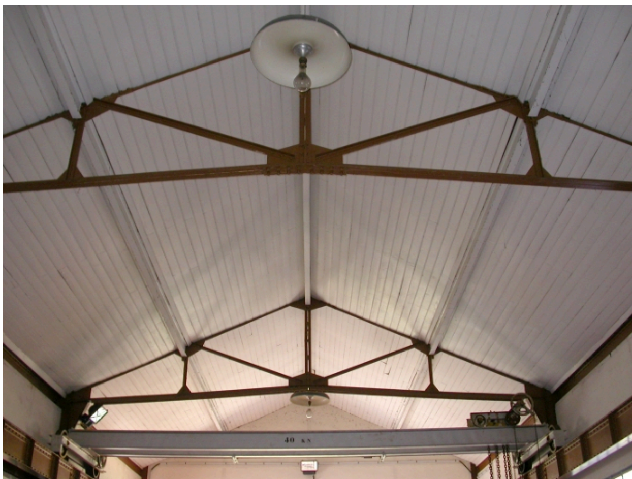
La salle des machines, vue intérieure : détail du plafond lambrissé et de la charpente métallique.
