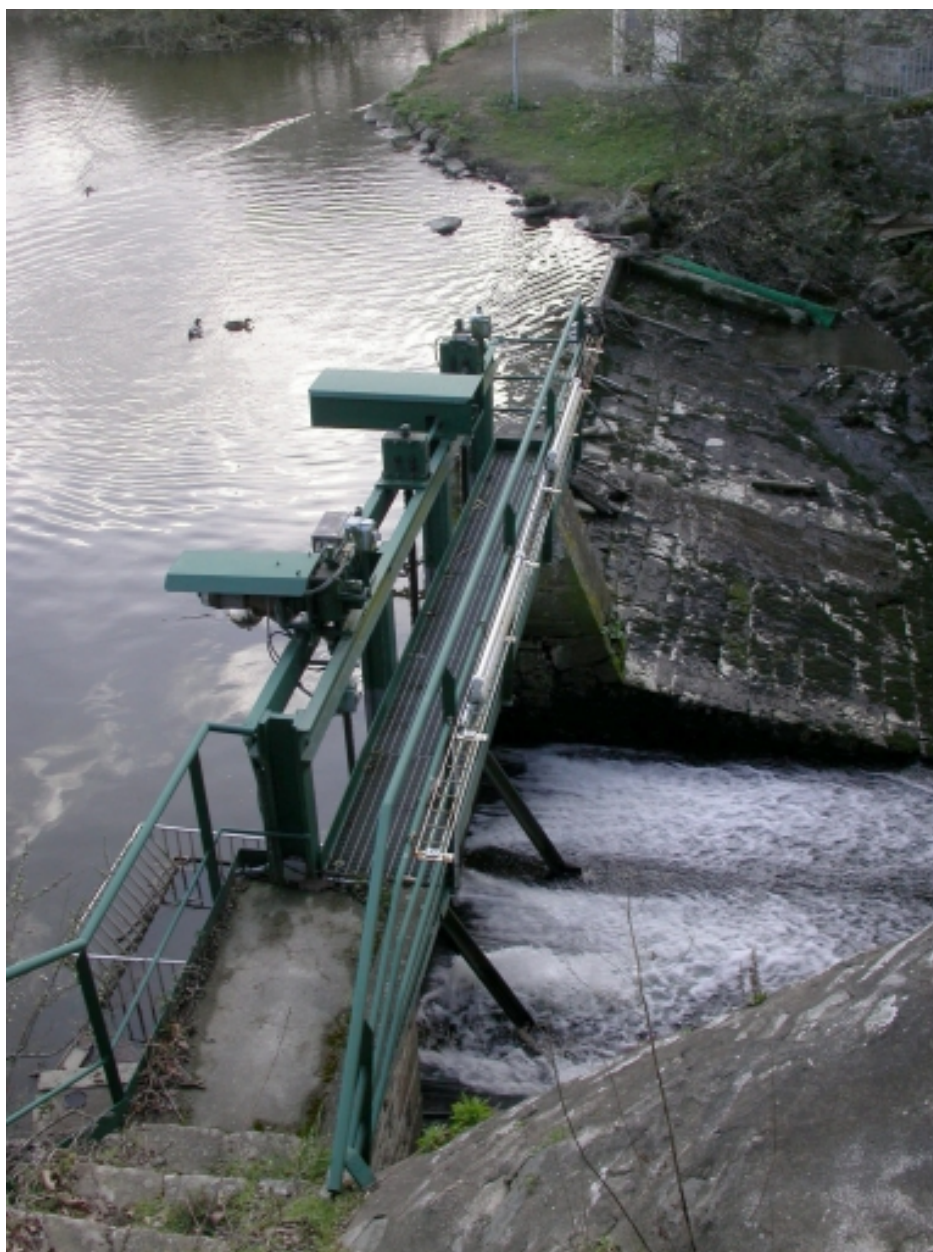
Vannage de décharge et déversoir.
