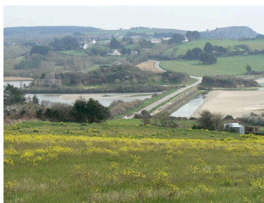
Vue générale de l'Aber et de sa digue Phot. Julien Amghar IVR53_20072908773NUCA
