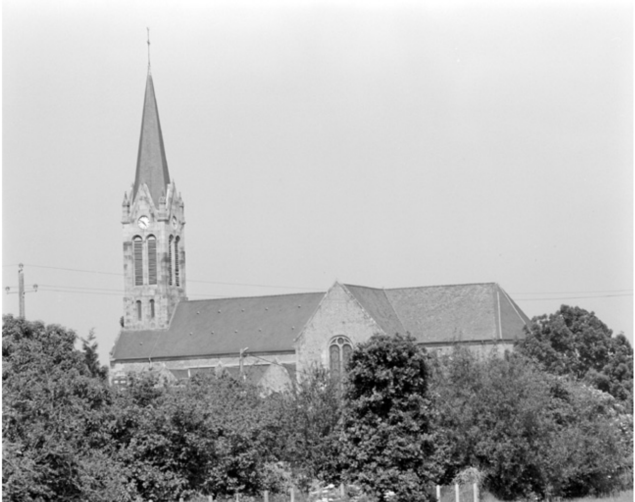
Élévation Sud : vue de situation
