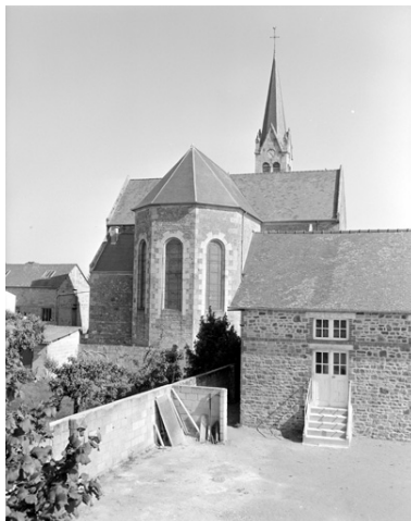
Élévation Sud : vue générale Phot. Guy Artur, Phot. Norbert Lambart IVR53_19943500959X
