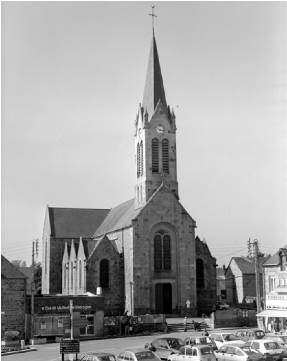
Élévation Nord : vue générale
