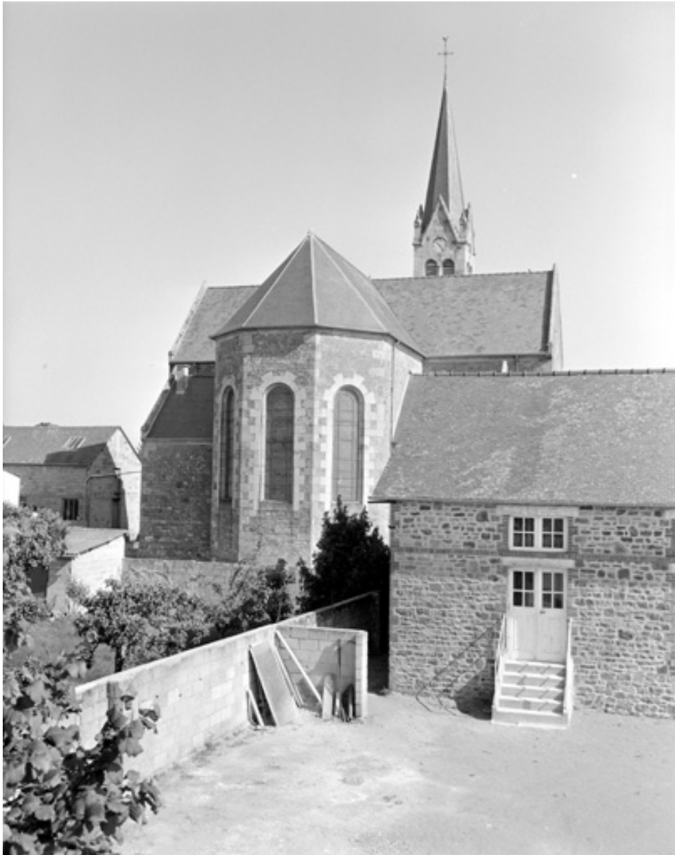
Élévation Sud : vue générale
