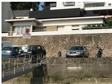
Villa Auffredou, vue des pontons Phot. Pierre Laurent Constantin IVR53_20225605141NUCA
