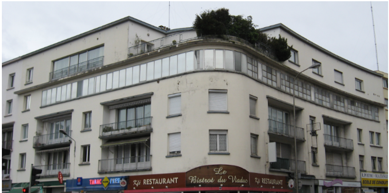
Villa Auffredou, vue générale
