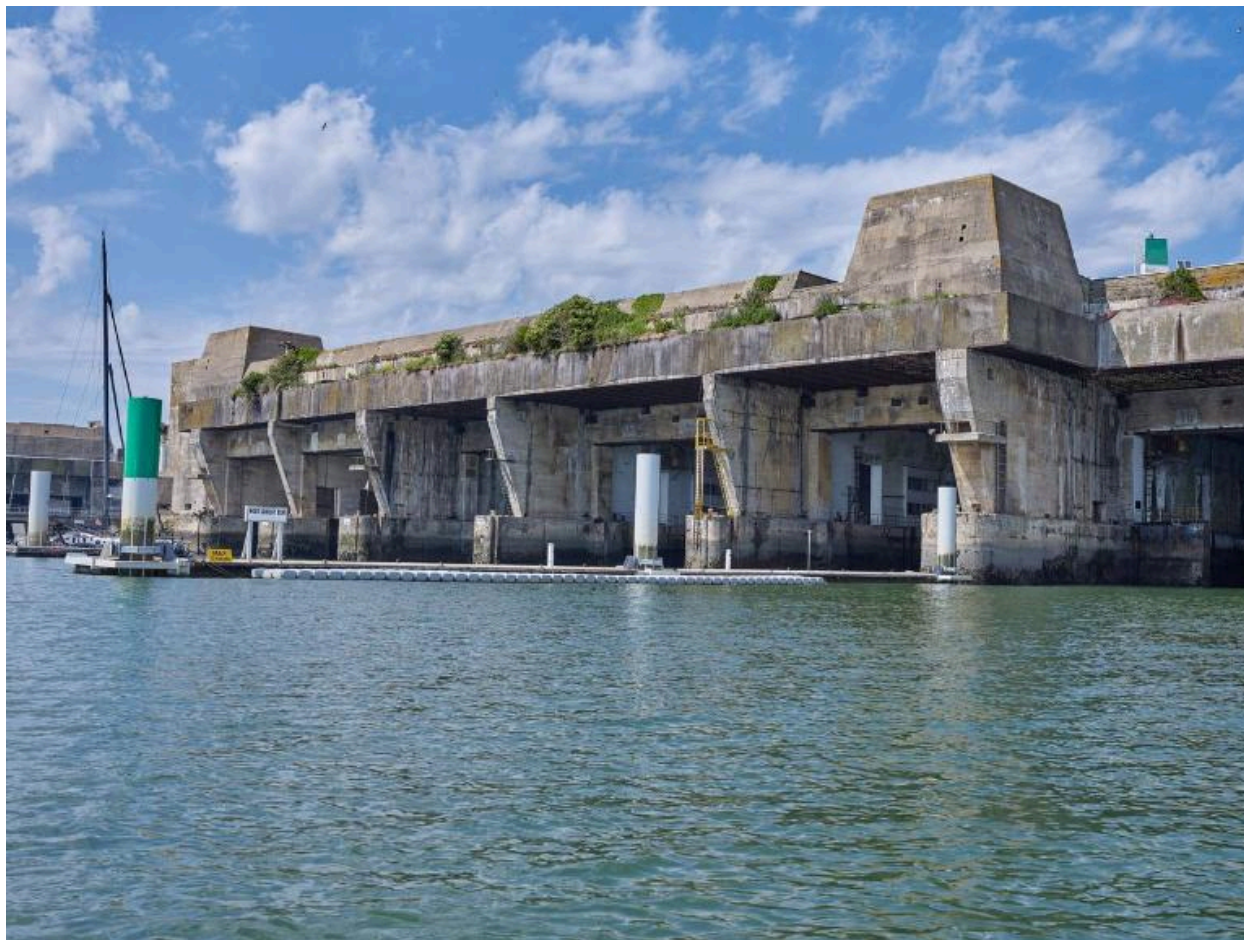
Vue générale depuis la rade de Lorient : entrée de cinq des sept alvéoles. Au premier plan : pontons de navires de course au large
