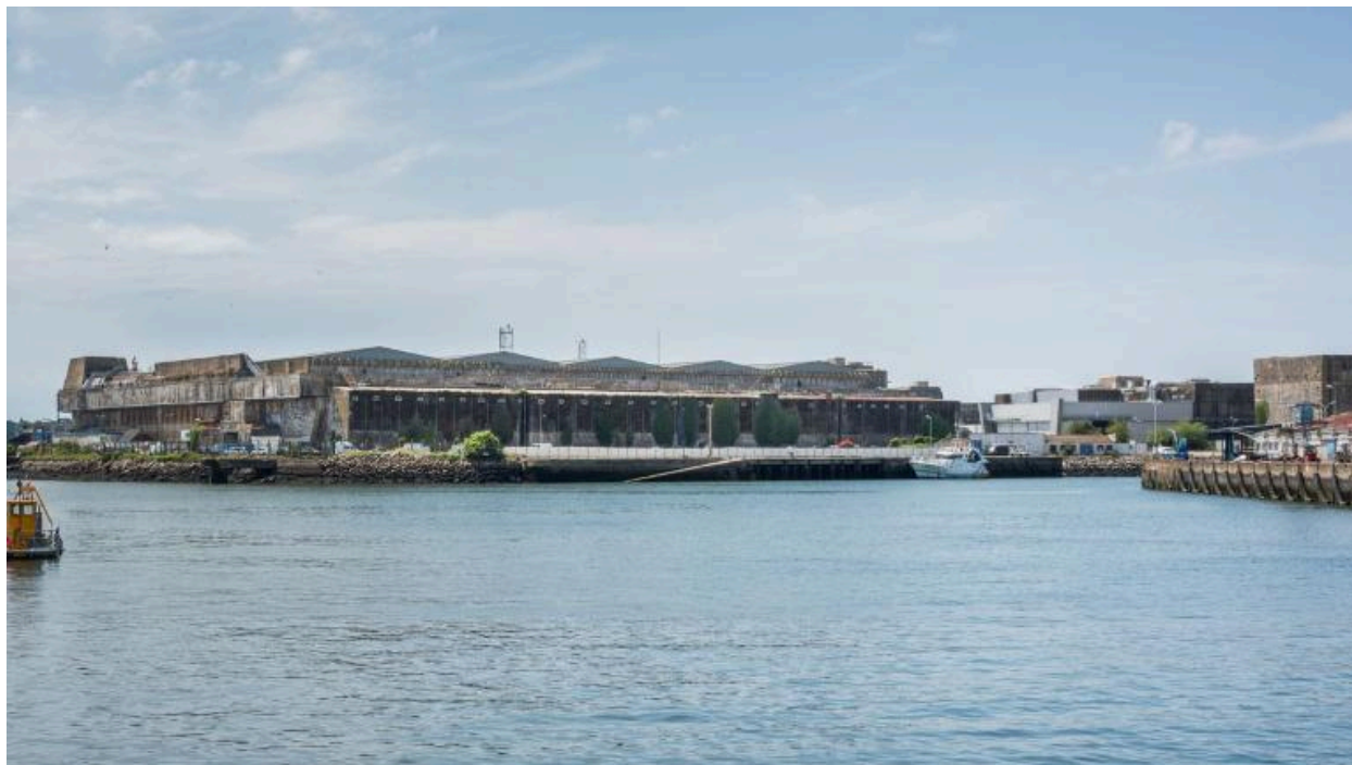
Vue générale de l'élévation nord (front arrière) depuis le port de pêche
