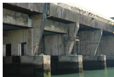
Vue du front avant orienté vers le sud-ouest : entrée des alvéoles A, B, C et D (2005) Phot. Guillaume Lécueillier
