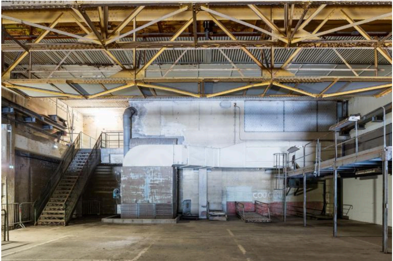
Vue du niveau supérieur de l'un des ateliers spécialisés des alvéoles. Il donne accès à un pont roulant d'une capacité de 5 tonnes
