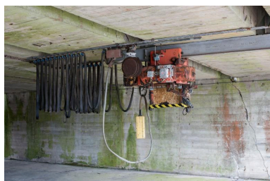
Vue d'un treuil français disposé dans l'une des chambres d'explosion Phot. Charlotte Barraud IVR53_20215600624NUCA
