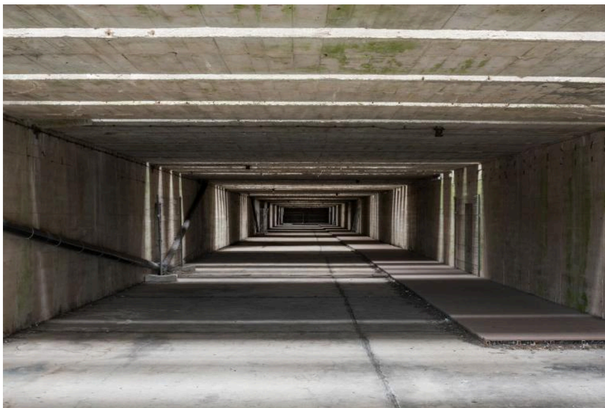
Vue générale de l'une des chambres d'explosion
