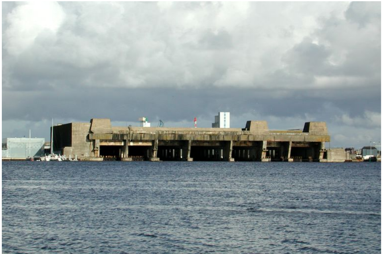
Vue générale depuis Larmor-Plage : entrée des sept alvéoles (2002). Le bunker "KIII" est protégé par des casemates pour canon et mitrailleuse et surmonté d'encuvements pour canon antiaérien
