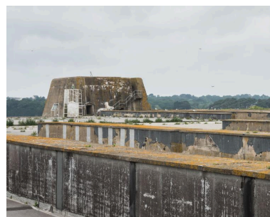
Vue de l'un des bunkers destinés à la défense antiaérienne regroupant encuvement et abri pour les soldats. Au premier plan, poutres longitudinales des chambres d'explosion (inachevées) Phot. Charlotte Barraud IVR53_20215600628NUCA
