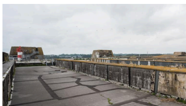
Vue générale de la dalle de couverture. Au premier plan, poutres longitudinales des chambres d'explosion (inachevées). Au second plan, bunkers destinés à la défense antiaérienne regroupant encuvement et abri pour les soldats Phot. Charlotte Barraud IVR53_20215600627NUCA
