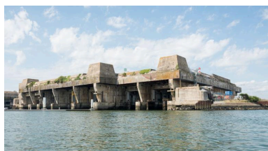
Vue générale depuis la rade de Lorient : entrée des sept alvéoles. Le bunker "KIII" est protégé par des casemates pour canon et mitrailleuse et surmonté d'encuvements pour canon antiaérien Phot. Charlotte Barraud IVR53_20215600610NUCA
