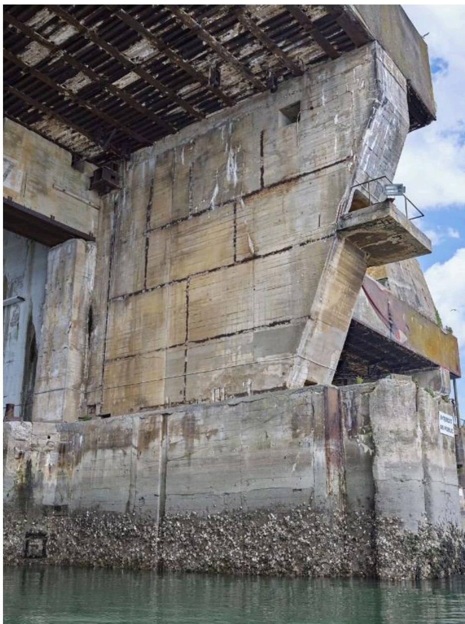
Vue de l'entrée de l'alvéole E (n° 17 et 18) : contrefort du mur de refend
