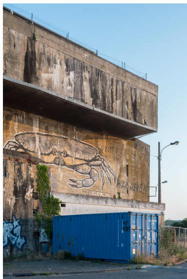
Vue de l'angle nord-est Phot. Charlotte Barraud IVR53_20235600311NUCA
