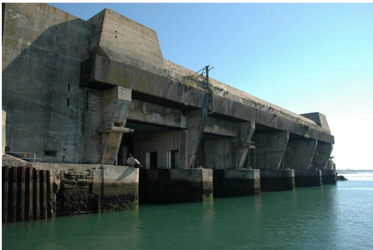
Vue du front avant orienté vers le sud-ouest : entrée des alvéoles A, B, C, D et E (2005)
