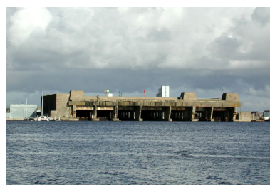
Vue générale depuis Larmor-Plage : entrée des sept alvéoles (2002). Le bunker "KIII" est protégé par des casemates pour canon et mitrailleuse et surmonté d'encuvements pour canon antiaérien Phot. Guillaume Lécueillier IVR53_20055603487NUCA
