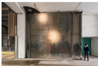
Vue de la porte blindée de l'entrée ouest Phot. Charlotte Barraud IVR53_20215600657NUCA
