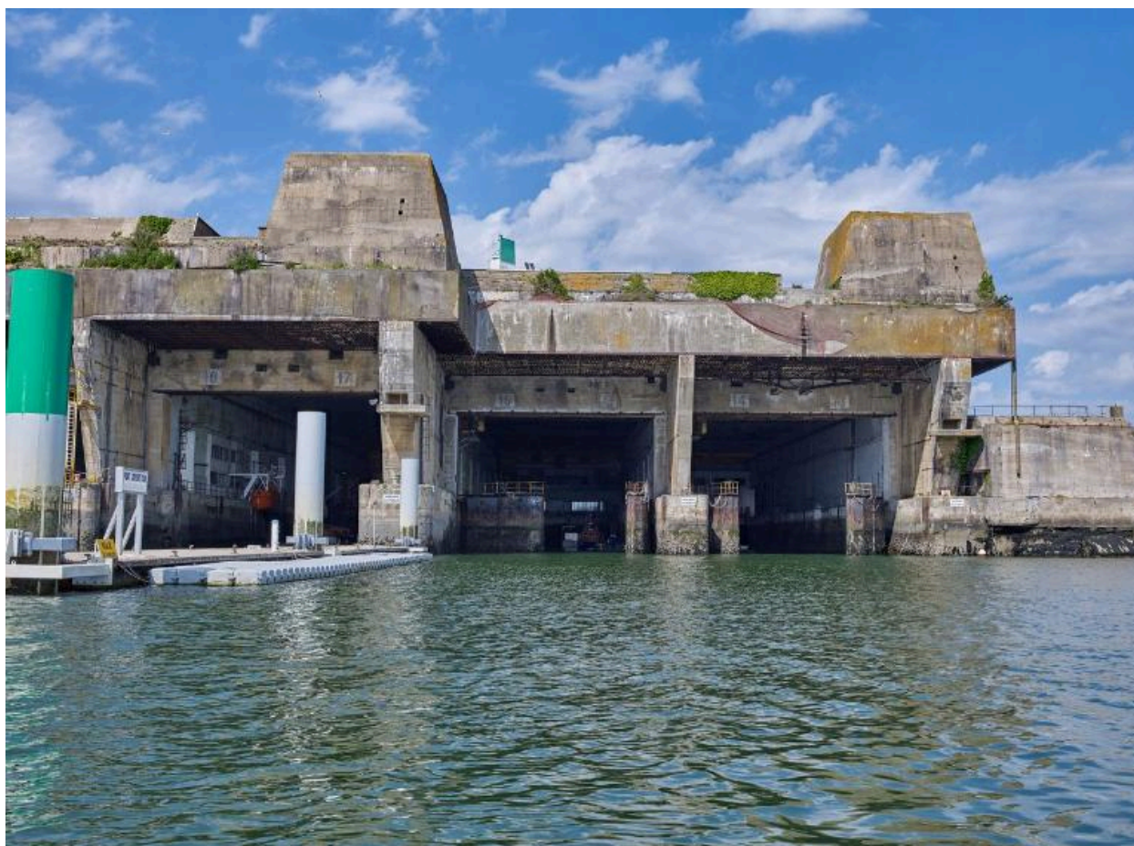
Vue de l'entrée des alvéoles E, F et G
