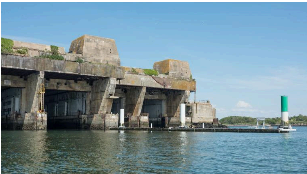
Vue du front avant orienté vers le sud-ouest : entrée des alvéoles E, F et G
