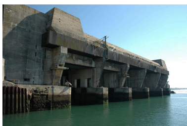
Vue du front avant orienté vers le sud-ouest : entrée des alvéoles A, B, C, D et E (2005) Phot. Guillaume Lécueillier
