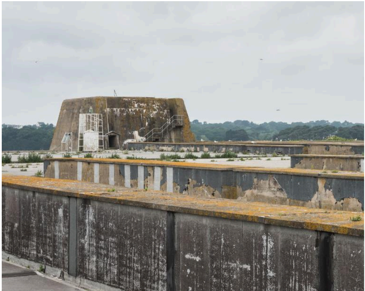
Vue de l'un des bunkers destinés à la défense antiaérienne regroupant encuvement et abri pour les soldats. Au premier plan, poutres longitudinales des chambres d'explosion (inachevées)
