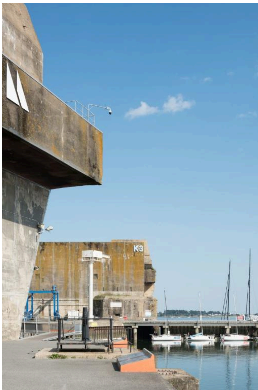
Vue de l'angle ouest du bunker "KIII" et des pontons pour navires de course au large. Au premier plan à gauche, le bunker "KI" avec l'entrée du slipway
