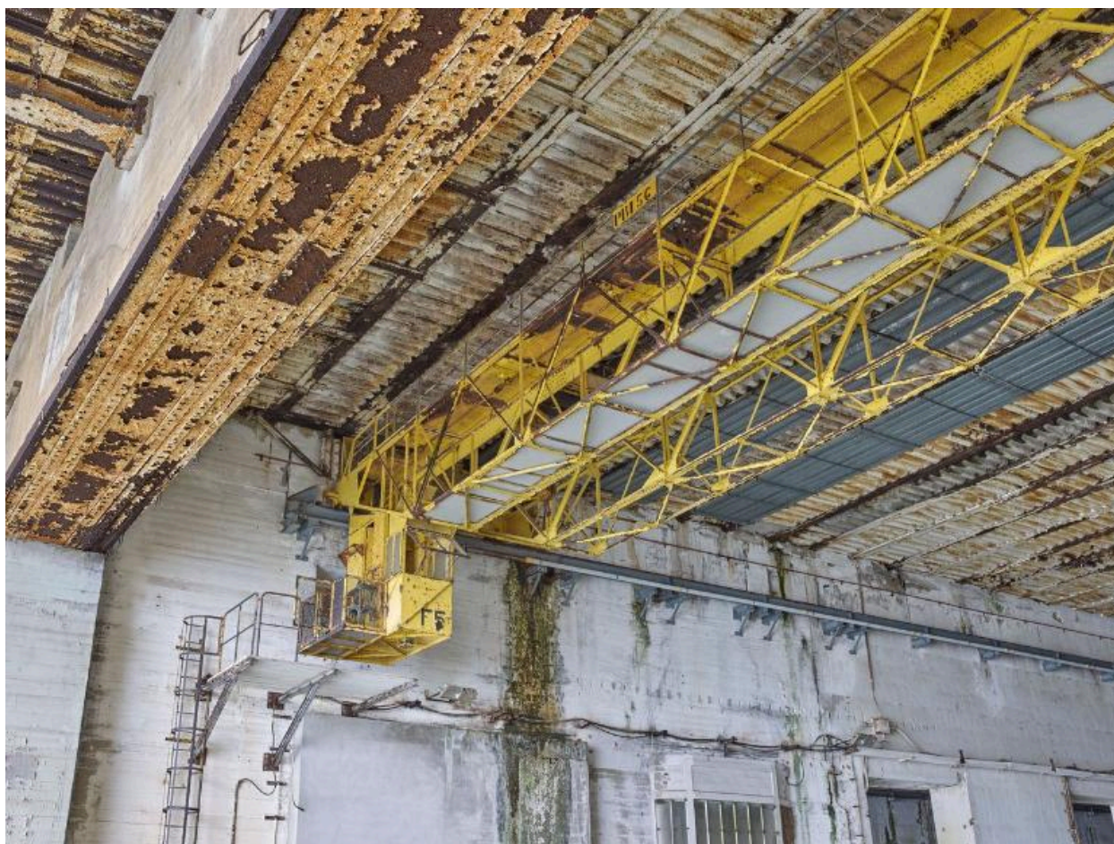
Vue de l'entrée de l'alvéole G (n° 13 et 14) : pont roulant d'une capacité de 5 tonnes
