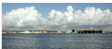
Vue de situation de la base navale allemande de Keroman depuis Larmor-Plage (2002). A droite, le bunker "KIII" Phot. Guillaume Lécueillier IVR53_20055603488NUCA
