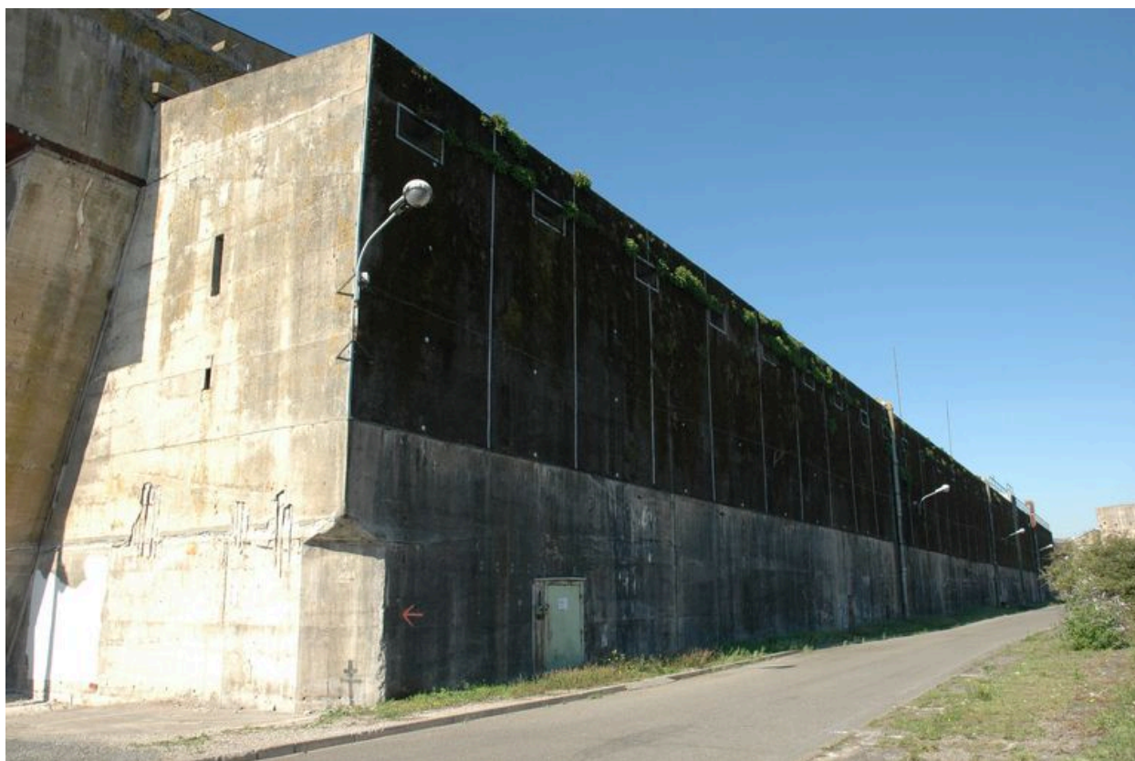
Vue de l'élévation nord, front arrière (2005). Le bunker est flanqué de magasins
