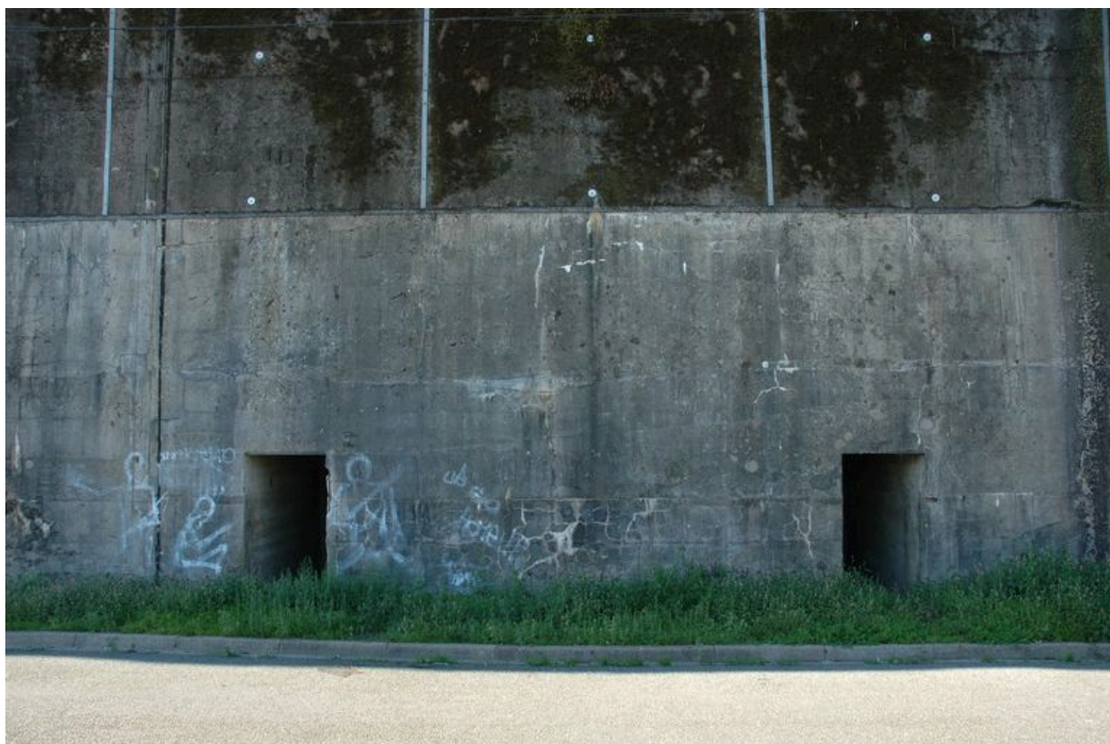
Vue de deux entrées protégées, aménagées dans l'élévation nord, front arrière (2005)
