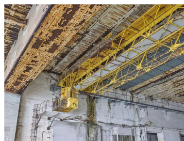
Vue de l'entrée de l'alvéole G (n° 13 et 14) : pont roulant d'une capacité de 5 tonnes Phot. Bernard Bègne IVR53_20215600468NUCA
