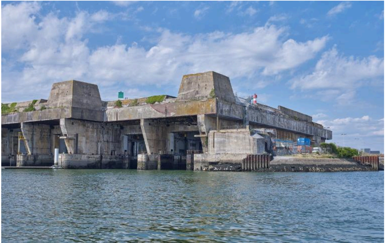
Vue depuis le sud-est : entrée des alvéoles E, F et G. A l'angle du "KIII", casemate pour canon et mitrailleuse
