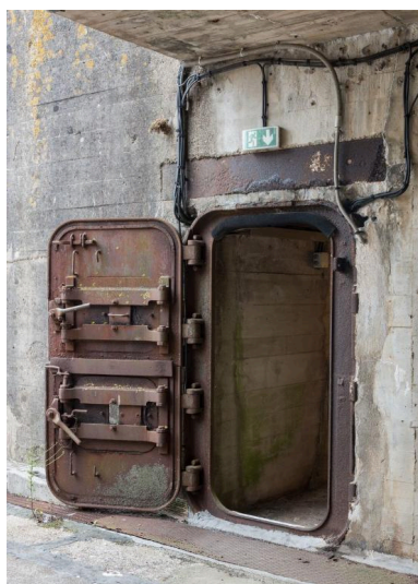
Vue de la porte blindée à deux vantaux donnant accès à la dalle de couverture Phot. Charlotte Barraud IVR53_20215600623NUCA
