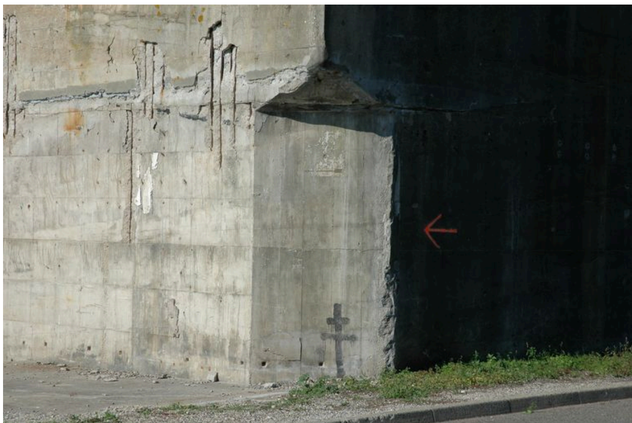
Vue de l'angle nord-est à pan coupé (2005)
