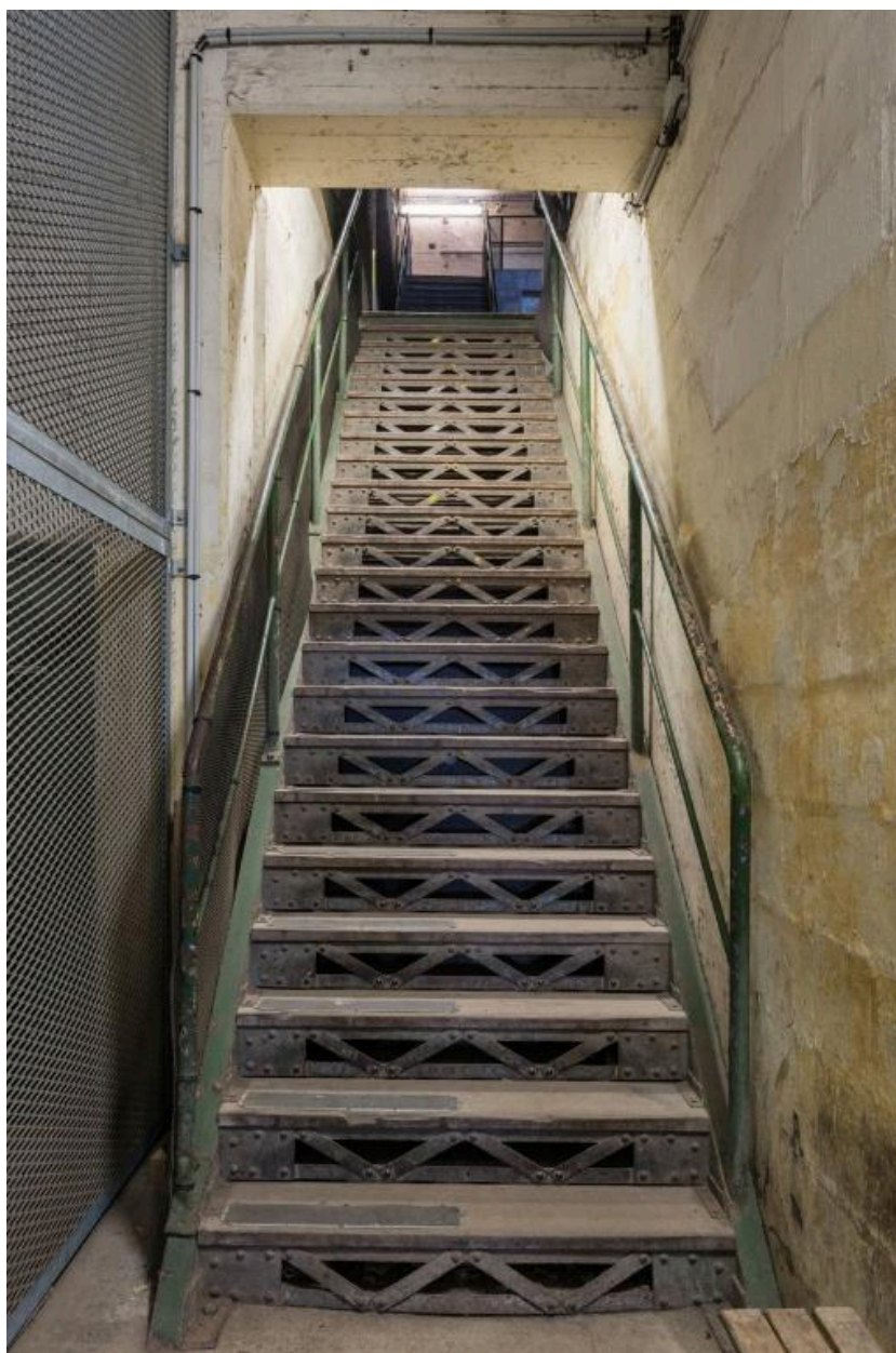
Vue de l'escalier conduisant aux étages supérieurs et à la dalle de couverture (escalier allemand en préfabriqué)
