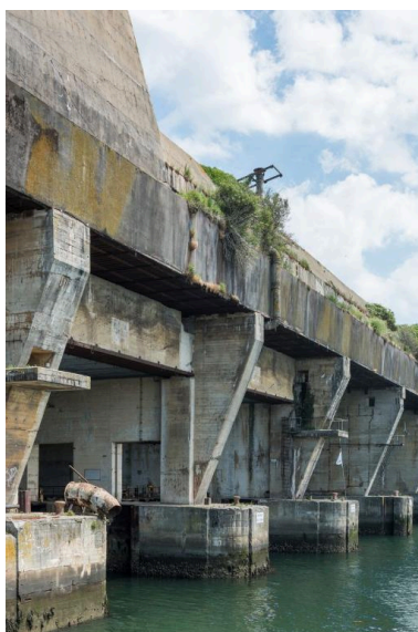
Vue du front avant orienté vers le sud-ouest : entrée des alvéoles A, B et C Phot. Charlotte Barraud IVR53_20215600590NUCA
