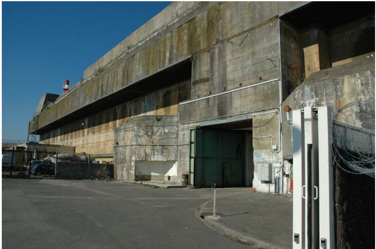
Vue de l'entrée est flanquée de deux casemates pour mitrailleuse et surmontée d'un observatoire (2005)
