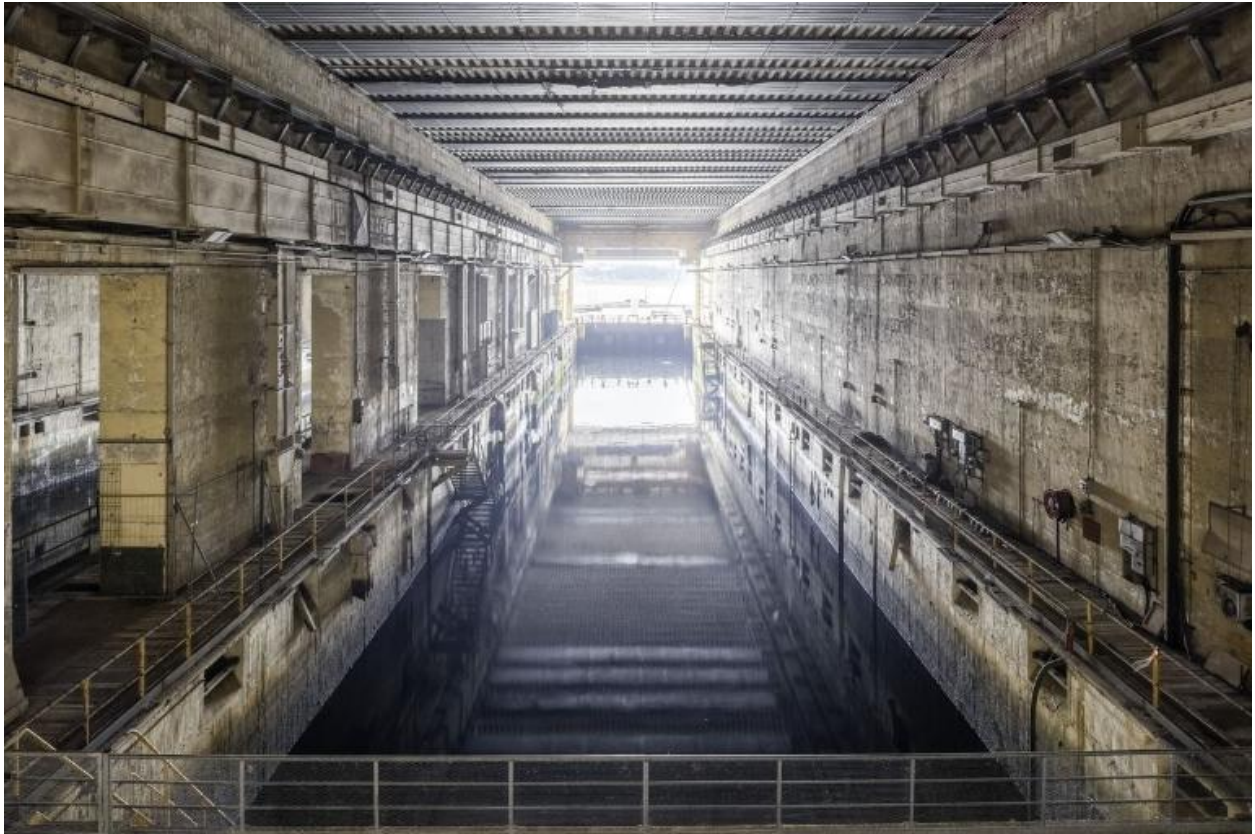
Vue générale de l'alvéole A (n° 24). Ses portes étanches sont fermées
