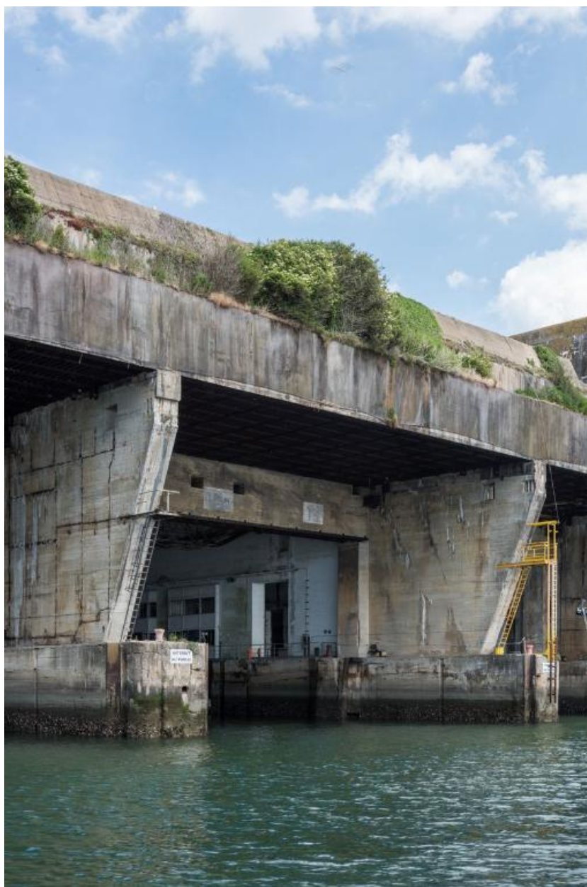
Vue du front avant orienté vers le sud-ouest : entrée de l'alvéole D (n° 19, 19a et 20)
