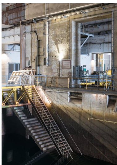
Vue de l'alvéole A (n° 24) : escaliers plongeant dans l'eau. Sur les murs, peintures murales françaises et marquages Phot. Charlotte Barraud IVR53_20215600664NUCA
