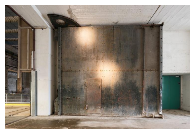
Vue de la porte blindée de l'entrée ouest Phot. Charlotte Barraud IVR53_20215600656NUCA
