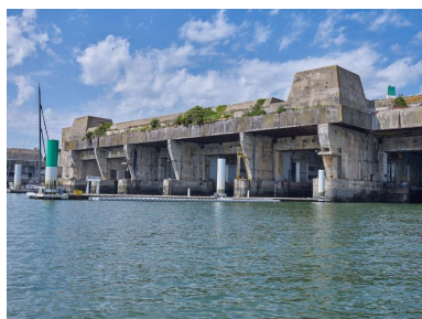
Vue générale depuis la rade de Lorient : entrée de cinq des sept alvéoles. Au premier plan : pontons de navires de course au large Phot. Bernard Bègne IVR53_20215600529NUCA
