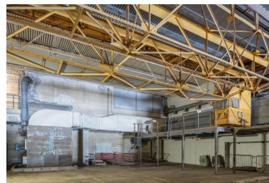
Vue du niveau supérieur de l'un des ateliers spécialisés des alvéoles. Il donne accès à un pont roulant d'une capacité de 5 tonnes Phot. Charlotte Barraud IVR53_20215600621NUCA
