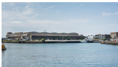
Vue générale de l'élévation nord (front arrière) depuis le port de pêche Phot. Charlotte Barraud IVR53_20215600601NUCA
