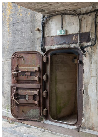
Vue de la porte blindée à deux vantaux donnant accès à la dalle de couverture Phot. Charlotte Barraud
