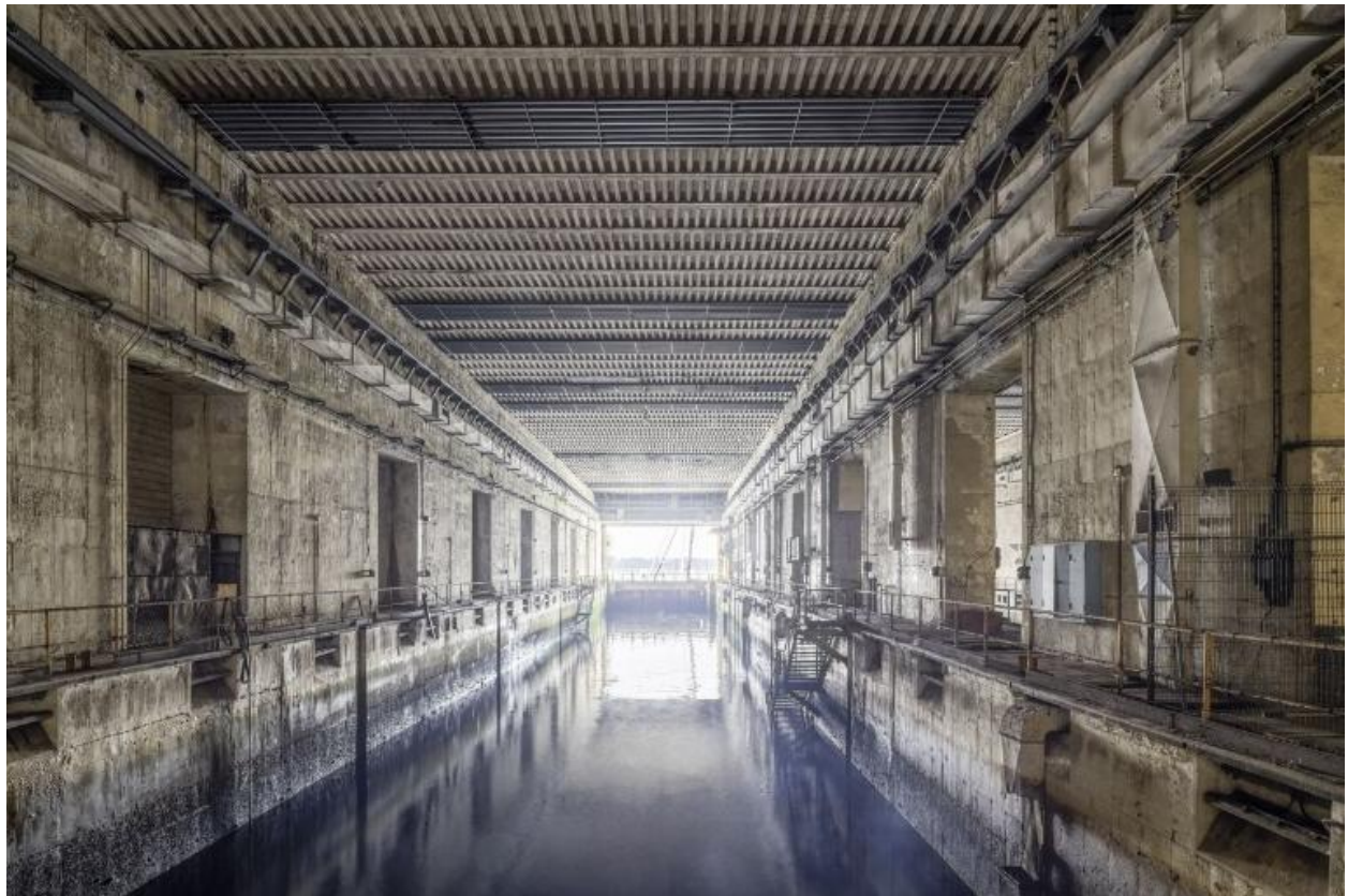
Vue générale de l'alvéole B (n° 23). Ses portes étanches sont fermées
