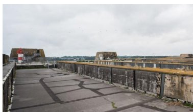
Vue générale de la dalle de couverture. Au premier plan, poutres longitudinales des chambres d'explosion (inachevées). Au second plan, bunkers destinés à la défense antiaérienne regroupant encuvement et abri pour les soldats
