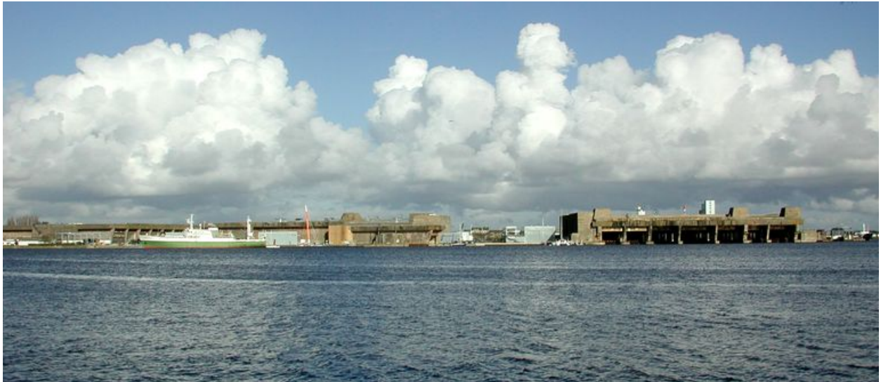
Vue de situation de la base navale allemande de Keroman depuis Larmor-Plage (2002). A droite, le bunker "KIII"
