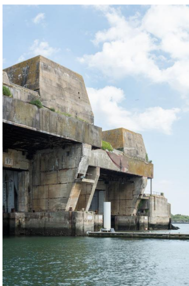
Vue du front avant orienté vers le sud-ouest : entrées des alvéoles. Le bunker "KIII" est protégé par des casemates pour canon et mitrailleuse et surmonté d'encuvements pour canon antiaérien Phot. Charlotte Barraud IVR53_20215600597NUCA
