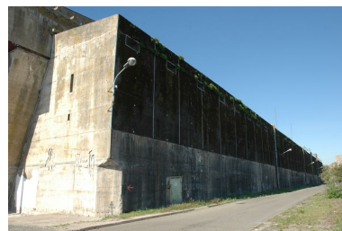
Vue de l'élévation nord, front arrière (2005). Le bunker est flanqué de magasins Phot. Guillaume Lécueillier IVR53_20055603570NUCA
