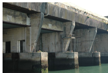
Vue du front avant orienté vers le sud-ouest : entrée des alvéoles A, B, C et D (2005) Phot. Guillaume Lécueillier IVR53_20055603587NUCA
