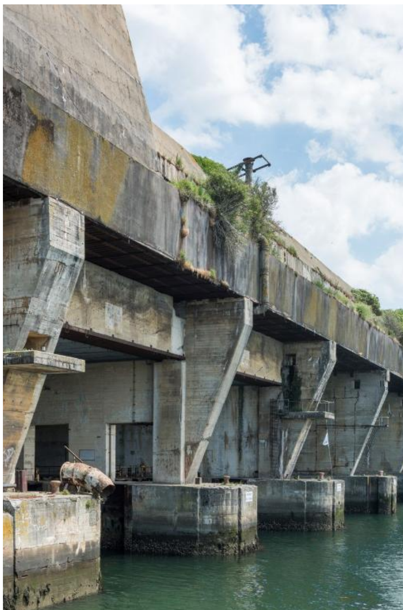
Vue du front avant orienté vers le sud-ouest : entrée des alvéoles A, B et C
