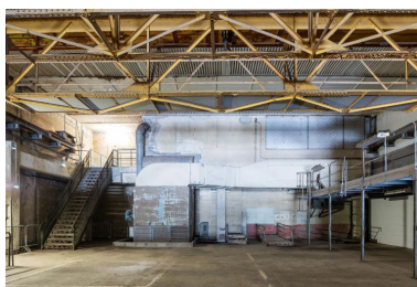
Vue du niveau supérieur de l'un des ateliers spécialisés des alvéoles. Il donne accès à un pont roulant d'une capacité de 5 tonnes Phot. Charlotte Barraud IVR53_20215600620NUCA
