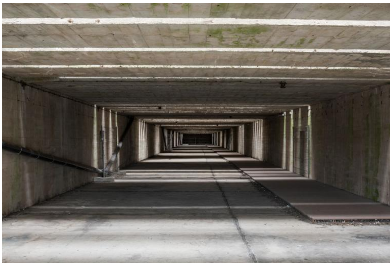
Vue générale de l'une des chambres d'explosion
