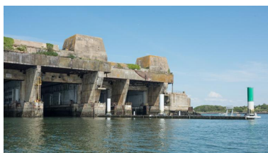
Vue du front avant orienté vers le sud-ouest : entrée des alvéoles E, F et G Phot. Charlotte Barraud IVR53_20215600605NUCA
