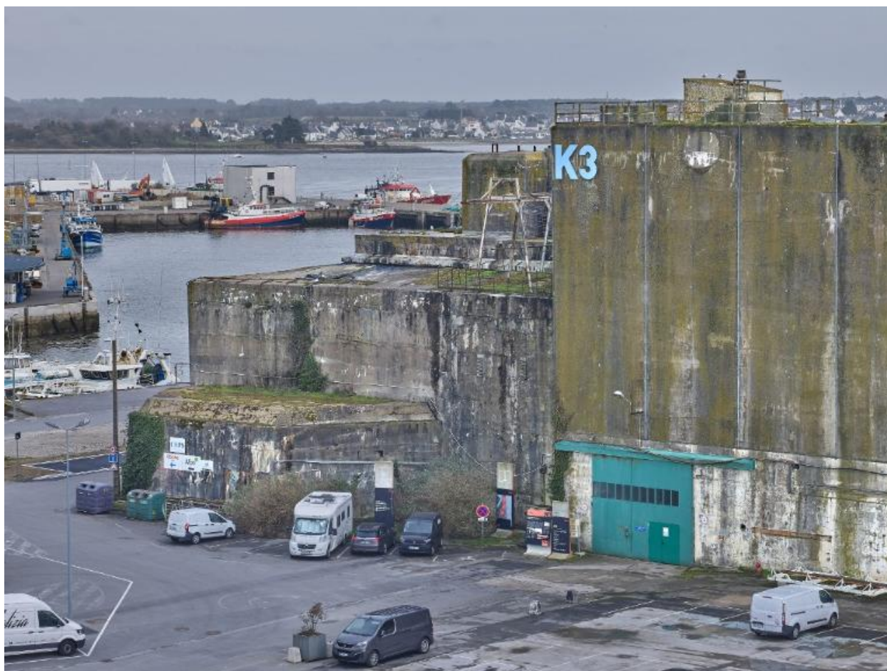
Vue du bunker Keroman III depuis la dalle de couverture du bunker Keroman I : casemate de flanquement de l'entrée nord-ouest
