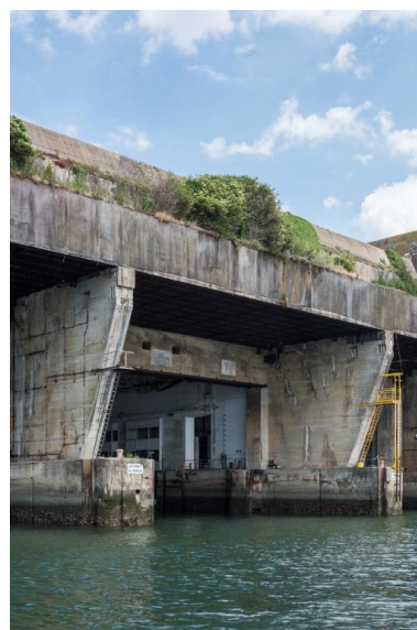
Vue du front avant orienté vers le sud-ouest : entrée de l'alvéole D (n° 19, 19a et 20) Phot. Charlotte Barraud IVR53_20215600595NUCA
