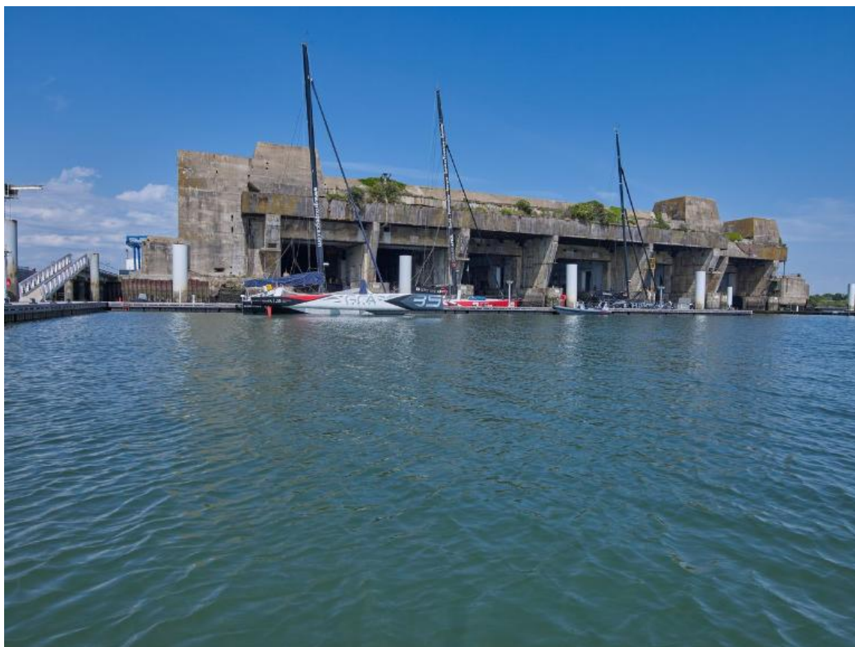
Vue générale depuis la rade de Lorient : entrée des sept alvéoles. Au premier plan : pontons de navires de course au large
