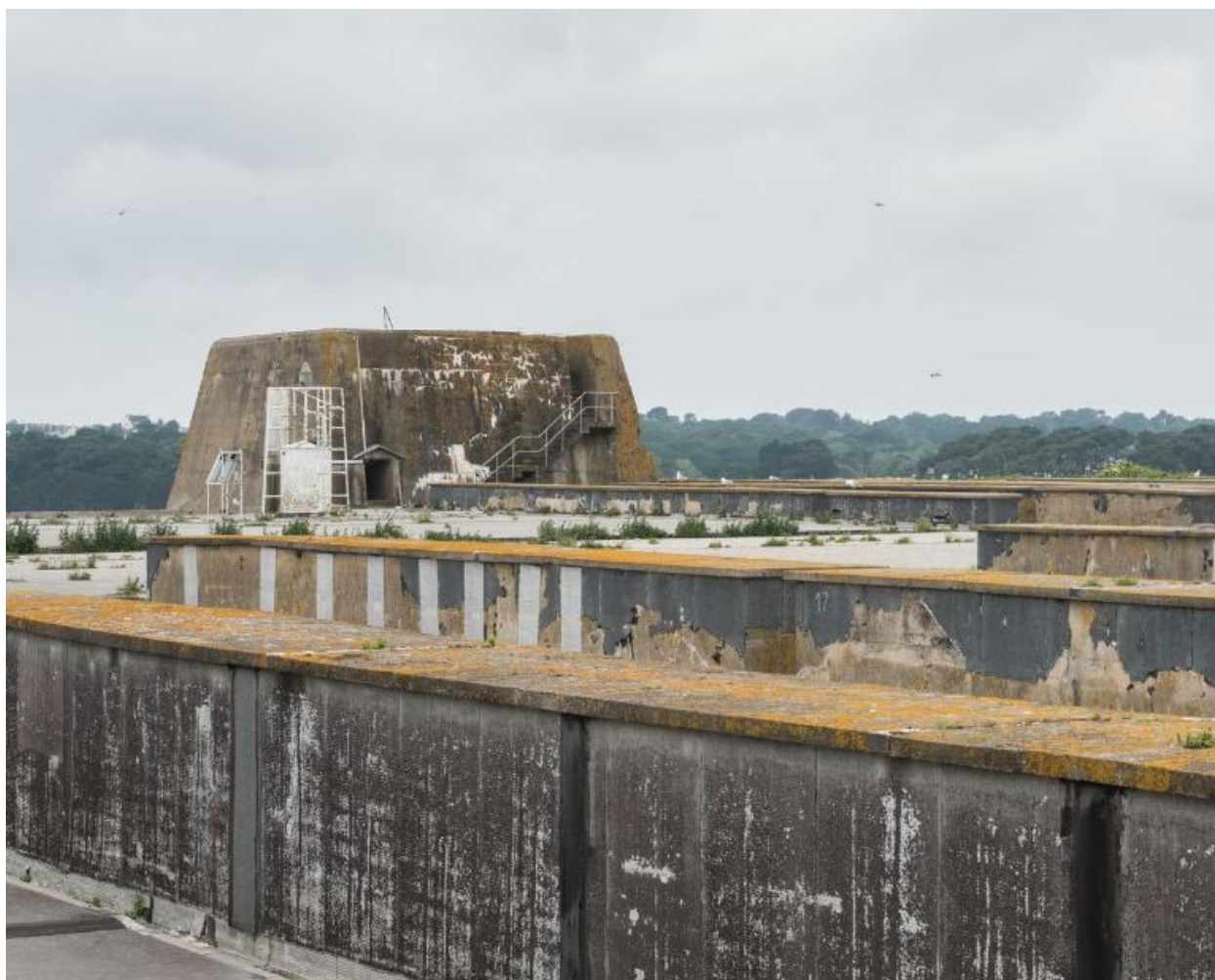
Vue de l'un des bunkers destinés à la défense antiaérienne regroupant encuvement et abri pour les soldats. Au premier plan, poutres longitudinales des chambres d'explosion (inachevées)
