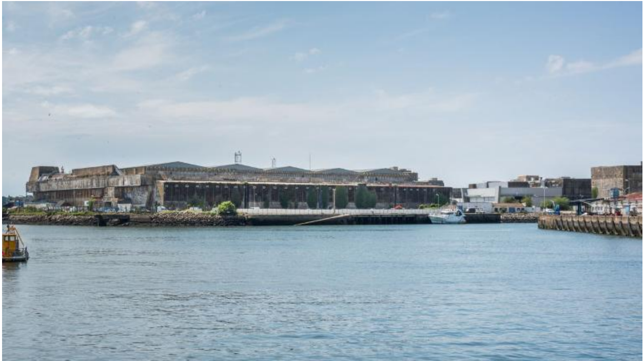
Vue générale de l'élévation nord (front arrière) depuis le port de pêche
