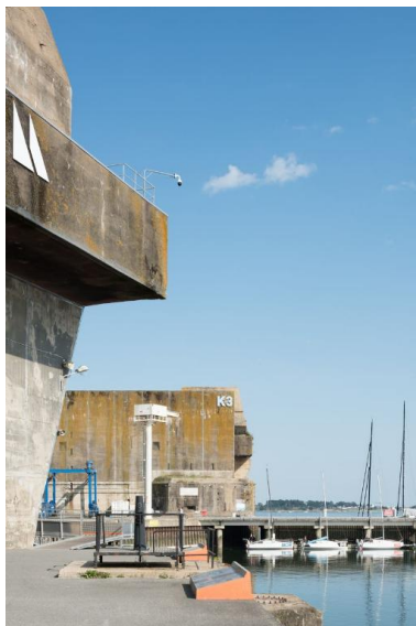
Vue de l'angle ouest du bunker "KIII" et des pontons pour navires de course au large. Au premier plan à gauche, le bunker "KI" avec l'entrée du slipway Phot. Charlotte Barraud IVR53_20215600616NUCA
