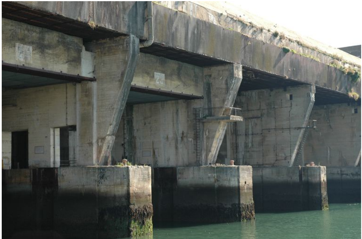
Vue du front avant orienté vers le sud-ouest : entrée des alvéoles A, B, C et D (2005)
