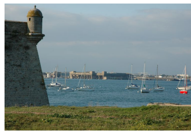
Vue de situation de la base navale allemande de Keroman (notamment le bunker "KIII") depuis la citadelle de Port-Louis (2005). Au premier plan, échauguette couronnant la demi-lune Phot. Guillaume Lécueillier IVR53_20055603608NUCA
