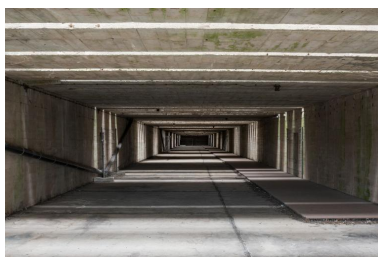
Vue générale de l'une des chambres d'explosion Phot. Charlotte Barraud IVR53_20215600625NUCA
