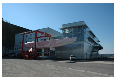
Exemple de reconversion industrialo-portuaire : hangar - dock du bateau Areva de la Coupe de l'America flanquant le bunker "KIII" (2005). Le site des Défis, occupé par le "Groupama Team France", a été ravagé par un incendie le 9 juin 2018 Phot. Guillaume Lécueillier IVR53_20055603578NUCA
