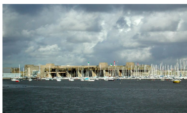
Vue générale depuis Larmor-Plage (2002). Au premier plan, le port de plaisance de Kernével à Larmor-Plage Phot. Guillaume Lécueillier IVR53_20055603489NUCA
