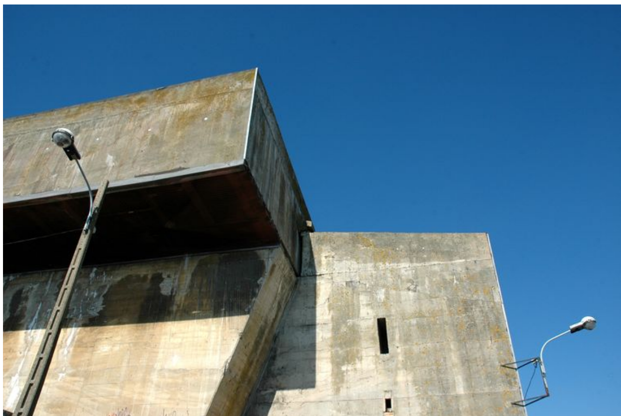
Vue de l'angle nord-est : gigantisme du contrefort et de la dalle de couverture en béton armé (2005)
