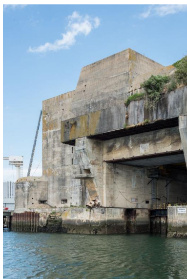
Vue du front avant : entrée de l'alvéole A (nord). L'angle ouest de la base est protégé par une casemate pour quatre mitrailleuses et surmonté par un encuvement pour canon antiaérien Phot. Charlotte Barraud IVR53_20215600596NUCA
