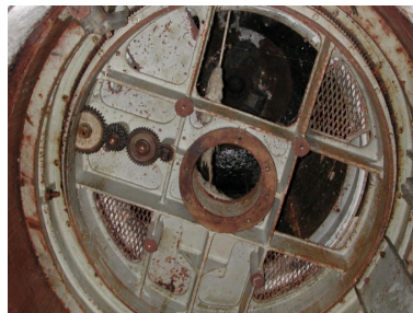
Dispositif associé à la tourelle sous le dôme : une couronne gravée indique la direction de tir Repro. Guy Prigent IVR53_20032205088NUCA
