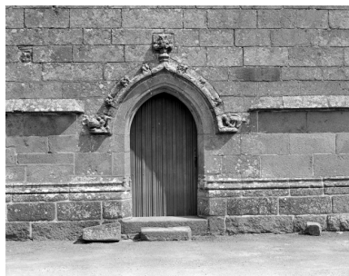
Elévation Sud, porte Ouest : vue générale Phot. Guy Artur, Phot. Norbert Lambart IVR53_19943501000X
