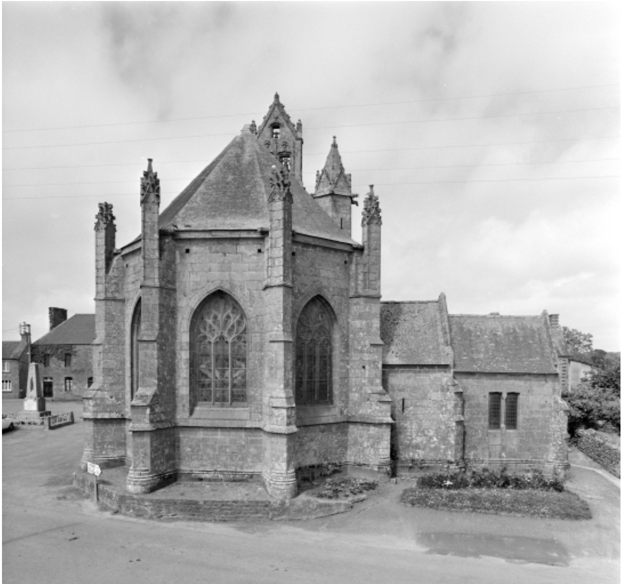
Vue générale du chevet à pans coupés
