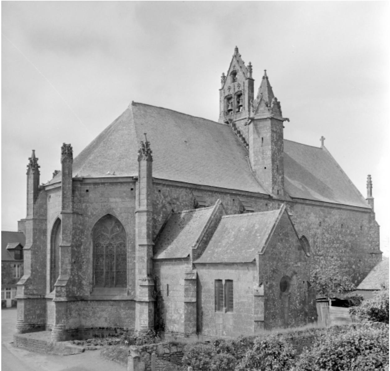
Elévation Nord-Est : vue générale
