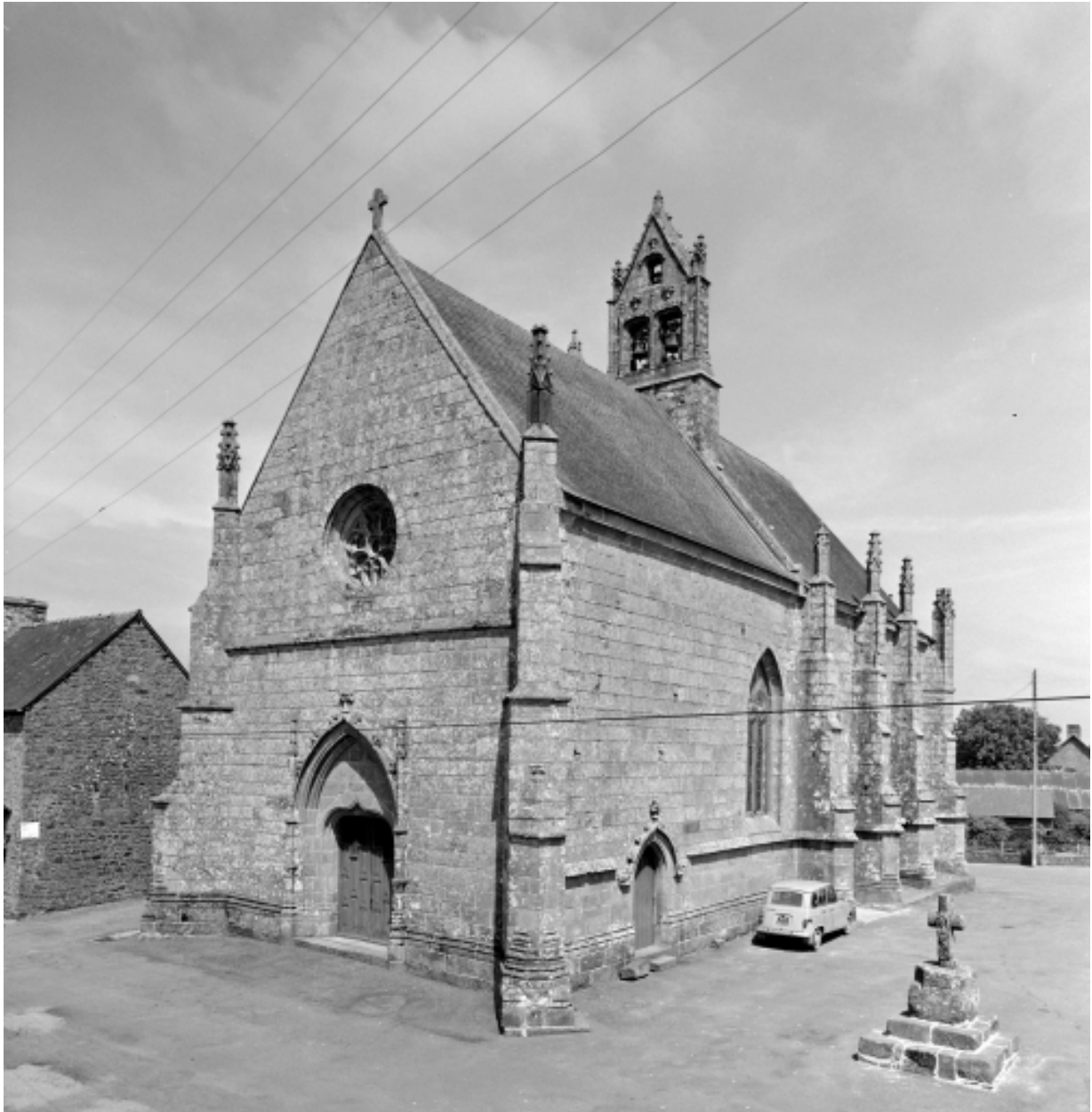
Elévation Ouest : vue générale
