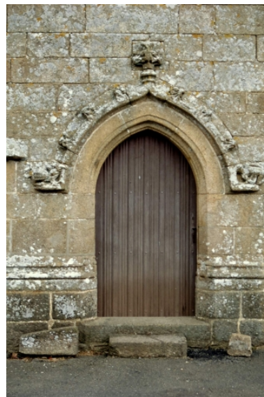
Elévation sud : détail porte. Phot. Isabelle Barbedor IVR53_19943502509ZA
