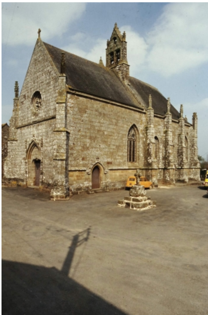
Vue générale prise du sud-ouest.
