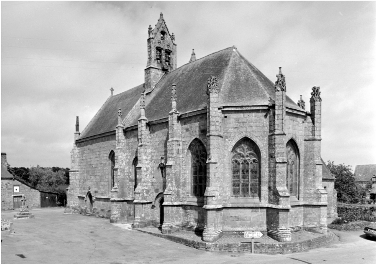
Elévation Sud-Est : vue générale
