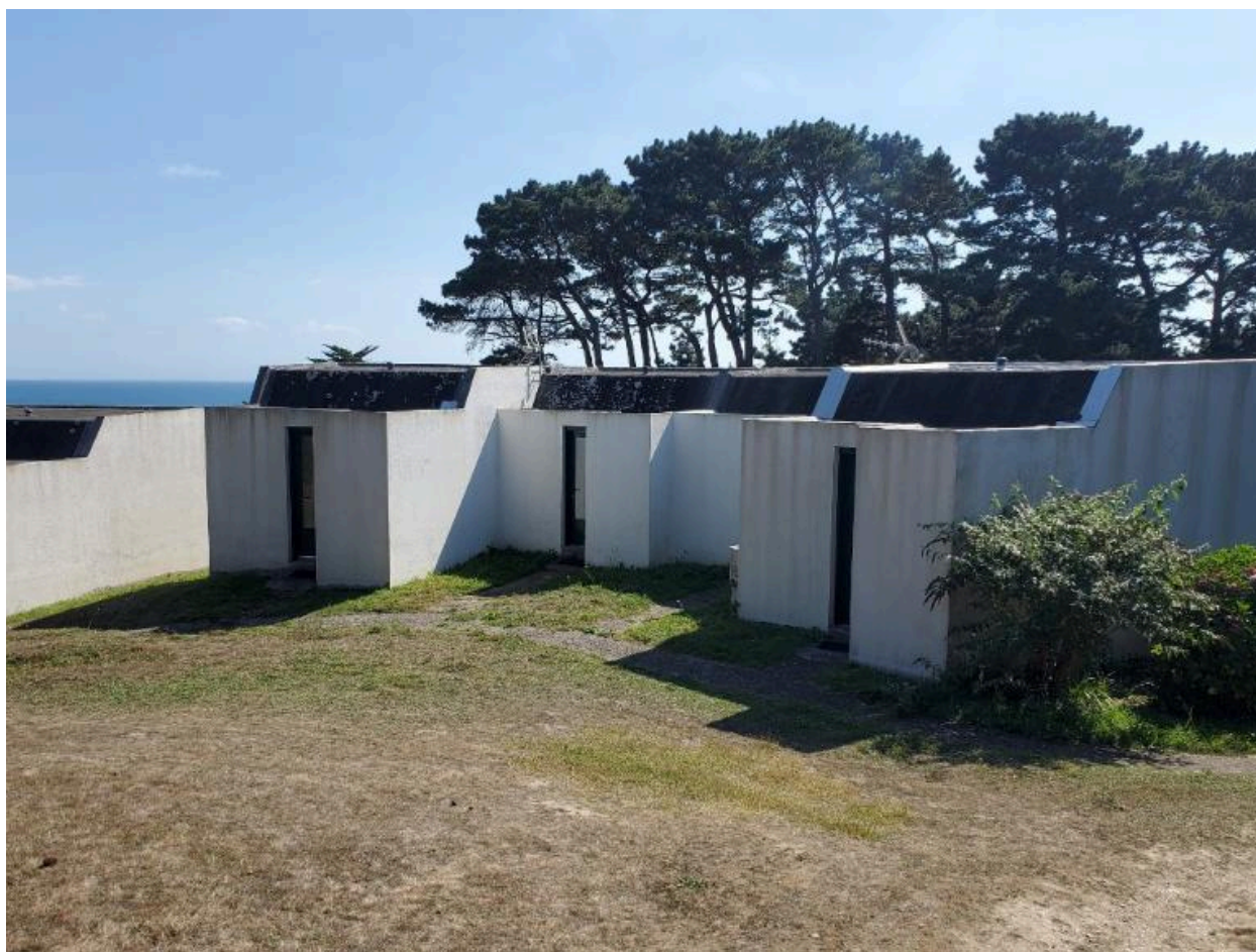
Le VVF de Groix, avant restauration
