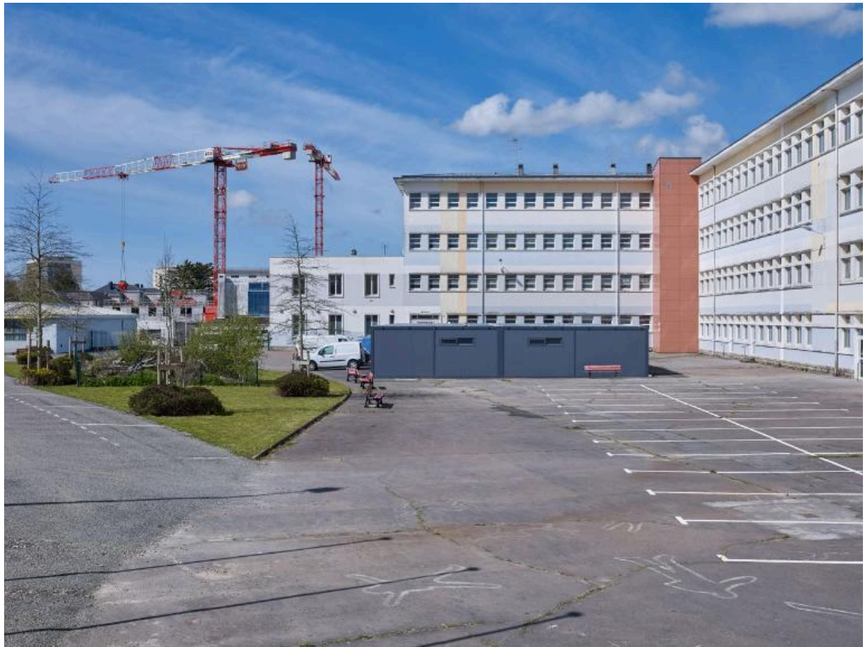
Bâtiment R, externat et bureaux. Façades est et sud de l'équerre. J-B. Mathon, architecte. Les constructions préfabriquées installées dans la cour servent pour le chantier du nouvel internat (2021) dont on aperçoit les grues.
