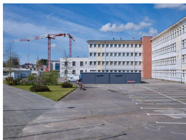
Bâtiment R, extensat et bureaux. Façades est et sud de l'angle. J-B. Mathon, architecte. Les constructions préfabriquées installées dans la cour servent pour le chantier du nouvel internat (2021) dont on aperçoit les grues. Phot. Bernard Bègne IVR53_20212900003NUCA
