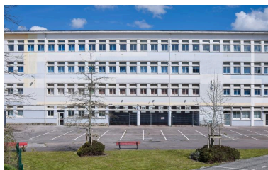
Bâtiment R, façade sud, partie centrale et préau. J-B. Mathon, architecte. Phot. Bernard Bègne IVR53_20212900004NUCA
