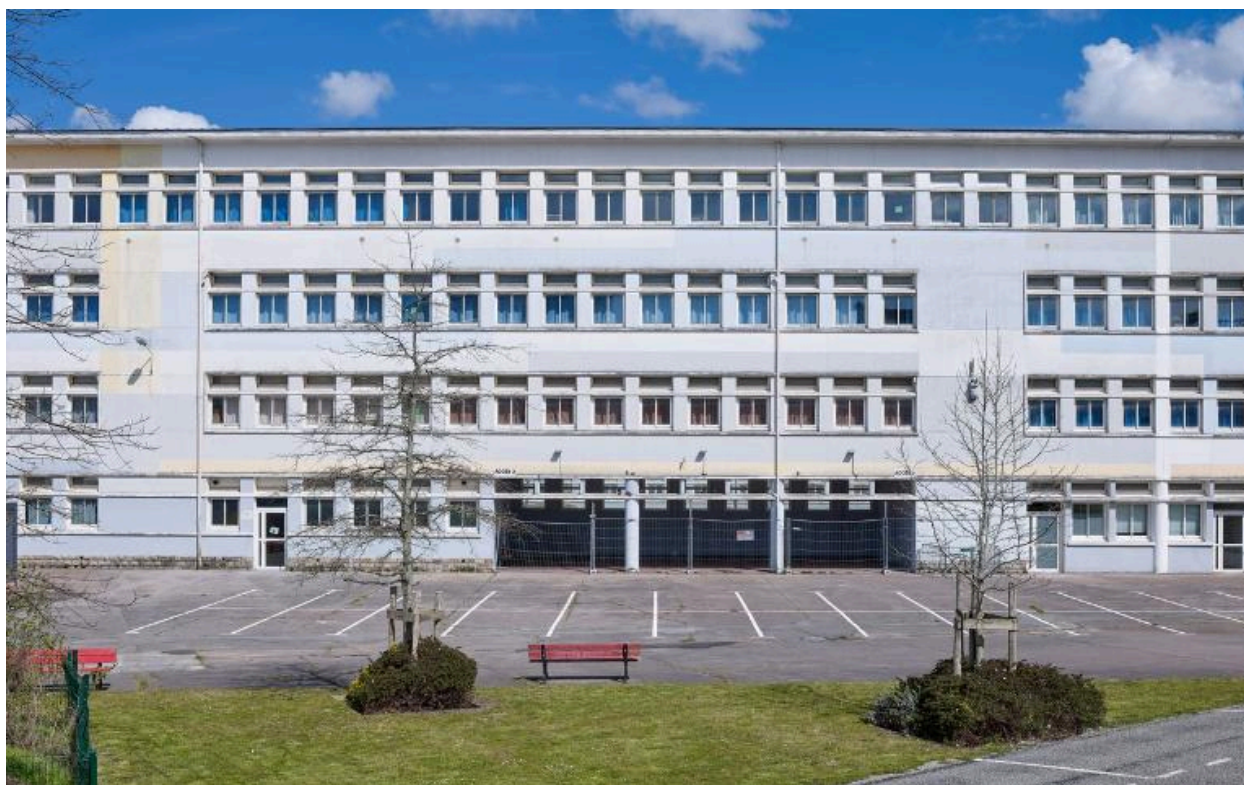
Bâtiment R, façade sud, partie centrale et préau. J-B. Mathon, architecte.
